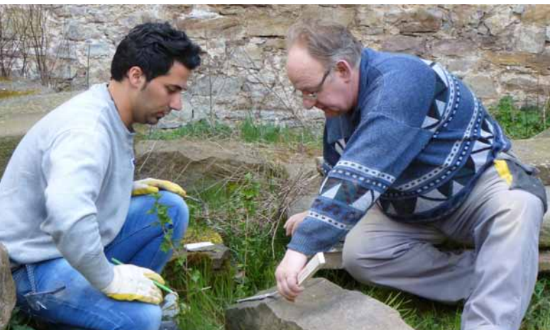
Integration durch gemeinsames Sanieren alter Fachwerkbauten im ausgezeichneten Projekt »Integrativer Ort BauDENKMAL« aus dem DBU-Sonderprogramm »Umwelt und Geflüchtete«
