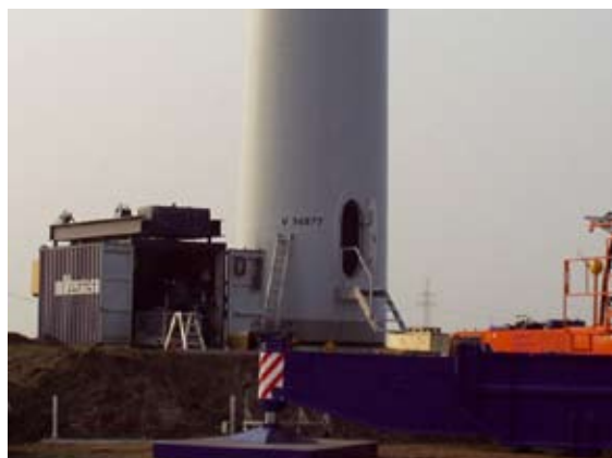
Windenergieanlage mit typischer Kennzeichnung, wie sie im Rahmen des Notfall-Informationssystems WEA-NIS vergeben wird.
