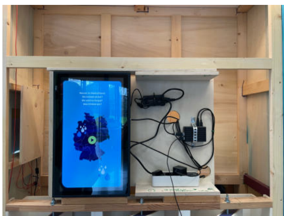
Elektronik hinter abgenommener Revisionsklappe
