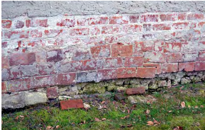
Sydow: abgänige Ziegelsteine durch erhöhten Grundwasserspiegel
