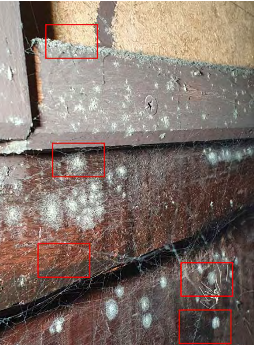
Schadensmerkmale wie Schimmel aus dem Xantener Dom
