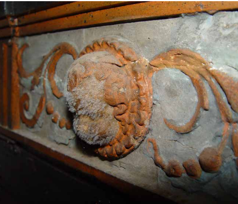
Detail einer mit Schimmel befallenen Oberfläche
