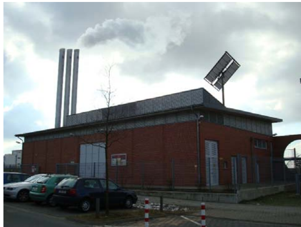
Blockheizkraftwerk der Stadtwerke Hannover AG Combined heat and power plant
