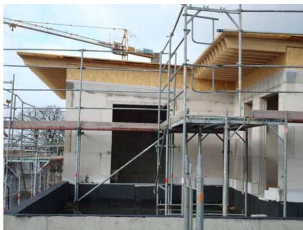
Dachwärmemedämmung bis zu 40 cm // Roof insulation up to 40 cm
