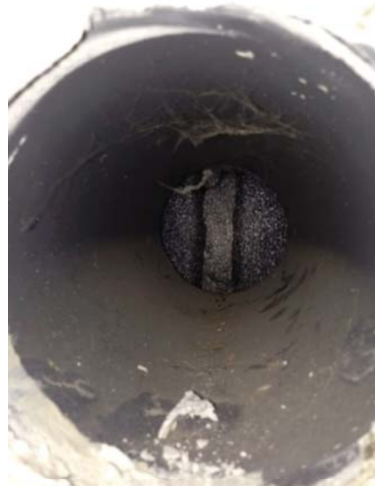
Abb. 36: Verbindungsstück zwischen Bad im OG und Fassadenkanal
