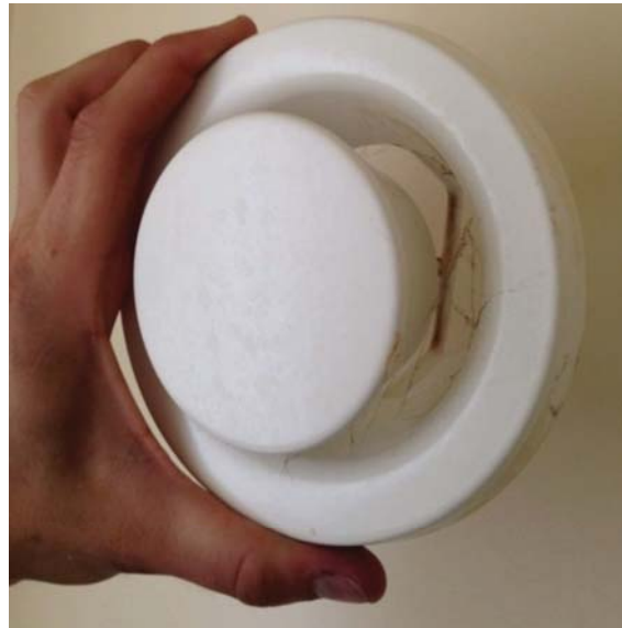
Abb. A 10: Teller Ventil im Bad OG
