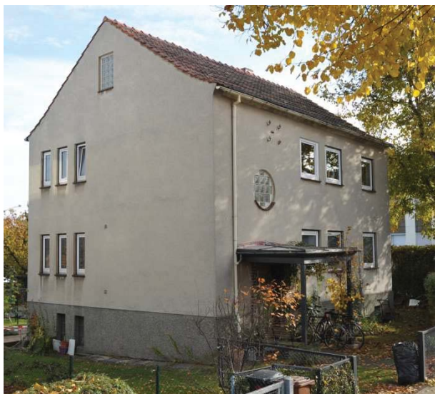
Abb. A 1: Nordwestansicht des Demonstrationsgebäudes vor der energetischen Sanierung
