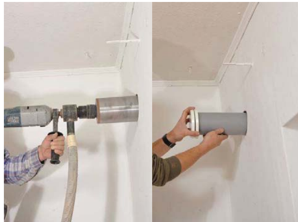
Abb. 4: Kernbohrung (links) und Einsetzen des Tellerventils zum Anschluss des Luftkanals an den Raum (rechts)
