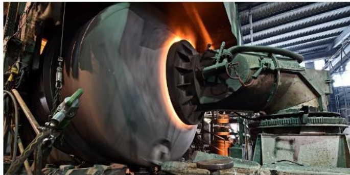
Trommelöfen mit Abwärmenutzung zur Eisenströmabzug. Copyright TRIMET Aluminium SE
