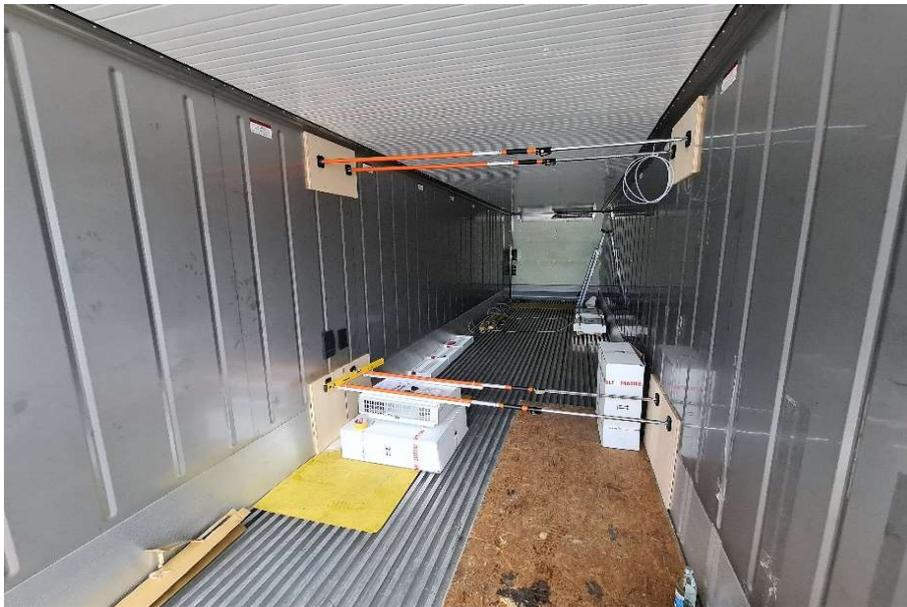
Abb. 3 Beginn der Umbauarbeiten im Container für den Schimmeleinsatz mit Ozongeneratoren.
