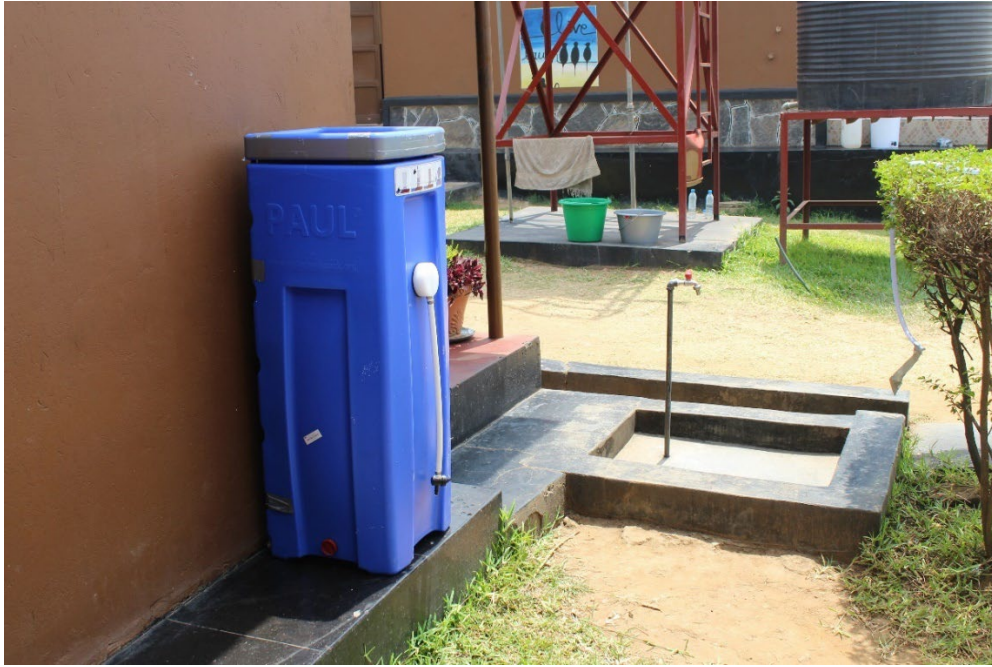
Abbildung 28: Einsatz des Wasserrucksack PAUL ® zur Vorbehandlung des Wassers auf dem Gelände des Vereins Lichtstrahl Uganda e.V. in Gulu
