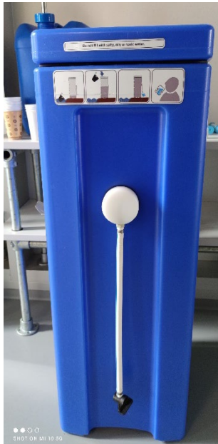
Abbildung 4: Wasserrucksack PAUL® - System und Aufbereitungseinheit (Membrane)
