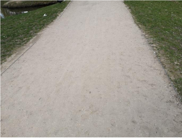
Abb. 47 Leipzig, Johannapark, Brücke am Inselteich, durch Bandeisenrasenkanten gefasste wassergebundene Deckschicht mit, Vegetation führt in Randbereichen zur Verkrautung (Zötzl, 2021)
