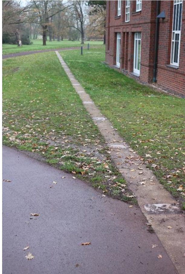
Abb. 116 Weg mit farblich gefasster Asphaltdeckschicht und Sockel für mobile Flutmauer (Benecken, 2022)
