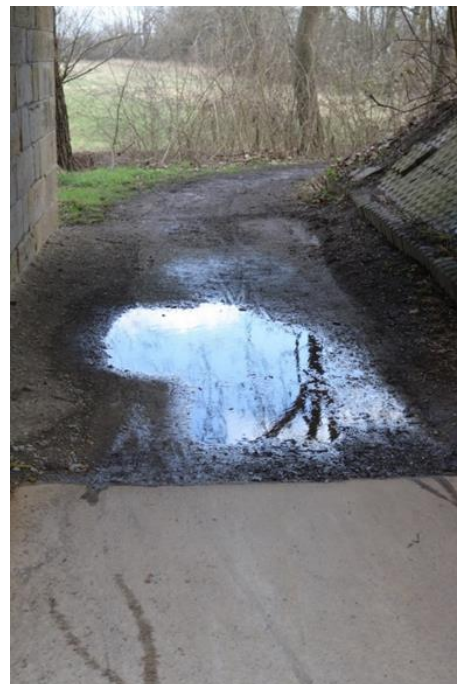
Abb. 135 Ende der Ausbaustrecke des Europaradweges vor der ehem. Eisenbahnbrücke über das Bodetal im östlichen Parkteil (Benecken,
