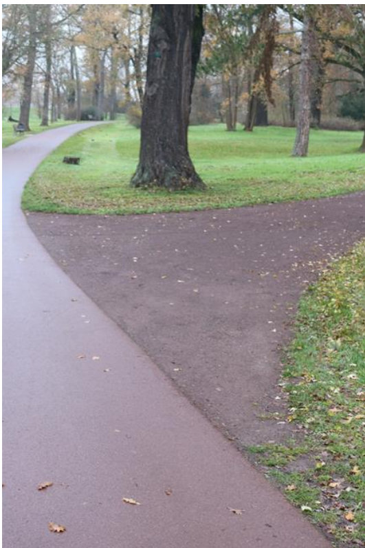
Abb. 117 Wege mit farblich gefasster Asphaltdeckschicht und rötlicher wassergebundener Deckschicht (Benecken, 2022)
