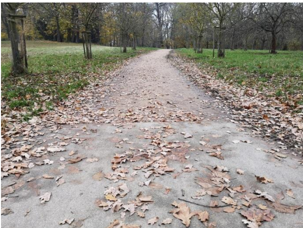
Abb. 81 Spurrinnen im Übergangsbereich zwischen epoxidharz- und wassergebundener Decke zeigen eine Nutzung durch zu breite und zu schwere Fahrzeuge (Zötzl, 2021)
