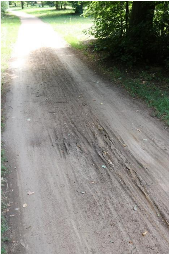
Abb. 165 Fahrradsprurrinnen in wassergebundener Wegedecke (Sommer 2022) (Benecken, 2022)
