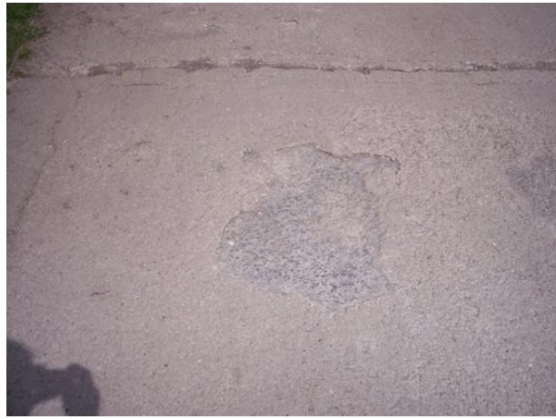
Abb. 52 Leipzig, Lene-Voigt-Park, große schollenartige Ablösungen der Oberflächen von epoxidharzgebundenen Deckschichten (Benecken, 2016)
