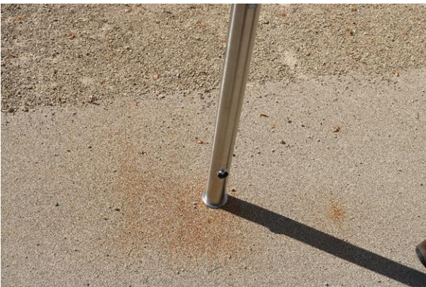
Abb. 175 zusätzlich Pigmentunregelmäßigkeiten um Pollerstandort in der epoxidharzgebundenen Deckschicht (Benecken, 2022)
