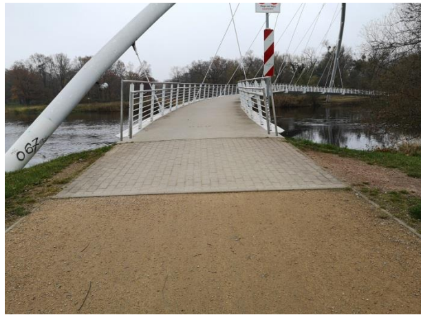
Abb. 88 Tiergartenbrücke, Blickrichtung Vorderer Tiergarten, wassergebundene Wegedecke mit Betonsteinfassung (Zötzl, 2021)
