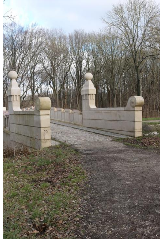
Abb. 146 Wegeanschluss südlich der westlichen Bodebrücke (Benecken, 2023)
