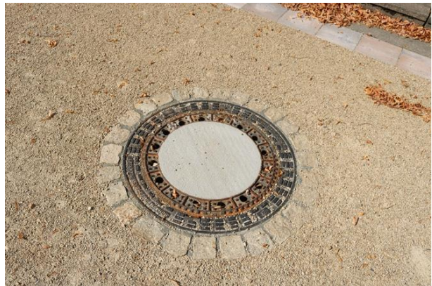
Abb. 178 im Vergleich zu Abb. 5, Kanaldeckel mit Betonfüllung in wassergebundener Deckschicht (Benecken, 2022)
