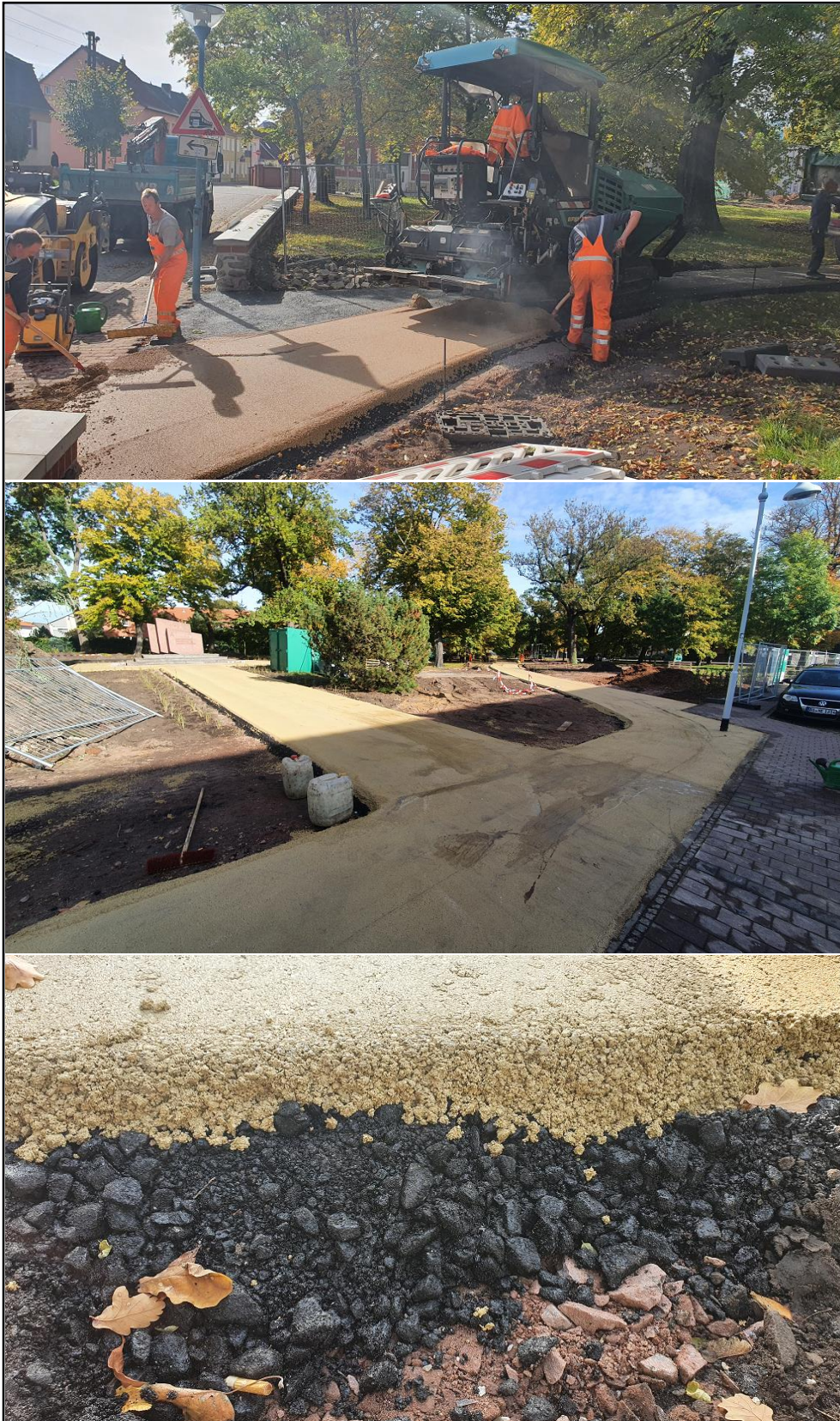
Abb. 2.3: Einbau des Baustoffgemisches BB2 in einer Parkanlage in Wolmirstedt [Bromberg, 2021]
