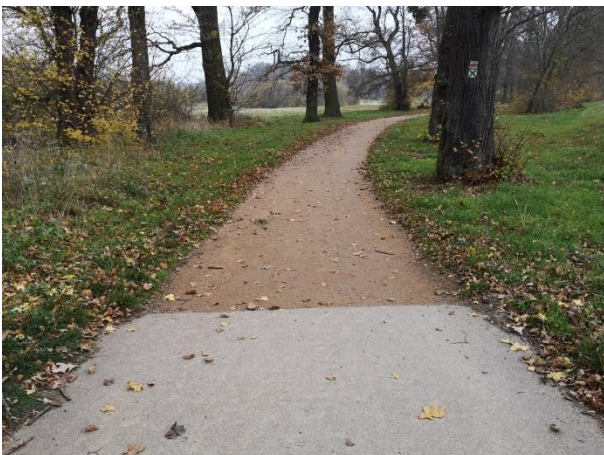
Abb. 68 Ende der Steigung und Übergang von der epoxidharzgebundenen Decke zur wassergebundenen Decke (Zötzl, 2021)
