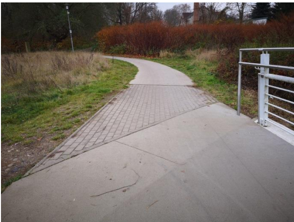
Abb. 89 Tiergartenbrücke, Blickrichtung Vorderer Tiergarten, Übergangsbereich Betonsteinpflaster, LUWADUR-Decke (Zötzl, 2021)
