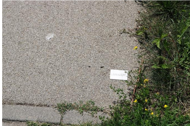
Abb. 170 Epoxidharzgebundene Wegedecke und seitliche Einfassungen (Sommer 2022) (Benecken, 2022)
