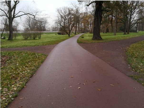
Abb. 13 Magdeburg, Herrenkrugpark, rötlich eingefärbte Asphaltdecke, Wegekrenz zum wassergebundenen Deckenaufbau (Zötzl, 2022)
