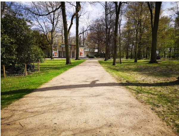
Abb. 39 Leipzig, Clara-Zetkin-Park, Blickrichtung Parkbühne, wassergebundene Deckschicht, nicht zur Vegetationsfläche begrenzt (Zötzl, 2021)
