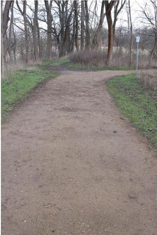
Abb. 137 wassergebundene Deckschicht ohne gebaute Kanteneinfassung und Bankett (Benecken, 2023)
