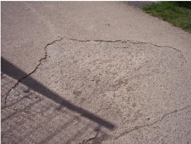
Abb. 51 Leipzig, Lene-Voigt-Park, große schollenartige Ablösungen der Oberflächen von epoxidharzgebundenen Deckschichten (Benecken, 2016)
