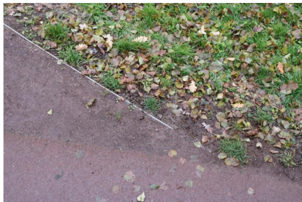
Abb. 116 Weg mit farblich gefasster Asphaltdeckschicht und Sockel für mobile Flutmauer (Benecken, 2022)
