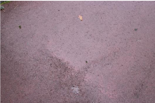
Abb. 121 Detail farblich gefasste Asphaltdeckschicht (Benecken, 2022)
