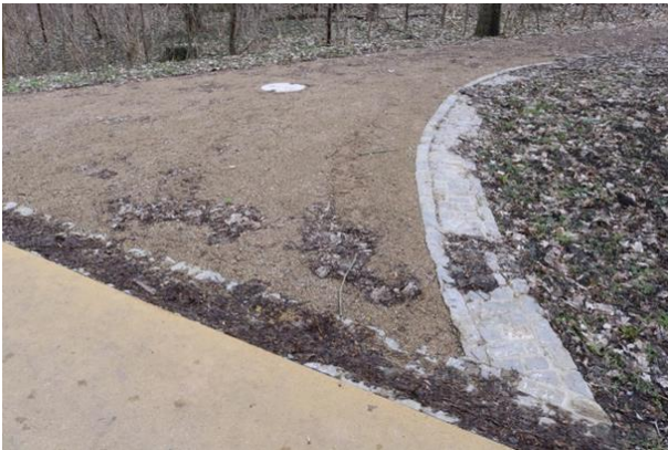
Abb. 126 Europaradweg mit eingefärbter Gussasphaltdeckschicht und Gerinne aus Granit-Kleinstein am Abstieg mit stärkerem Gefälle östlich des Schlosses Hohenerxleben zum Bodetal (Benecken, 2023)
