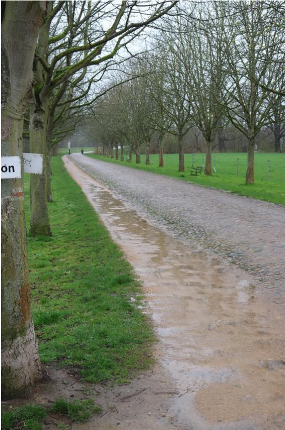
Abb. 187 Sanierter Sommerweg (wassergebundene Decke) östlich des Schlosses nach Regenerereignis (Benecken, 2023)
