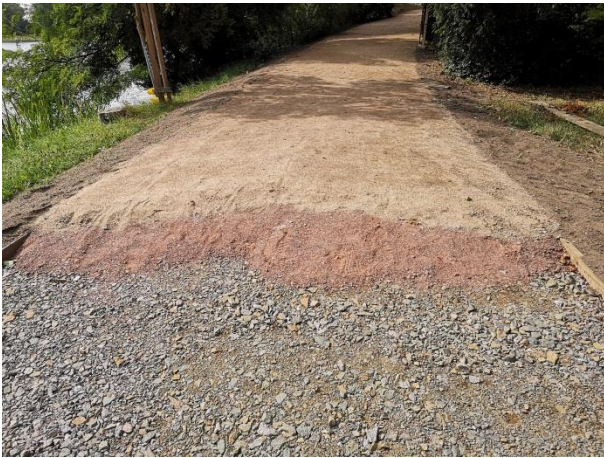
Abb. 103 Wörlitzer Park, Einbau einer wassergebundenen Wegedecke, Unterbau, Tragschicht und Deckschicht, August 2022. (Zötzl, 2022)
