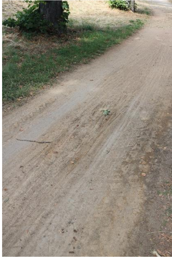
Abb. 164 Zustand wassergebunden befestigter Weg (Sommer 2022) (Benecken, 2022)
