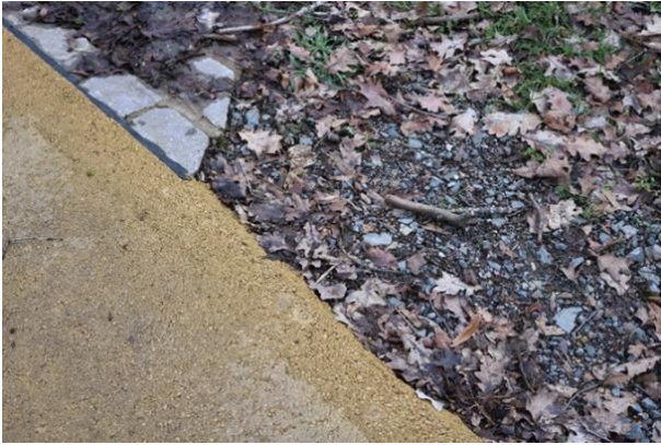
Abb. 130 Europaradweg (Gussasphalt) und angrenzende Fläche eines Sitzplatzes mit einer wassergebundenen Wegedeckschicht (Benecken, 2023)
