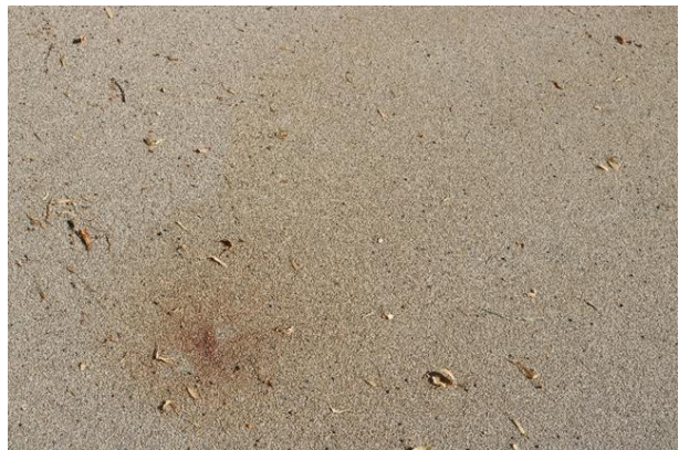
Abb. 176 Pigmentunregelmäßigkeit an einer Störung unter der epoxidharzgebundenen Deckschicht (Benecken, 2022)
