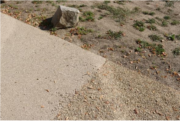
Abb. 173 Übergang wassergebundene Wegedecke – Asphaltdecke mit epoxidharzgebundener Abstreifung, Wegeeinfassung aus Bandeisenkante (Sommer 2022) (Benecken, 2022)
