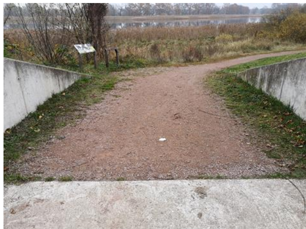
Abb. 55 Kühnauer Park, Deichquerung Nähe der Kirche in der Burgkühnauer Straße, Ausführung mit wassergebundener Decke, Vegetation führt in Randbereichen zur Verkräutung (Zötzl, 2021)
