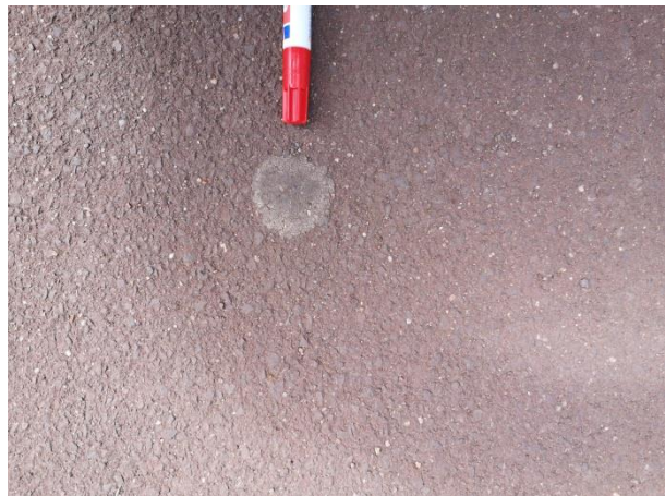
Abb. 10 Magdeburg, Rotehornpark, mit einem ausgeblichenem Material reparierte Löcher im Asphalt (Zötzl, 2021)
