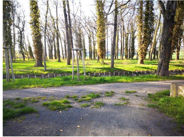
Abb. 38 Gutspark Großjena, wassergebundene Deckschicht, ohne Wegekanten, beginnende Verkräutung im Kreuzungsbereich (Zötzl, 2021)
