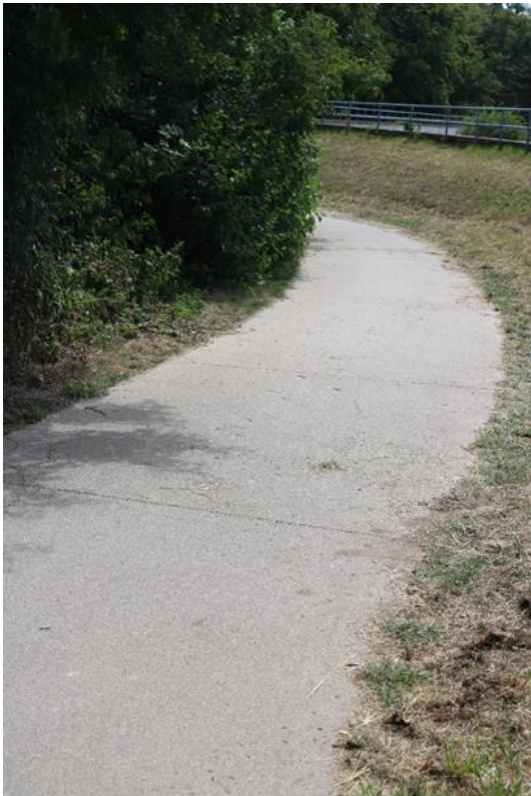
Abb. 157 Gefällestrecke nach Deichquerung östlich Großkühnau (epoxidharzgebunden) (Benecken, 2022)
