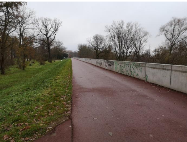
Abb. 15 Magdeburg, Herrenkrugpark, rötlich eingefärbte Asphaltdecke im Deichbereich (Zötzl, 2022)
