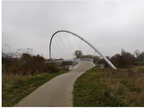
Abb. 94 Tiergartenbrücke, mit LUWADUR ausgeführte Steigung (Zötzi, 2021)
