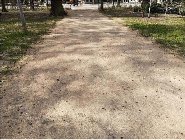
Abb. 41 Leipzig, Clara-Zetkin-Park, Blickrichtung Glas-haus, wassergebundene Deckschicht, nicht zur Vegetationsfläche begrenzt (Zötzl, 2021)
