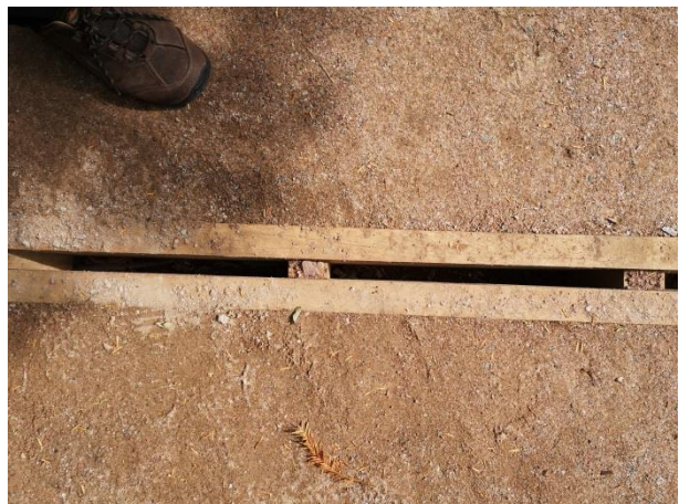
Abb. 106 Wörlitzer Park, wassergebundenen Wegedecke, Deckschicht. Einbau einer Wasserableitung (Querschlag) aus Holz. August 2022. (Zötzl, 2022)
