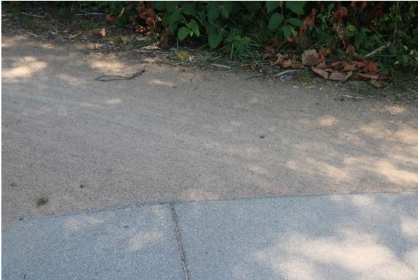
Abb. 169 Epoxidharzgebundene Deckschicht mit Übergang zur wassergebundenen Wegedecke (Benecken, 2022)
