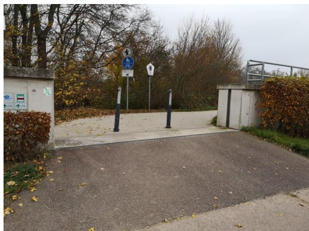
Abb. 57 Kühnauer Park, Elberadweg, Abschnitt „Fürst Franz“, Deichquerung in der Burgkühnauer Straße, Ausführung von Deichquerung und Steigungsbereich in LUWADUR (Zötzl, 2021)
