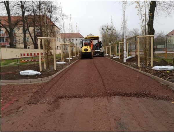
Abb. 95 Magdeburg, Pappelallee, Einbau der Trag-schicht (Zötzl, 2020)
