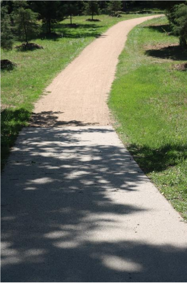
Abb. 167 Übergang wassergebunden befestigter zu epoxidharzgebunden befestigtem Wegeabschnitt (Weinberg, Sommer 2022) (Benecken, 2023)
