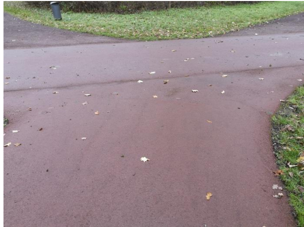
Abb. 14 Magdeburg, Herrenkrugpark, rötlich eingefärbte Asphaltdecke, Wegekrenz mit Anschluss an weitere Asphaltdecke (Zötzl, 2022)
