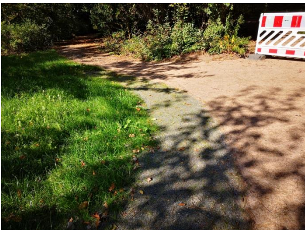
Abb. 105 Wörlitzer Park, wassergebundenen Wegedecke, Deckschicht. Einbau von Rasengittersteinen im Seitenbereich. (Zötzl, 2022)
