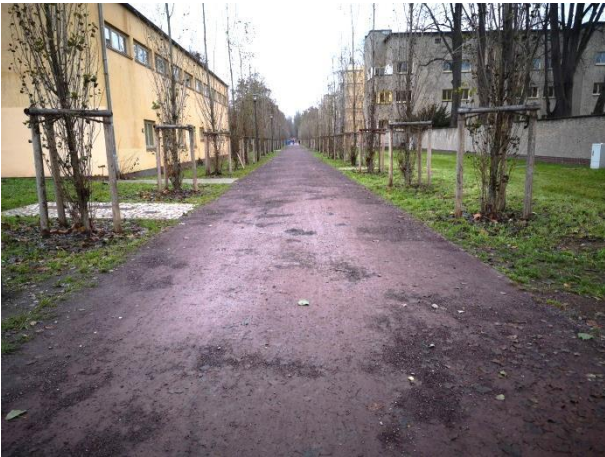
Abb. 99 Magdeburg, Pappelallee, Monitoring im Winter 2022, Einbau der Tragschicht (Zötzl, 2022)
