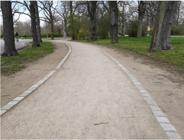
Abb. 43 Leipzig, Clara-Zetkin-Park, Weg parallel zur Anton-Bruckner-Allee, wassergebundene Deckschicht, Wegeingrenzung durch Schlackesteine (Zötzl, 2021)
