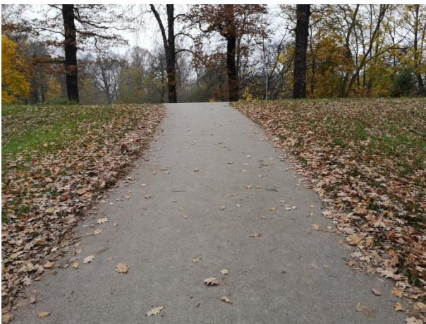
Abb. 75 Im Steigungsbereichen und Wegequerungen eingesetzte LUWADUR-Decke (Zötzl, 2021)
