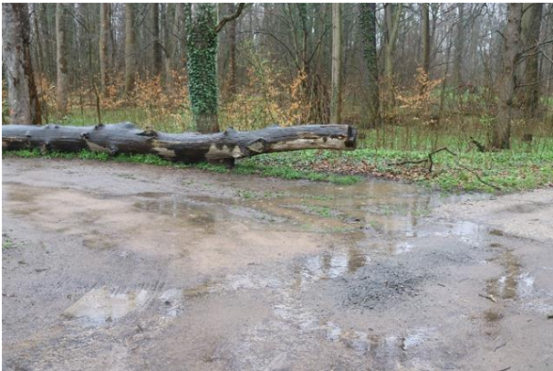
Abb. 185 Unsanierter Wegeabschnitt nach Regenereignis, rechts Ansatz Wandkiesdecke (Benecken, 2023)
