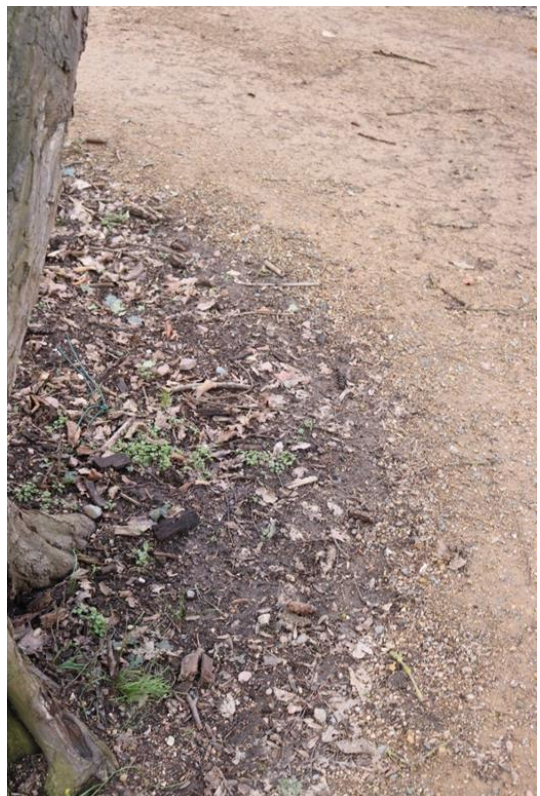
Abb. 140 Detail Wegekante ohne gebaute Abgrenzung im Bereich von Gehölzbeständen (Hainbuchenallee) (Benecken, 2023)
