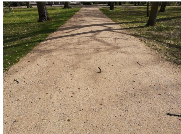
Abb. 40 Leipzig, Clara-Zetkin-Park, zwischen Glashaus und Parkbühne, wassergebundene Deckschicht, nicht zur Vegetationsfläche begrenzt mit Humusauflagen (Zötzl, 2021)
