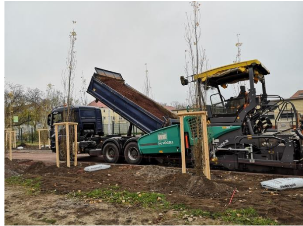
Abb. 96 Magdeburg, Pappelallee. Einbau der Trag-schicht mit Straßenbautechnik (Zötzl, 2020)
