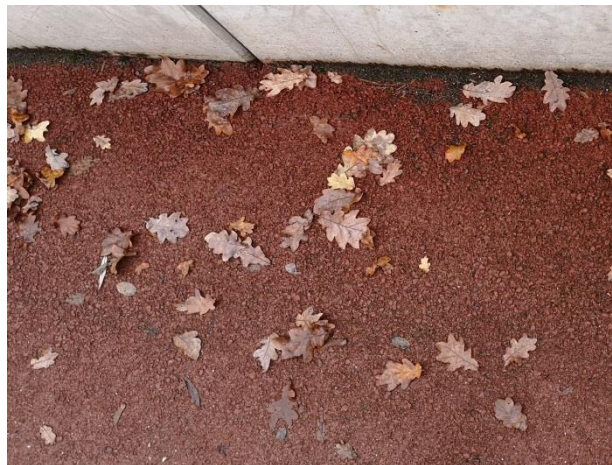
Abb. 16 Magdeburg, Herrenkrugpark, stark rot eingefärbte Asphaltdecke, Deichbereich (Zötzl, 2022)
