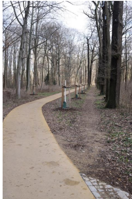
Abb. 129 Verschwenk des Europaradweges aus dem historischen Verlauf des Parkweges (Eichenallee) heraus, dort wassergebundene Deckschicht (Benecken, 2023)
