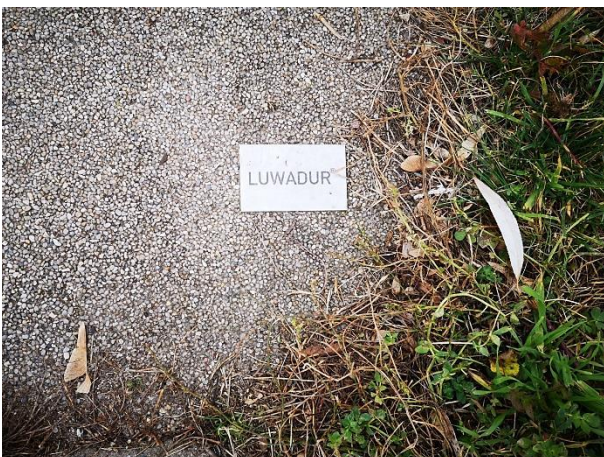
Abb. 91 Tiergartenbrücke, LUWADUR-Decke mit Markensiegel (Zötzl, 2021)
