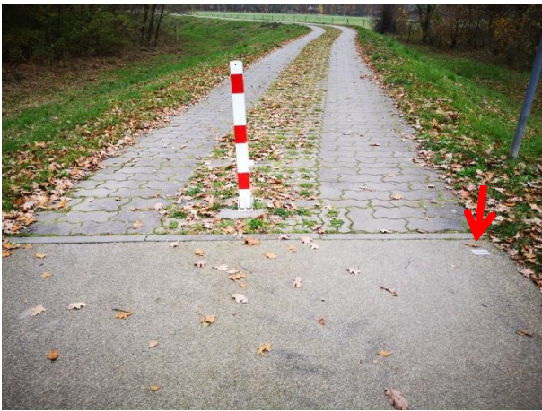
Abb. 77 Im Bereich der Wegequerung des Deichwegs aus Betonsteinverbundpflaster eingesetzte LUWADUR-Decke mit Markensiegel (Zötzl, 2021)
