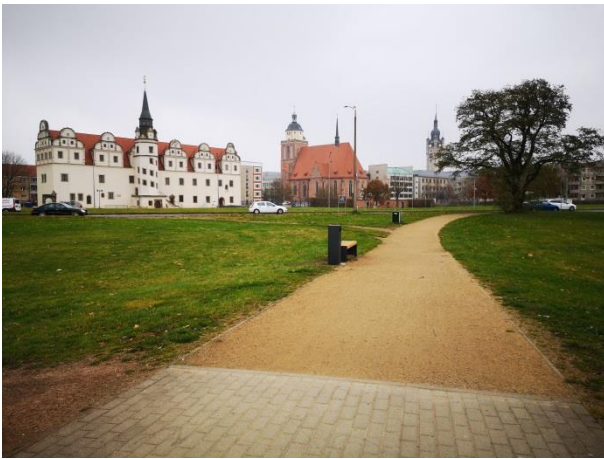
Abb. 87 Tiergartenbrücke, Blickrichtung Innenstadt, wassergebundene Wegedecke mit Betonsteinfassung (Zötzl, 2021)
