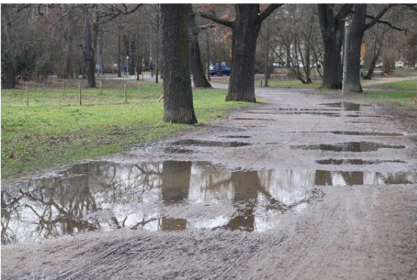
Abb. 147 Aufgeweichte Deckschicht und Pfützenbildung unmittelbar nach Frost-Tau-Wechsel auf einem unsanierten Hauptwegeabschnitt (Februar 2023) (Benecken, 2023)
