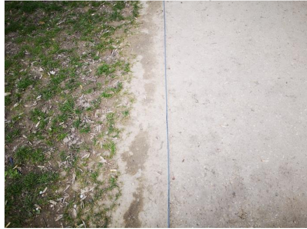
Abb. 48 Leipzig, Johannapark, Brücke am Inselteich, durch Bandeisenrasenkanten gefasste wassergebundene Deckschicht mit, Austrag den Materials über die Rasenkante in die Vegetationsfläche (Zötzl, 2021)
