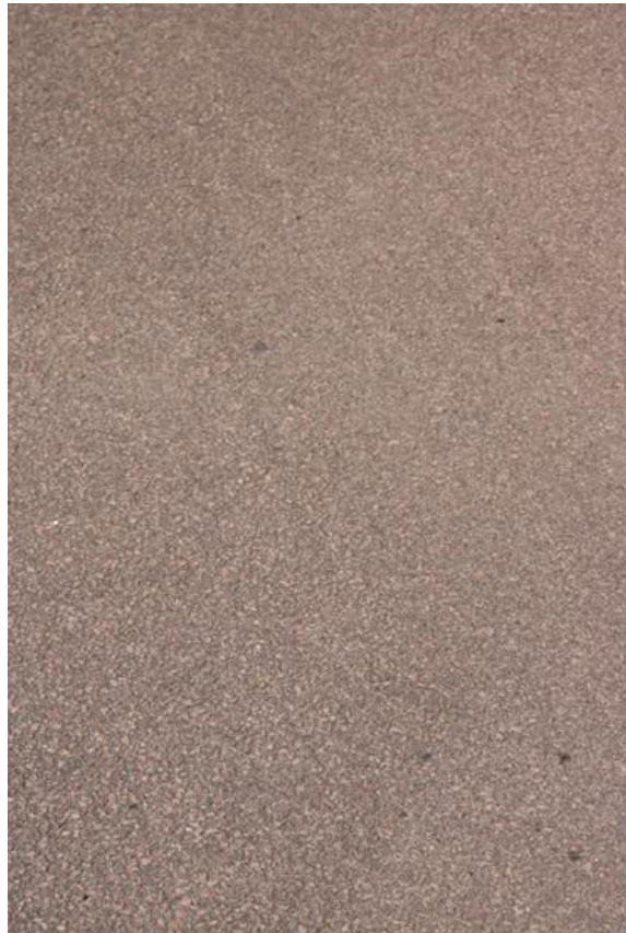
Abb. 166 Detail epoxidharzgebunden befestigte Wegedecke (Sommer 2022) (Benecken, 2022)
