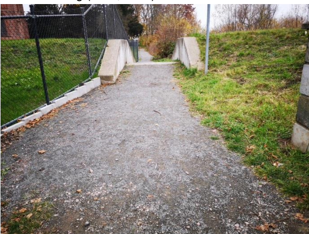
Abb. 56 Deichquerung direkt an der Kirche in der Burgkühnauer Straße, Ausführung mit wassergebundener Decke (Zötzl, 2021)
