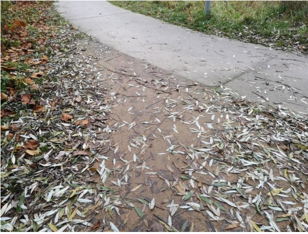
Abb. 93 Tiergartenbrücke, Übergangsbereich wasser-gebundene Decke zur LUWADUR-Decke (Zötzi, 2021)
