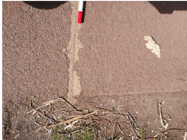
Abb. 8 Magdeburg, Rotehornpark, rote Asphaltdecke, zwei extra gefertigte Abschnitte mit ausgeblichenem Trennfuge (Zötzl, 2021)
