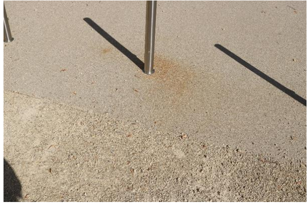
Abb. 174 wie Abb. 173, zusätzlich Pigmentunregelmäßigkeiten um Pollerstandort in der epoxidharzgebundenen Deckschicht (Benecken, 2022)
