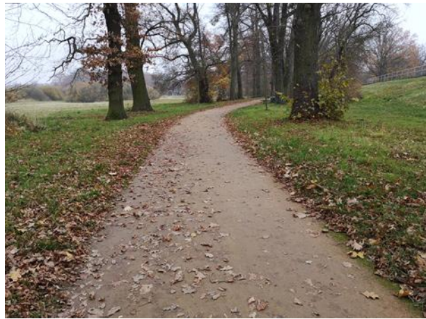
Abb. 71 Bereich der wassergebundenen Decke mit Spurrinnen und anschließender Pfützenbildung (Zötzl, 2021)
