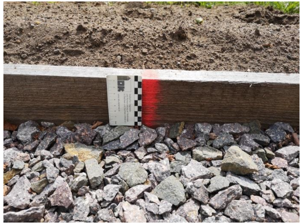
Abb. 104 Wörlitzer Park, Einbau einer wassergebundenen Wegedecke, Unterbau, Begrenzung aus Holz, August 2022. (Zötzl, 2022)
