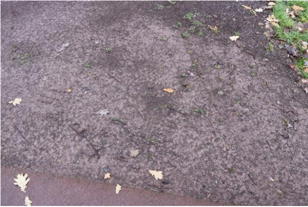
Abb. 119 Übergang farblich gefasste Asphaltdeckschicht und rötliche wassergebundene Deckschicht (Benecken, 2022)
