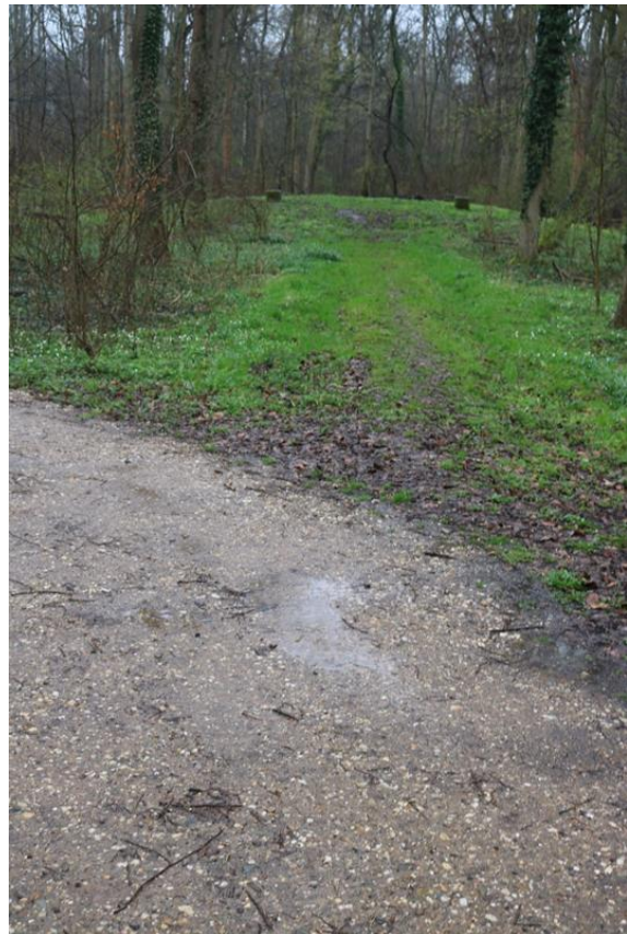
Abb. 182 Wandkiesdecke am Übergang zu einem unbefestigten Wegebereich (Benecken, 2022)
