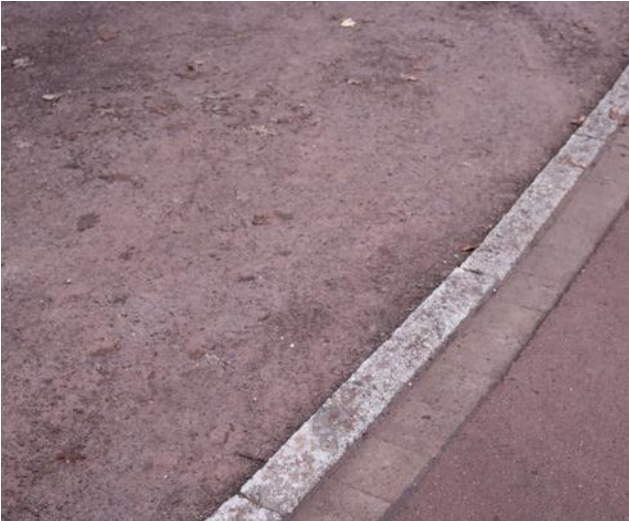
Abb. 125 farblich gefasste Asphaltdeckschicht mit Gerinne, Bordsteinkante und anschließender rötlicher wassergebundener Wegedeckschicht (Benecken, 2023)
