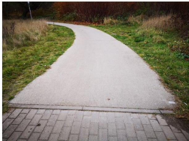
Abb. 90 Tiergartenbrücke, Blickrichtung Vorderer Tiergarten, Übergangsbereich Betonsteinpflaster, LUWADUR-Decke im Steigungsbereich (Zötzl, 2021)
