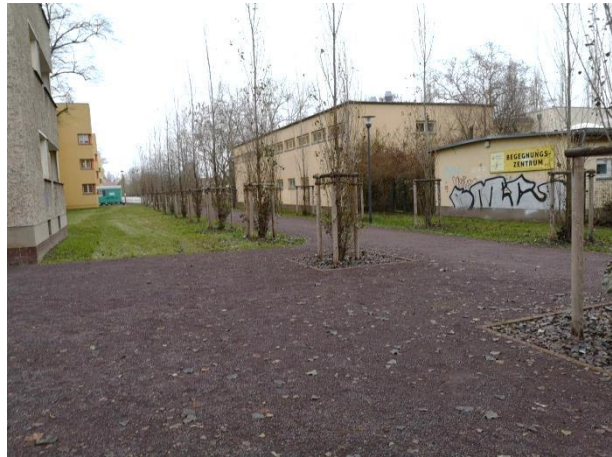
Abb. 100 Magdeburg, Pappelallee, Monitoring im Winter 2022, Einbau der Tragschicht (Zötzl, 2022)
