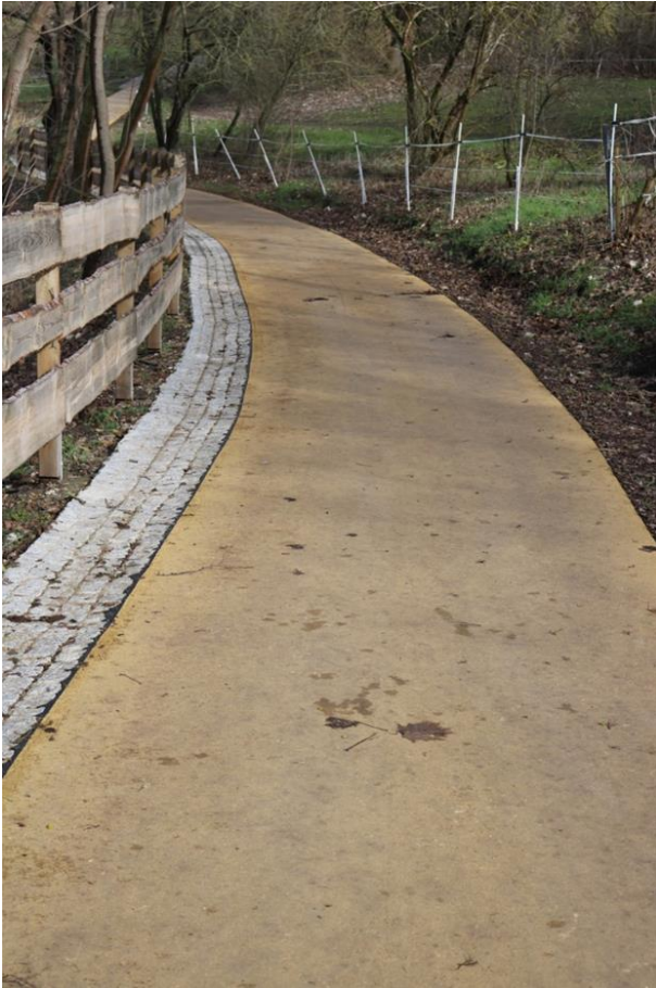
Abb. 126 Europaradweg mit eingefärbter Gussasphaltdeckschicht und Gerinne aus Granit-Kleinstein am Abstieg mit stärkerem Gefälle östlich des Schlosses Hohenerxleben zum Bodetal (Benecken, 2023)
