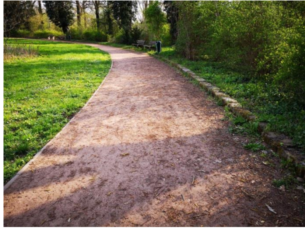
Abb. 30 Halle, Gimritzer Park, wassergebundene Deckschicht, Humusauflage. (Zötzl, 2021)
