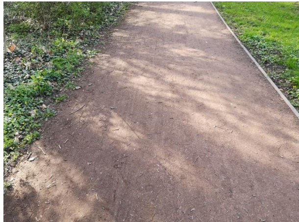
Abb. 26 Halle, Gimritzer Park, wassergebundene Deckschicht: Links: Übergreifen der Vegetation in nicht begrenzten Bereichen auf den Weg (Zötzl, 2021)
