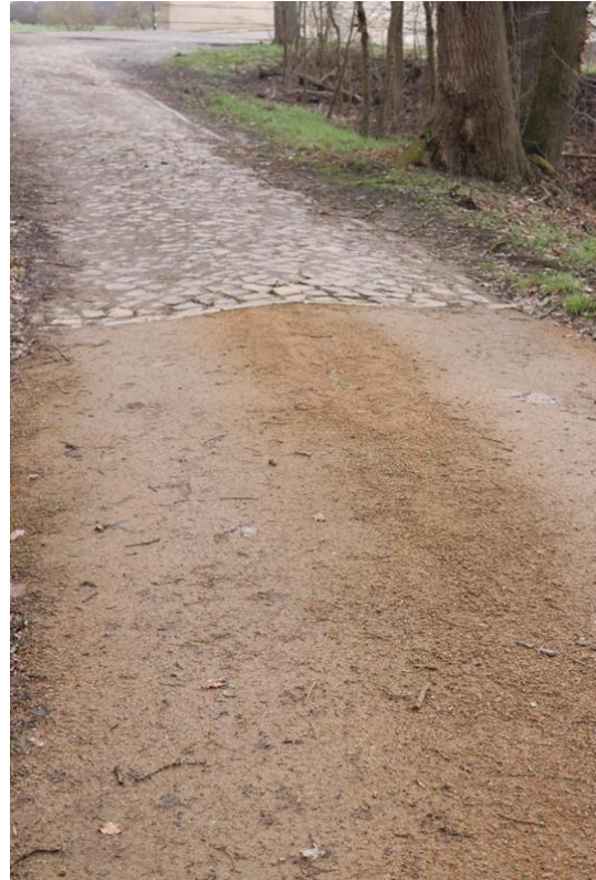
Abb. 142 Übergang von der wassergebundenen Wegedecke zur Feldsteinpflasterung vor der mittleren Bodebrücke (Benecken, 2023)
