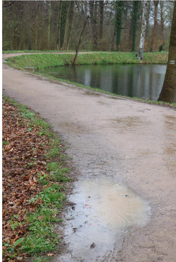
Abb. 184 Wassergebundene Wegedecke (Tegra) nach Regenereignis, Detail (Benecken, 2023)
