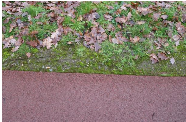
Abb. 122 Asphaltdeckschicht, Wegekante (Benecken, 2022)
