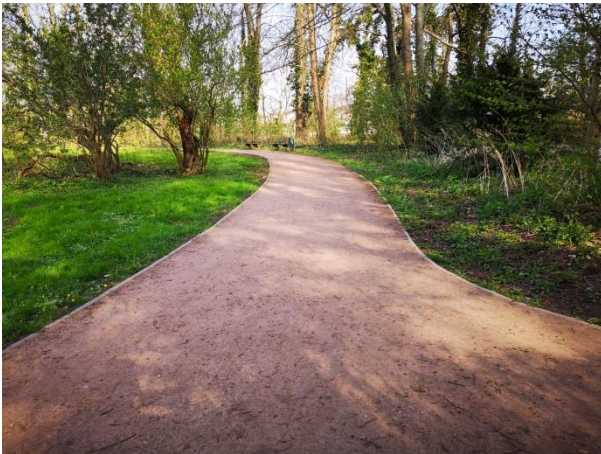
Abb. 25 Halle, Gimritzer Park, wassergebundene Deckschicht mit einer nahezu durchgängigen Betonsteineinfassung (Zötzl, 2021)
