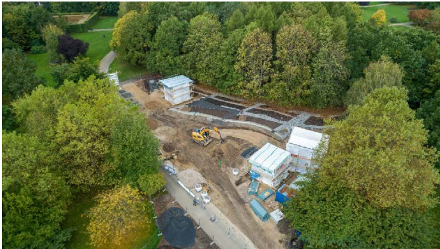
Der Jüdische Garten in den Gärten der Welt; Baustelle im Oktober 2020
