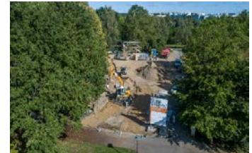
August 2020, Ansicht von Süden
