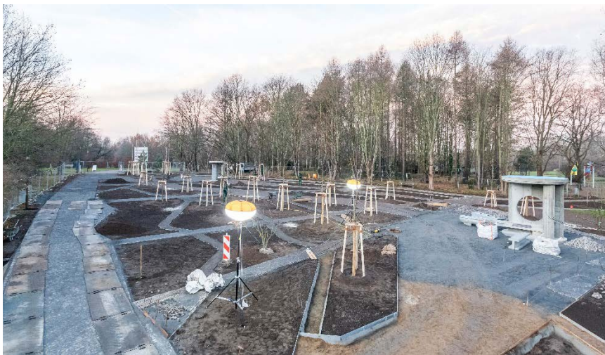
Fertigstellung der Wege- und Platzflächen im Dezember 2020
