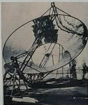
Solarthermieanlage von Adolf Kersch. Anmerkung: Technik und Mensch im Jahre 2000, München 1027, S. 262.
