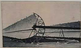
Die Spiegel der Solarthermieanlage hier unten gesehen.
