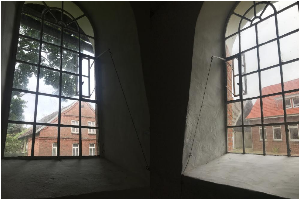
Abb. 5: Lüftungsfenster im Altarbereich an der Süd- (link) und Nord-Seite (rechts)
