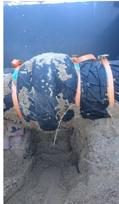
**Abbildung 6-24: dritte sanierte Schadstelle**
