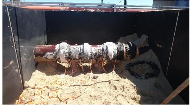
**Abbildung 6-21: frei gelegte Schadstelle mit gelösten Spanngurten und soweit es möglich war gelöstem Vlies**
