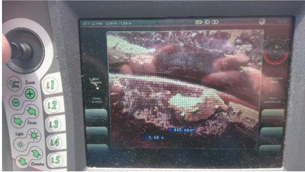
**Abbildung 6-30: nicht ausgefüllter Muffenspalt nach der Sanierung**
