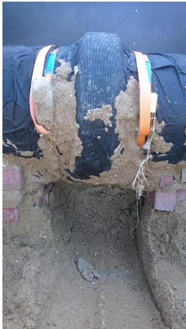
**Abbildung 6-22: erste sanierte Schadstelle**
