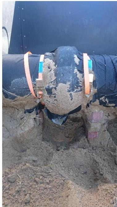
**Abbildung 6-23: zweite sanierte Schadstelle**
