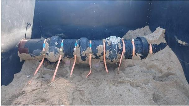
**Abbildung 6-20: frei gelegte Schadstellen mit Vlies und Spanngurten**
