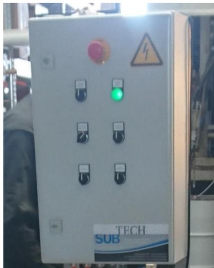
Abbildung 1-7: Steuereinheit für Bevorratung- und Pumpeinheit
