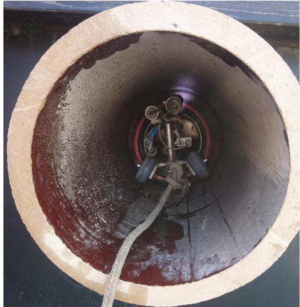
**Abbildung 6-19: Sanierung der ersten Schadstelle
