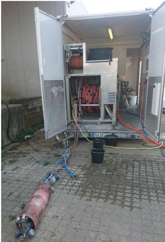
**Abbildung 6-15: Sanierungsanhänger mit Schlauchtrommeln und DN 300 Packer**
