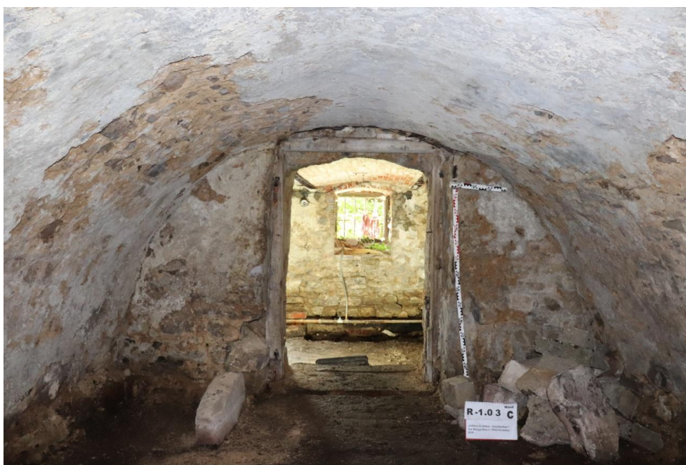
Foto-Nr. -1.03_1: Wand c _ Übersicht, südl. Außenwand des mittelalterl. Baus Foto-Nr. -1.03_4: Wand a _ Übersicht, nördl. Außenwand des mittelalterl. Baus
