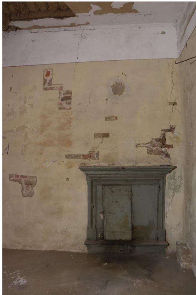
Foto-Nr. 2.01_4: Wand c (Übersicht 3): Innenwand aus Ziegel und Kalkmörtel; mit Befund 2
