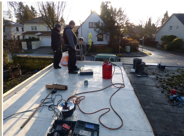
Foto 2: Verlegen einer herbizidfreien Dach- und Wurzeldichtung auf einem Garagendach (Gerd Wach).
