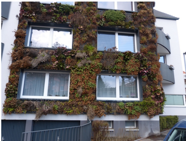
Foto 15: 2013 wurde dieses Wohnhaus von der Firma Gundlach saniert und auf der Südseite eine wandgebundene Fassadenbegrünung angebracht (Gerd Wach).
