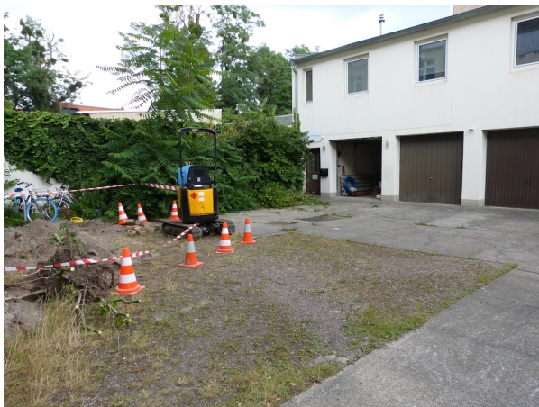
Foto 17: Die triste Hoffläche bevor 140 qm Betonboden geöffnet und entsiegelt wurden (Jana Lübbert).
