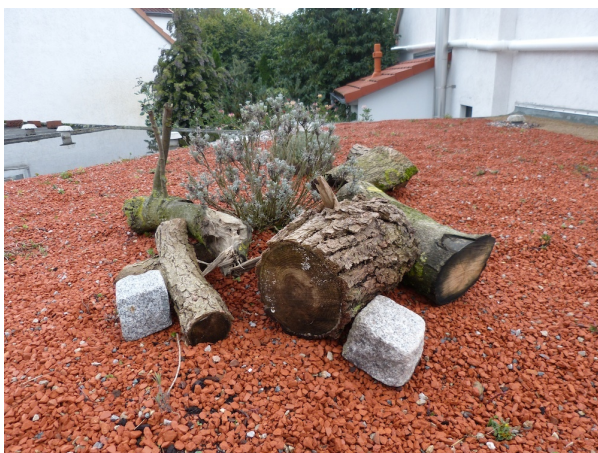
Foto 13: Frisch angelegtes Dachbegrünung mit Totholz für Wildbienen (Jana Lübbert).
