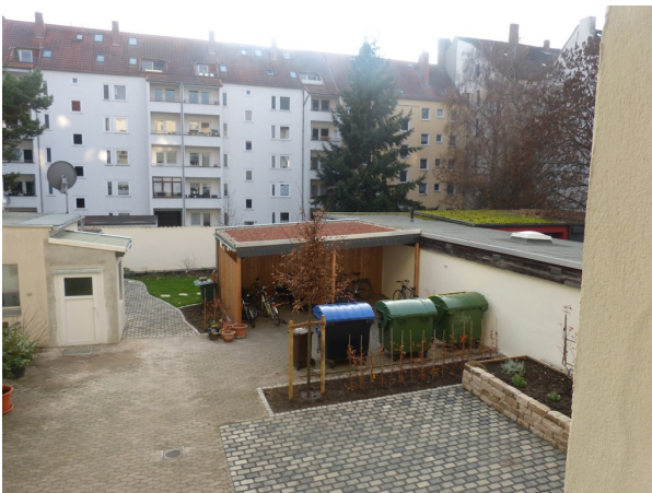
Foto 1: Nach der Entsiegelung wurden 75 qm des Hofes begrünt und weitere 65 qm über Rasenfugenpflaster versickerungsfähig (Gerd Wach).
