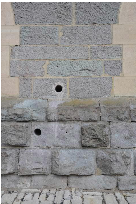
Abbildung 142: Testfläche A an der Südfassade vor Beginn der Bearbeitung
