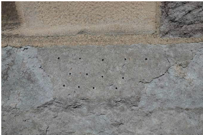
Abbildung 152: Rasterförmiges Anbohren einer Schale für Injektageöffnungen zum Hinterkleben / Hinterfüllen
