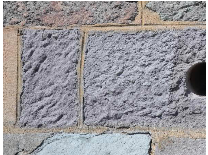
Abbildung 156: Schlämmenauftrag auf zwei benachbarten Steinoberflächen: Während die Schichtdicke links zu hoch und daher ein „Verschmieren“ der Oberfläche festzustellen ist, lassen sich im Stein vorhandene Oberflächenstrukturen bei dünnschichtigerem Auftrag (im Bild rechts) deutlicher erkennen.
