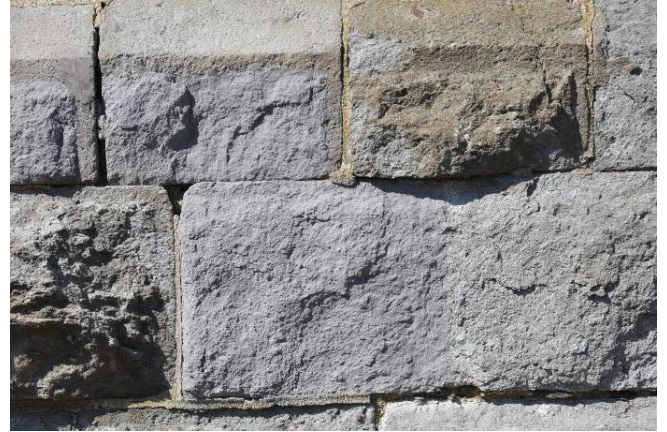
Abbildung 164: Werkstück aus Abbildung 163 nach dem Auftrag der Schlämme (nur im linken Teil der Fläche)
