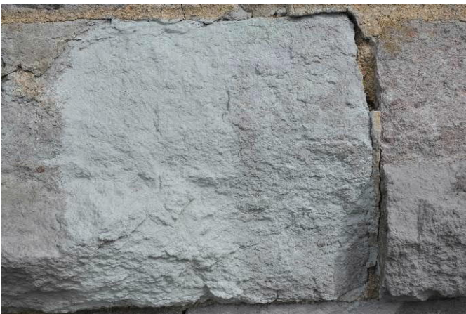
Abbildung 161: Teil der geschlämmten Oberfläche aus Abbildung 160 mit anschließend überstrahltem Bereich (Teilfläche rechts): Hier entstand durch die Überarbeitung eine sehr unruhige Flächenwirkung.
