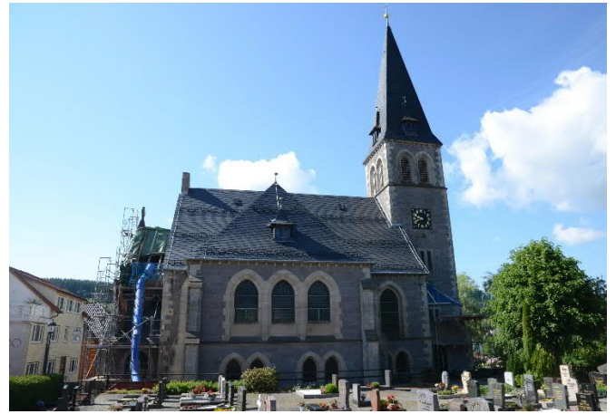
Abbildung 4: Ansicht der Nordfassade der jetzigen Kirche
