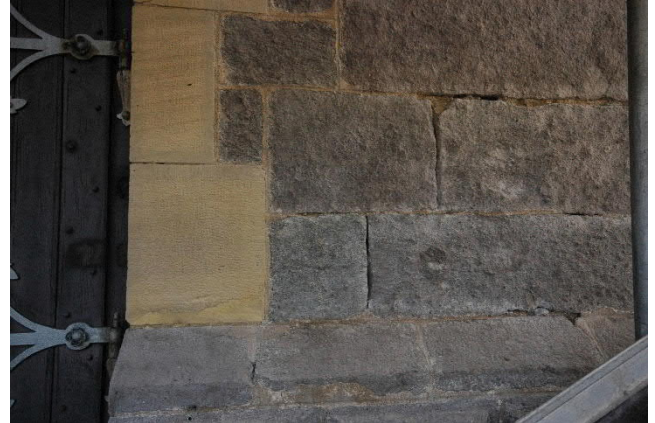
Abbildung 176: Fassadenfläche an Nordseite des Turmanbaues nach Reinigung, dem Ausräumen der Fugen und der partiellen Festigung.
