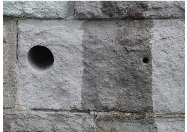
Abbildung 166: Befeuchtung einer Teilfläche des Werkstückes aus Abbildung 164: Steinoberfläche und Schlämme sind auch hier ohne großen farblichen Kontrast.
