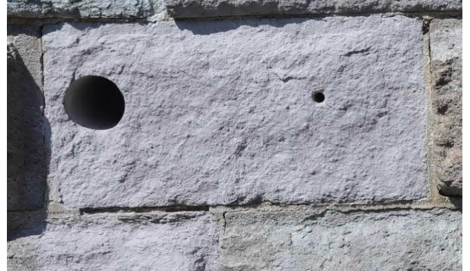
Abbildung 158: Werkstück aus Abbildung 157 nach dem Auftrag der Schlämme
