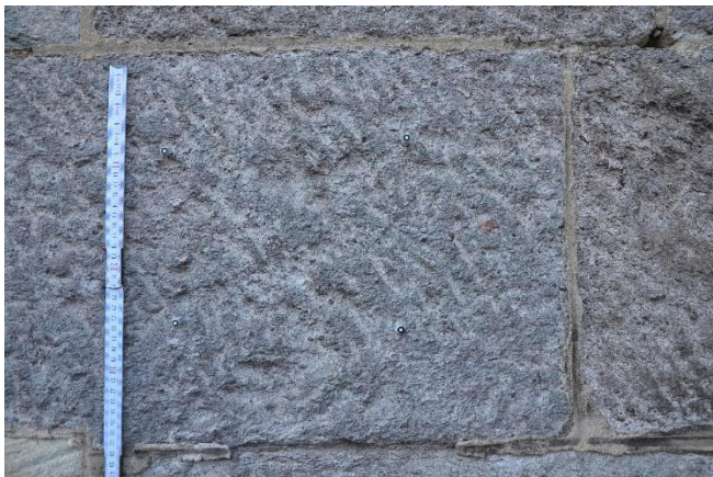
Abbildung 188: Messfläche 3 vor der Reinigung (violettgraue Variation, sehr gut erhaltene Oberfläche mit Bearbeitungsspuren)
