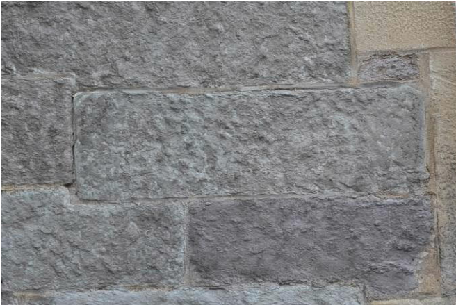
Abbildung 170: Gleicher Bereich wie Abbildung 168 nach Lasur
