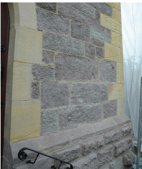
Abbildung 179: Unterer Bereich der Nordfassade nach Fertigstellung der Maßnahmen
