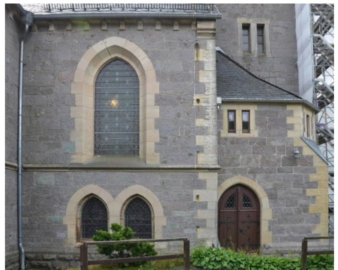
Abbildung 180: Westlicher Teil der Nordfassade (unbearbeitet, links im Bild) und Nordfassade des Turmanbaues nach Fertigstellung der Maßnahmen (rechts im Bild) im Vergleich
