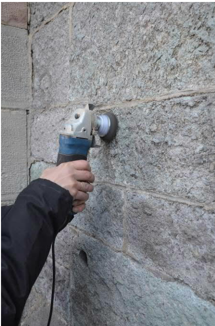
Abbildung 148: Bearbeitung der bereits partikelgestrahlten Testfläche an der Nordseite mittels Tellerbürste
