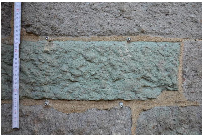
Abbildung 190: Messfläche 4 vor der Reinigung (grünfarbene Variation, sehr gut erhaltene Oberfläche mit Bearbeitungsspuren)
