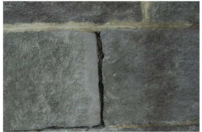
Abbildung 178: Fassadendetail Mörtelergänzung einer Fugenflanke und dünnsschichtig ausgeführtem Schlämmen der Steinoberflächen
