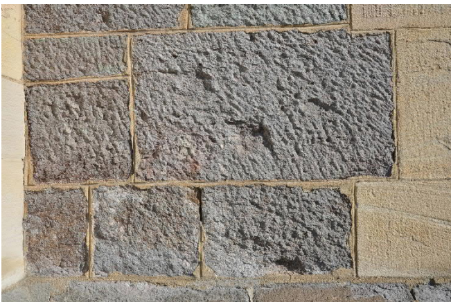
Abbildung 171: Teil des Fassadenmauerwerkes an der Südfassade (Testfläche B) vor Auftrag der Schlämme
