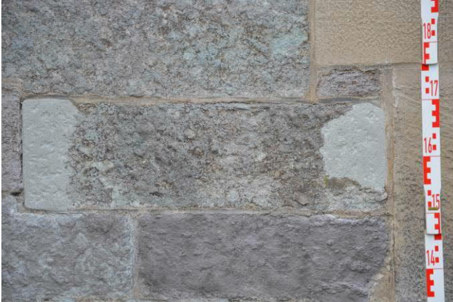
Abbildung 168: Mörtelergänzungen von Fehlstellen nach der Überarbeitung (Testfläche D)
