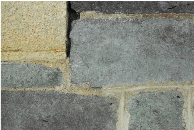
Abbildung 177: Fassadendetail nach partieller Neuverfugung
