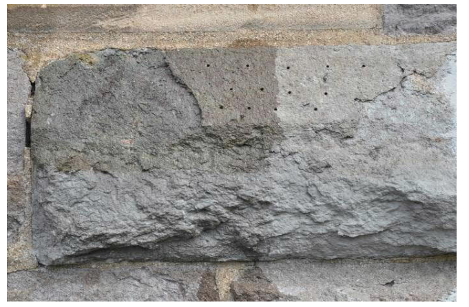
Abbildung 162: Befeuchtung einer Teilfläche des Werkstückes aus Abbildung 161: Steinoberfläche und Schlämme sind bei Befeuchtung ähnlich stark gedunkelt – eine starke Kontrastwirkung tritt nicht auf.
