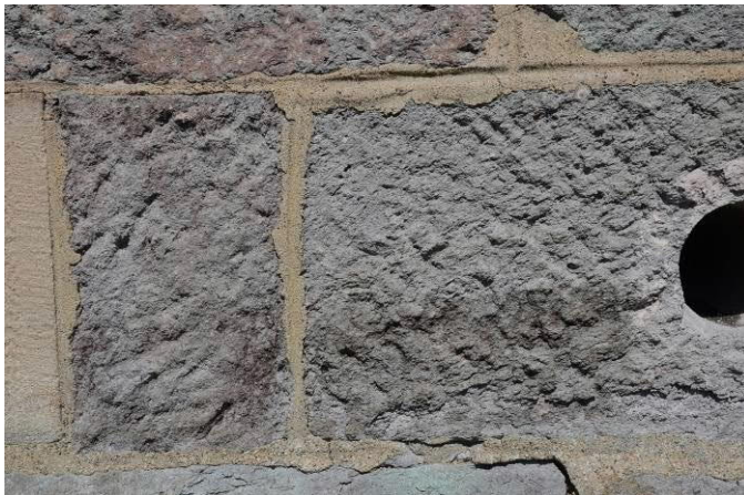
Abbildung 155: Detail des Fassadenmauerwerks der südseitigen Testfläche vor Auftrag der Schlämme
