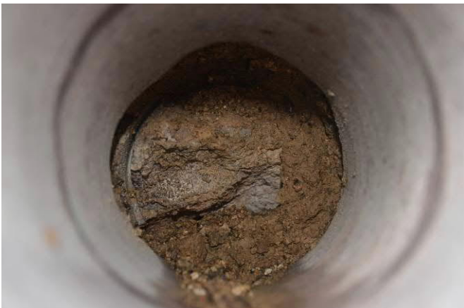
Abbildung 23: Bohrlochstirn der Bohrung BR/K/16 mit Hinterfüllmörtel hinter der Rhyolithtuffschale
