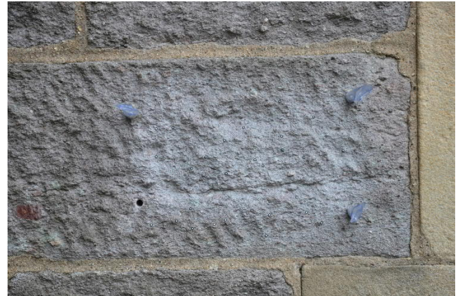
Abbildung 187: Messfläche 2 nach der Reinigung
