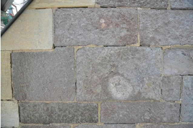
Abbildung 175: Detail der im Rahmen der Musterachse zu bearbeitenden Fassadenfläche an der Westseite des Turmanbaues nach der Partikelstrahlreinigung
