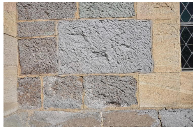
Abbildung 172: Gleicher Bereich wie in Abbildung 171 nach Schlämmenauftrag auf einem Steinquader (Auftragsfläche gedrittelt: v.l.n.r. Schlämme mit 0,15, 0,2 und 0,3 M.-% Zinkstearat ausgerüstet)
