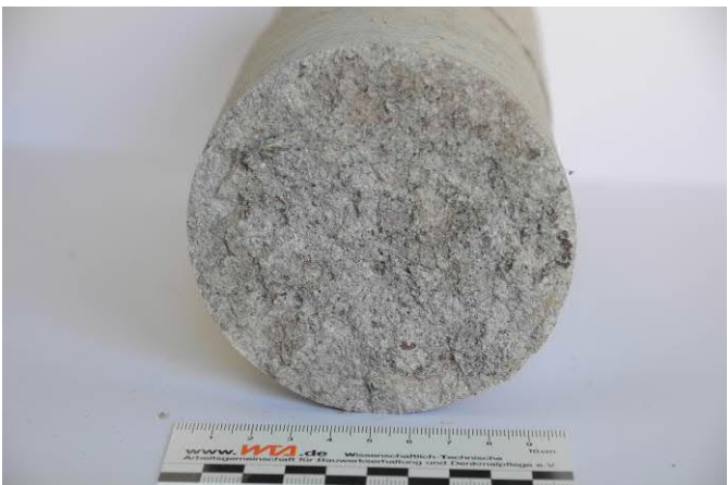
Abbildung 34: Vorderseite des Bohrkernes BR/K/16 (rötlich-violette Varietät) mit abschuppender Oberfläche
