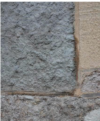
Abbildung 165: Detail der geschlammten Fläche des Sockelwerkstückes aus Abbildung 164 mit nachträglich überstrahlter Fläche (im Bild links): Eine verbesserte optische Oberflächenwirkung wird mit starker Schichtdickenverringerung erkauf.
