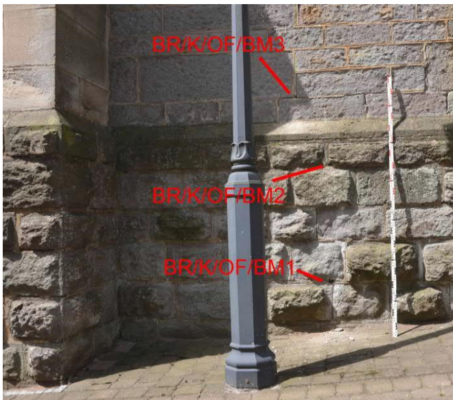
Abbildung 107: Probenahmestellen an der Ostfassade
