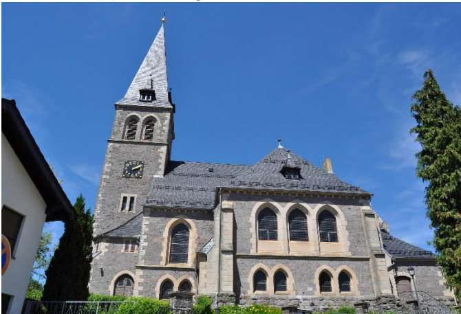
Abbildung 3: Ansicht der jetzigen Kirche von Süden
