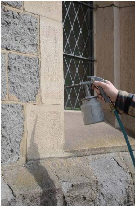
Abbildung 146: Partikelstrahlreinigung an der südseitigen Testfläche
