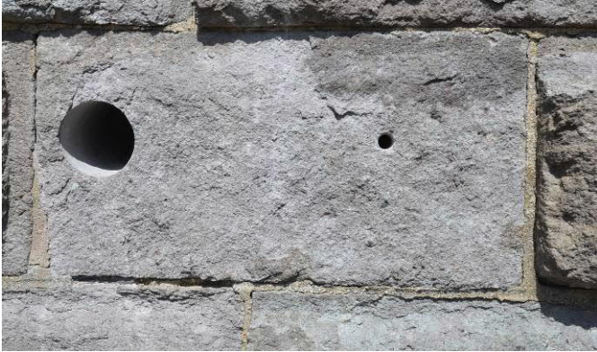
Abbildung 157: Werkstück des Bossenmauerwerks vom Sockel (Testfläche A) vor dem Schlämmenauftrag
