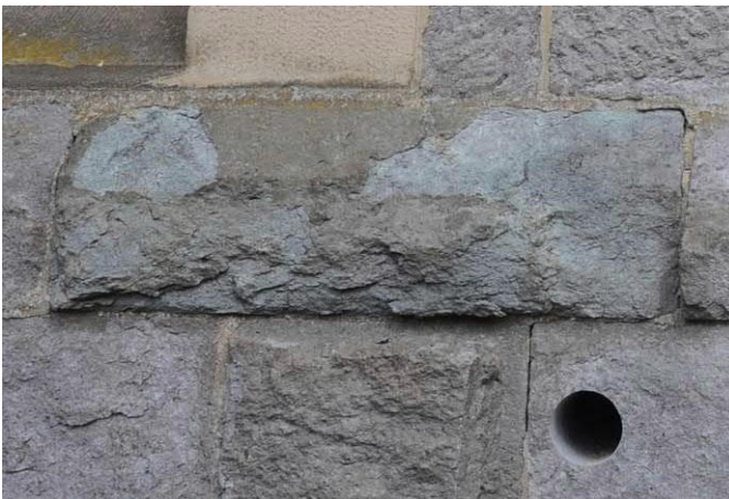
Abbildung 159: Werkstück des Sockelprofils (Testfläche A) vor dem Schlämmenauftrag
