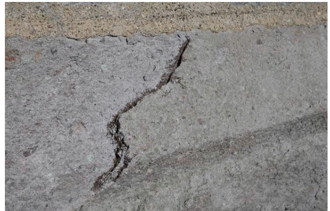
Abbildung 153: Injektage und Hinterklebung von Schalenrändern
