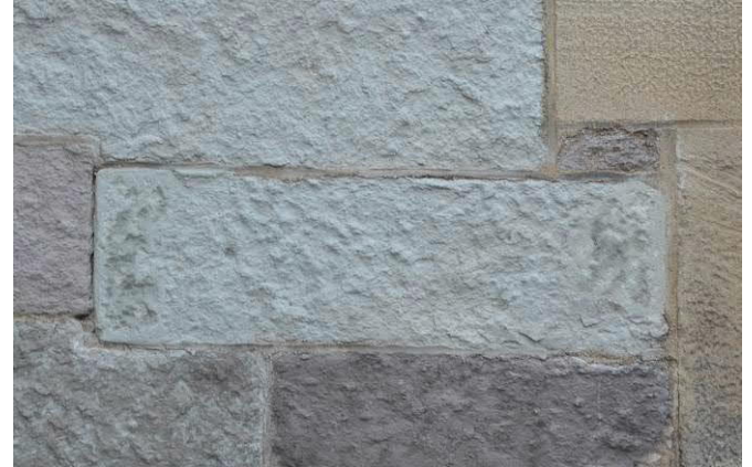
Abbildung 169: Gleicher Bereich wie Abbildung 168 nach Schlämmenauftrag auf der gesamten Steinoberfläche
