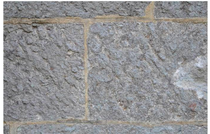
Abbildung 147: Sockelbereich der Testfläche an der Nordfassade nach der Reinigung mit Schmelzkammerschlacke (am rechten Bildrand ist noch ungereinigte Oberfläche sichtbar)
