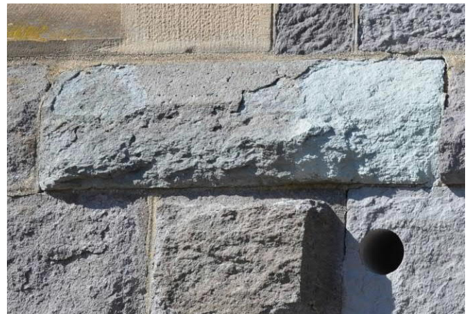
Abbildung 160: Werkstück aus Abbildung 159 nach dem Auftrag der Schlämme (der rechte Teil des Werkstückes ist noch nicht lasiert, hier wurde der grüne Grundfarbton der Schlämme eingesetzt - der linke Teil des Werkstückes ist geschlämmt und lasiert)
