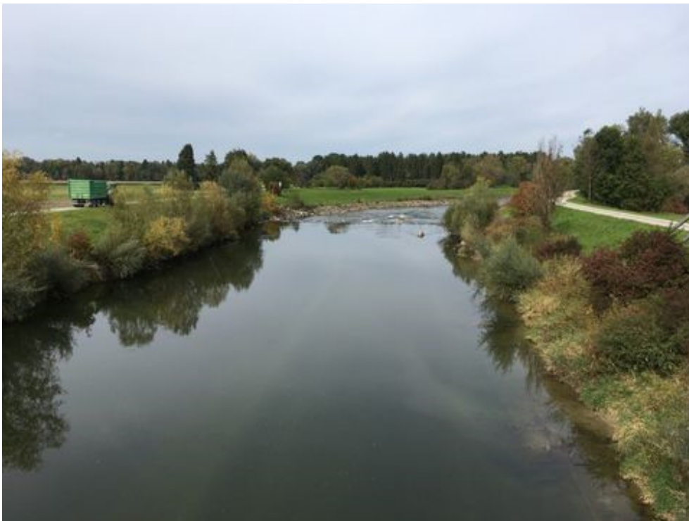
Abbildung 4: Begradigte und beidseitig gewässernah eingedeichte Ammer bei Weilheim in Oberbayern. Die umgebende morphologische Aue wird landwirtschaftlich genutzt (Foto: I. Juszczak 2018).
