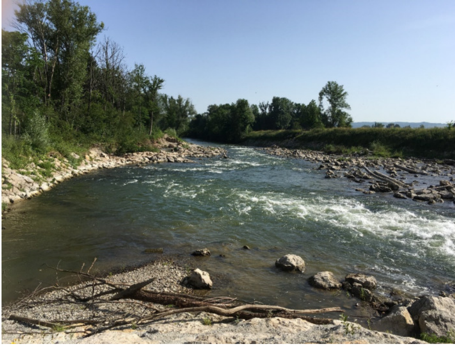
Abbildung 122: Umgebautes Grundwehr III flussab von Unterhausen als Sohlgleite. Eine Fischtreppe aus Natursteinbecken verbindet die Ammer mit dem Ochsenbachmäander und ermöglicht eine Durchgängigkeit für Fische und andere aquatische Organismen (linker unterer Bildrand) (Foto: I. Juszczyk).
