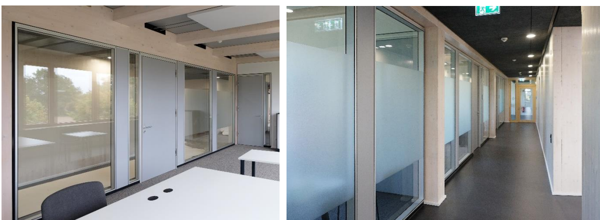
Abbildung 3-7 Wiederverwendete Trennwandelemente, Büro- und Flurseite
