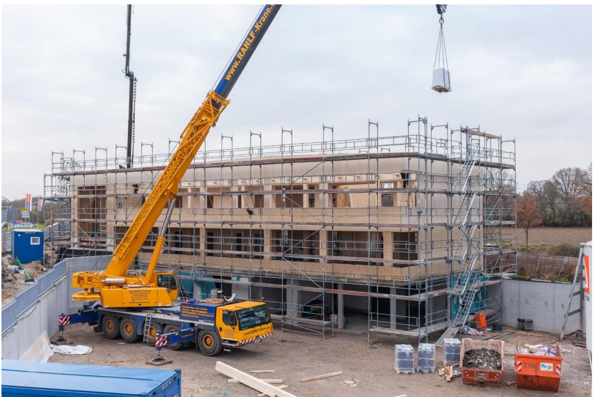
Abbildung 2-34 Rohbau des Verwaltungsgebäudes
