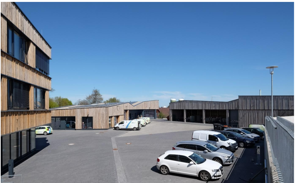
Abbildung 2-7 Betriebshof, Blick auf Werkstätten, Lagergebäude und Fahrzeughalle
