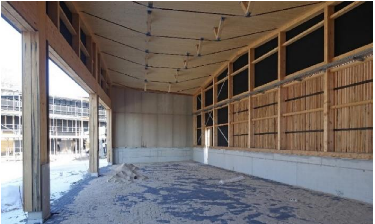
Abbildung 2-24 Innenansicht der Fahrzeughalle im Rohbau
