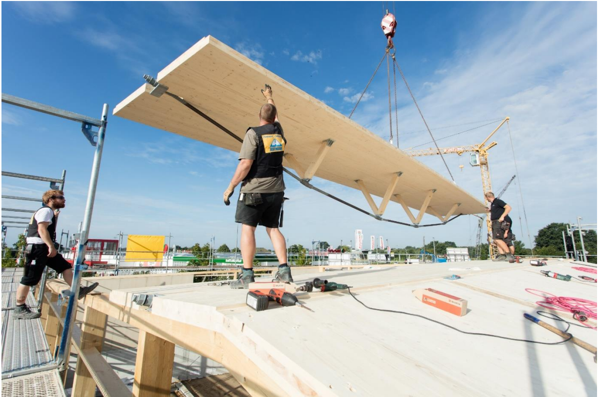
Abbildung 2-26 Montage eines unterspannten Brettsperreholzelements
