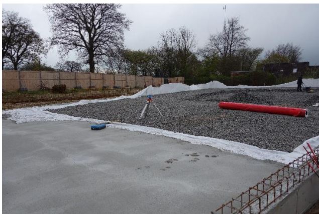
Abbildung 10-2 Sohle Werkstattgebäude – Sauberkeitsschicht auf Schaumglasschotter
