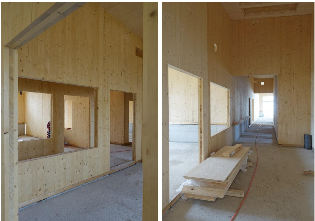
Abbildung 10-5 Rohbau Werkstattgebäude – Brettspertholz­wände
