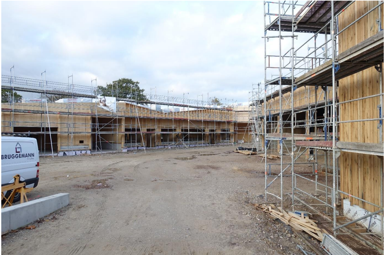
Abbildung 10-8 Werkstattgebäude und Fahrzeughalle - Fassadenbekleidung im Bau
