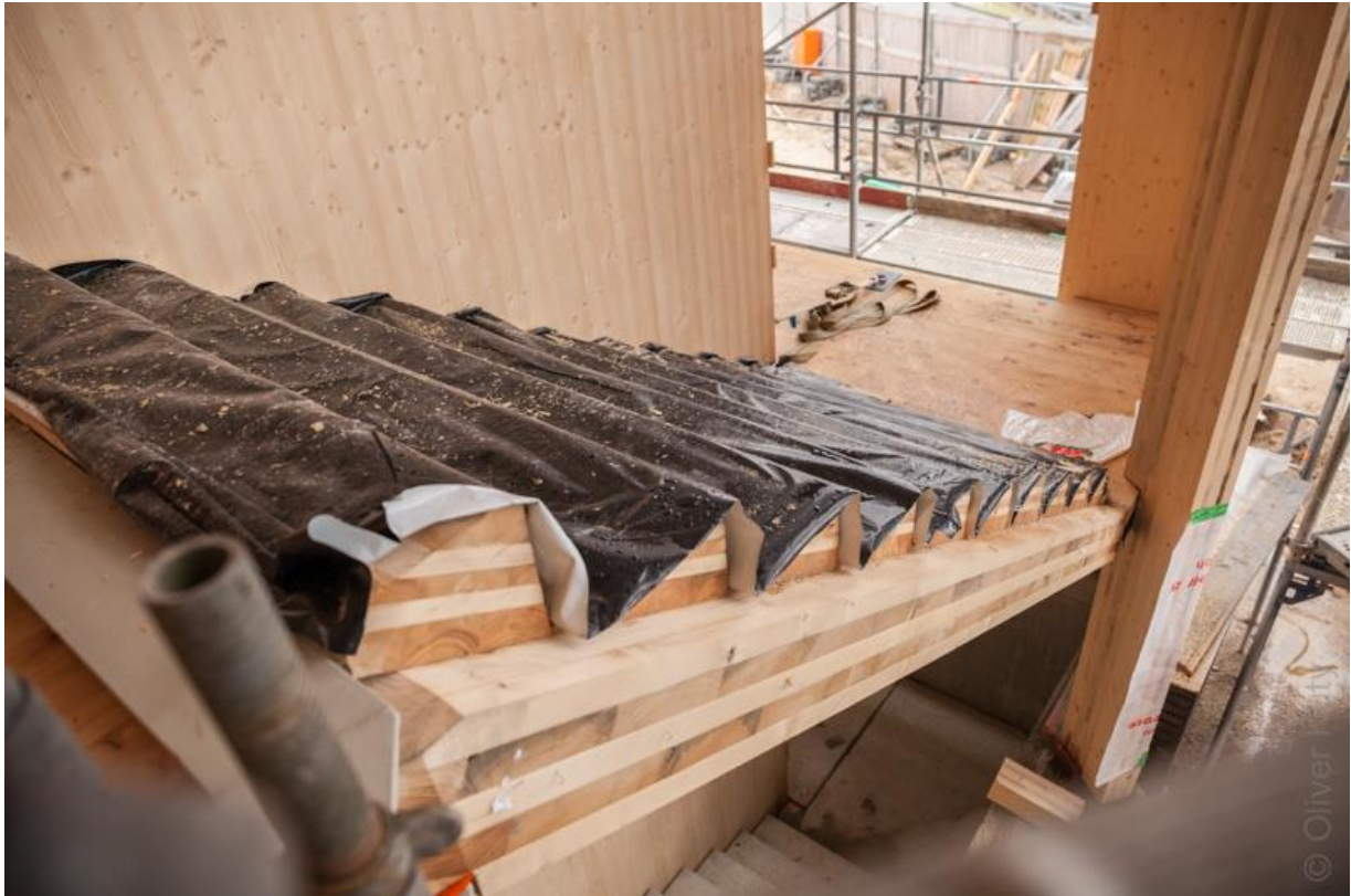
Abbildung 10-12 Rohbau - Holzfertigteiltreppe
