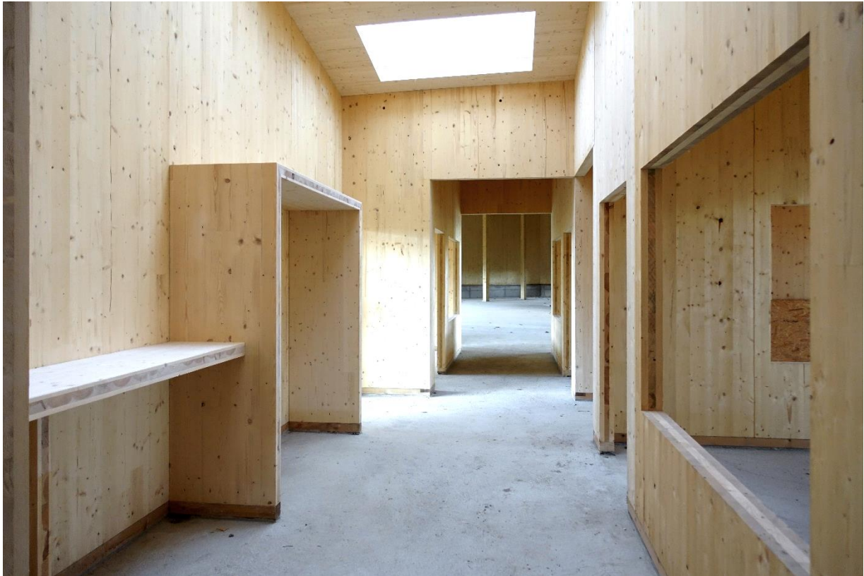
Abbildung 10-4 Rohbau Erschließungszone Werkstatt/ Lager
