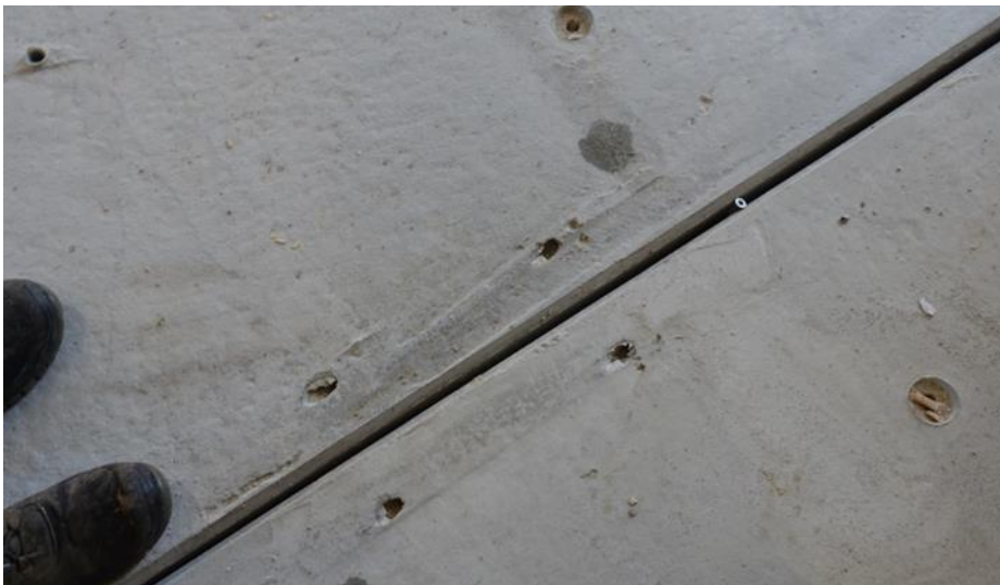
Abbildung 2-45 Aufsicht auf das Betonfertigteil mit den Verbindungspunkten der Schraubverbindung
