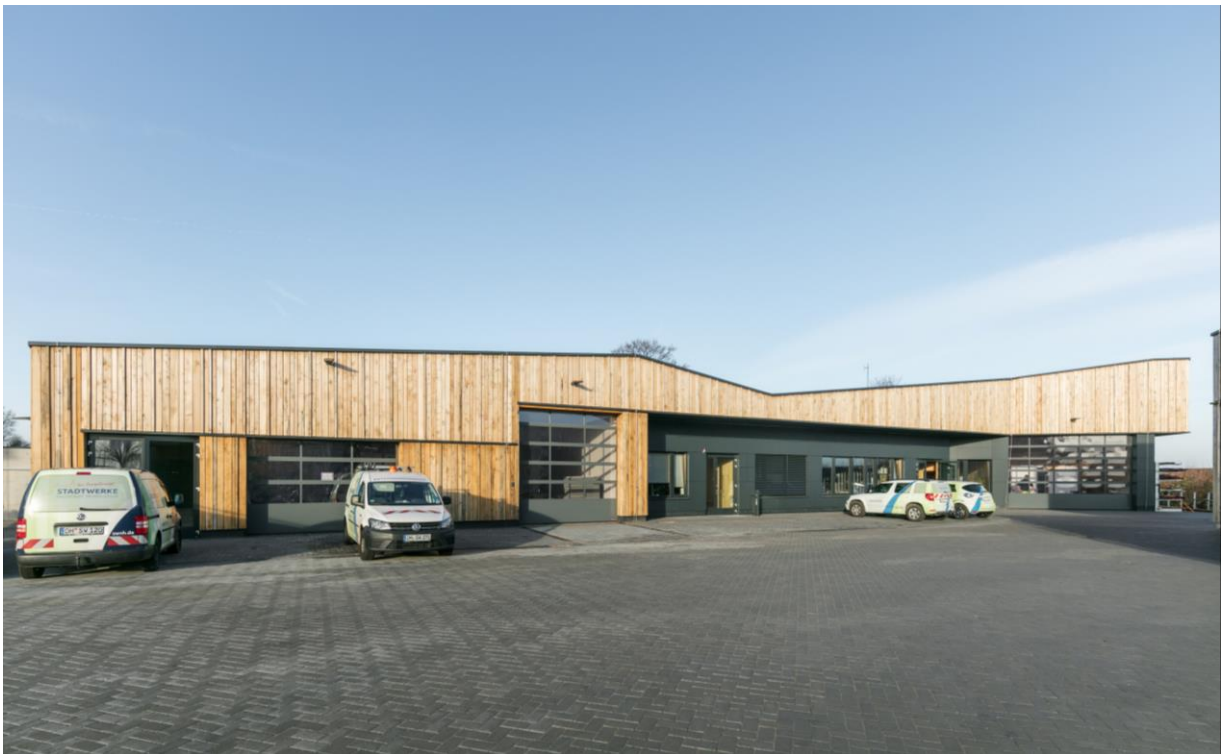
Abbildung 2-17 Südansicht Werkstatt- und Lagergebäude vom Betriebshof
