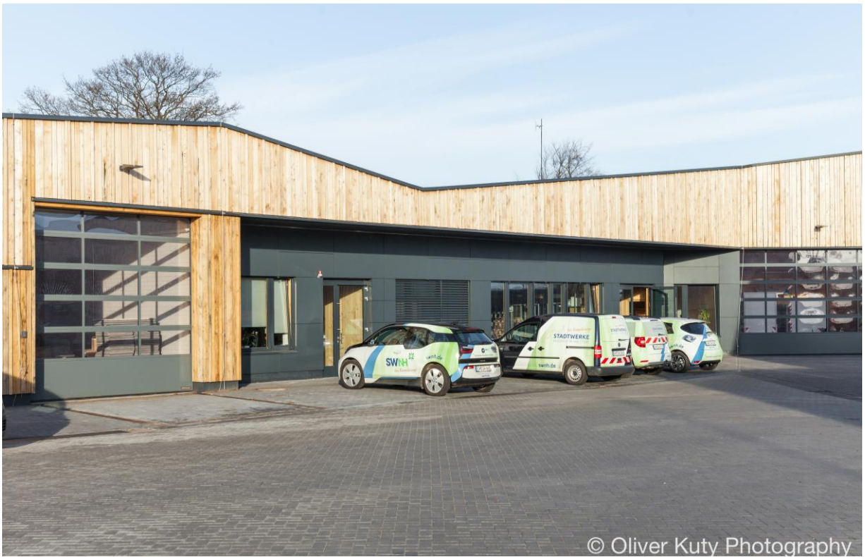
Abbildung 2-19 Werkstattgebäude mit Waschhalle, Materialausgabe und Messtechnikhalle
