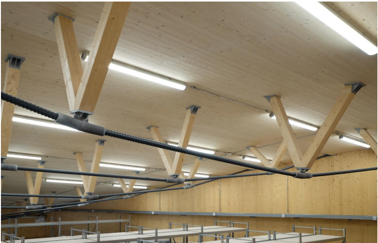
Abbildung 2-21 Lagerhalle – Detailaufnahme der unterspannten Holzdeckenkonstruktion
