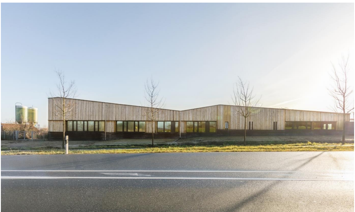
Abbildung 2-18 Nordansicht Werkstatt und Lagergebäude (von der Eutiner Straße aus gesehen)
