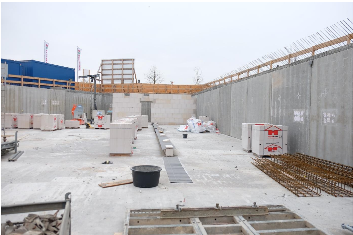
Abbildung 10-1 Rohbau – Sohle und UG-Wände Verwaltungsgebäude
