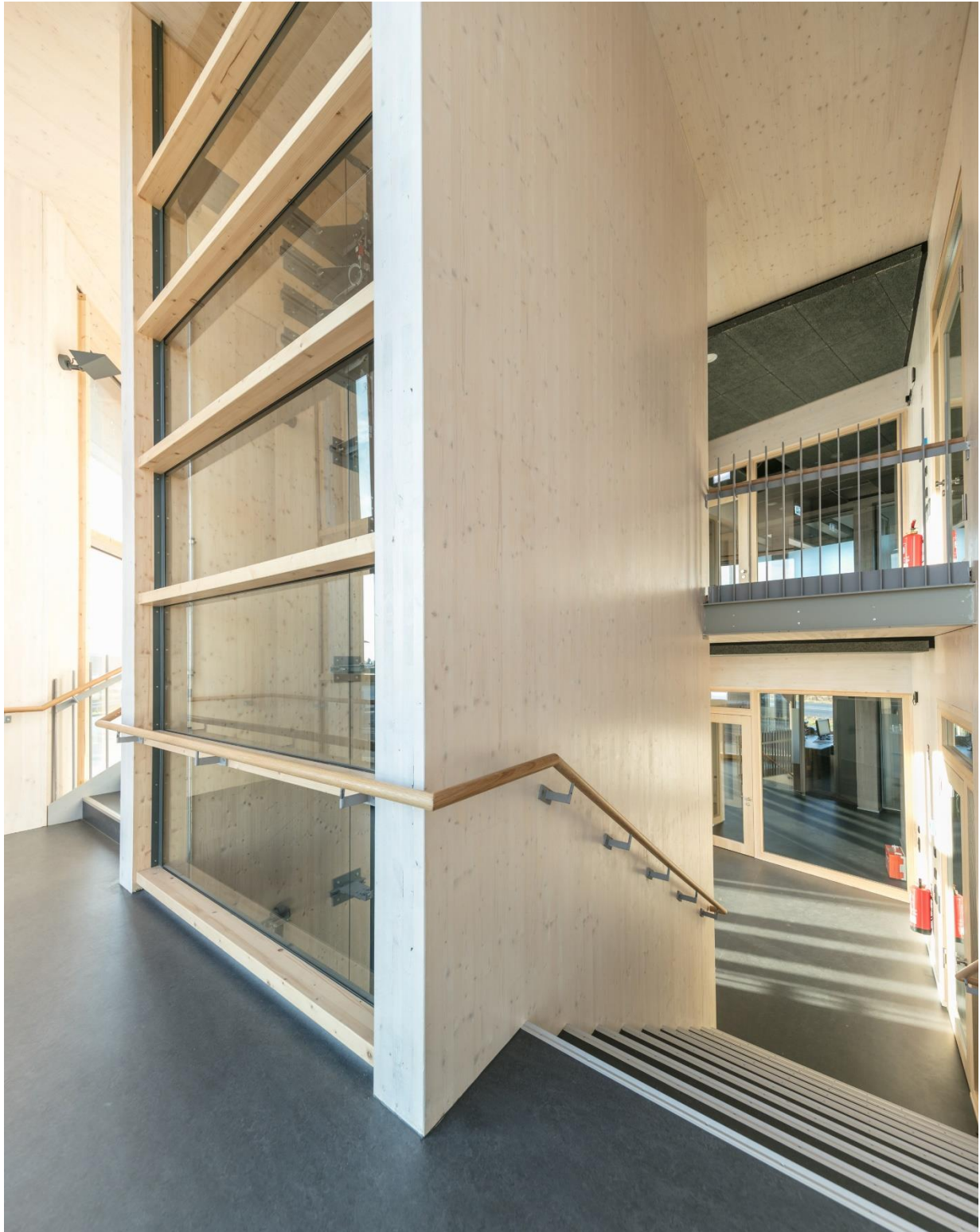
Abbildung 10-23 Fahrstuhlschacht aus Massivholz im Treppenhauskern
