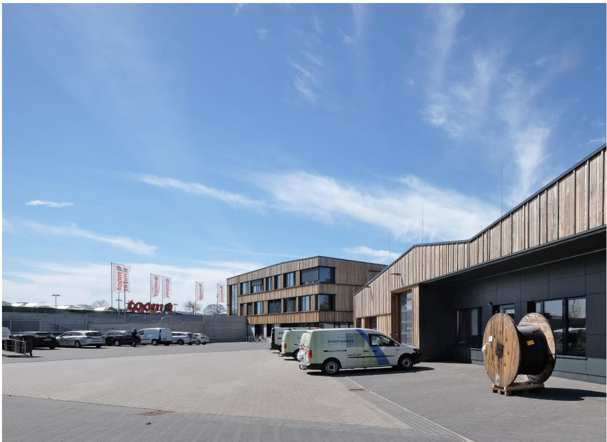
Abbildung 10-17 Betriebshof Blickrichtung Verwaltungsgebäude
