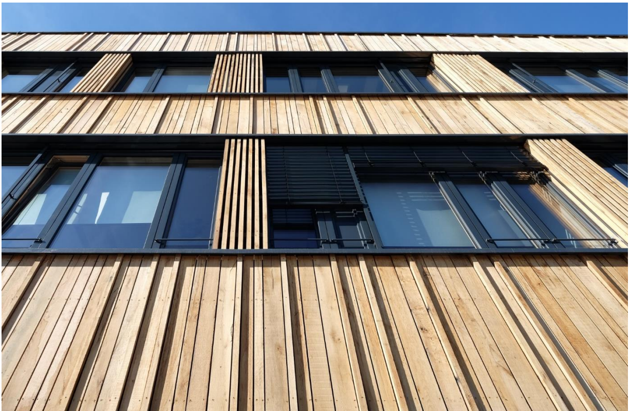
Abbildung 3-4 Fassadenansicht – die unterschiedlichen Breiten und Dicken der Eichenhölzer sind erkennbar
