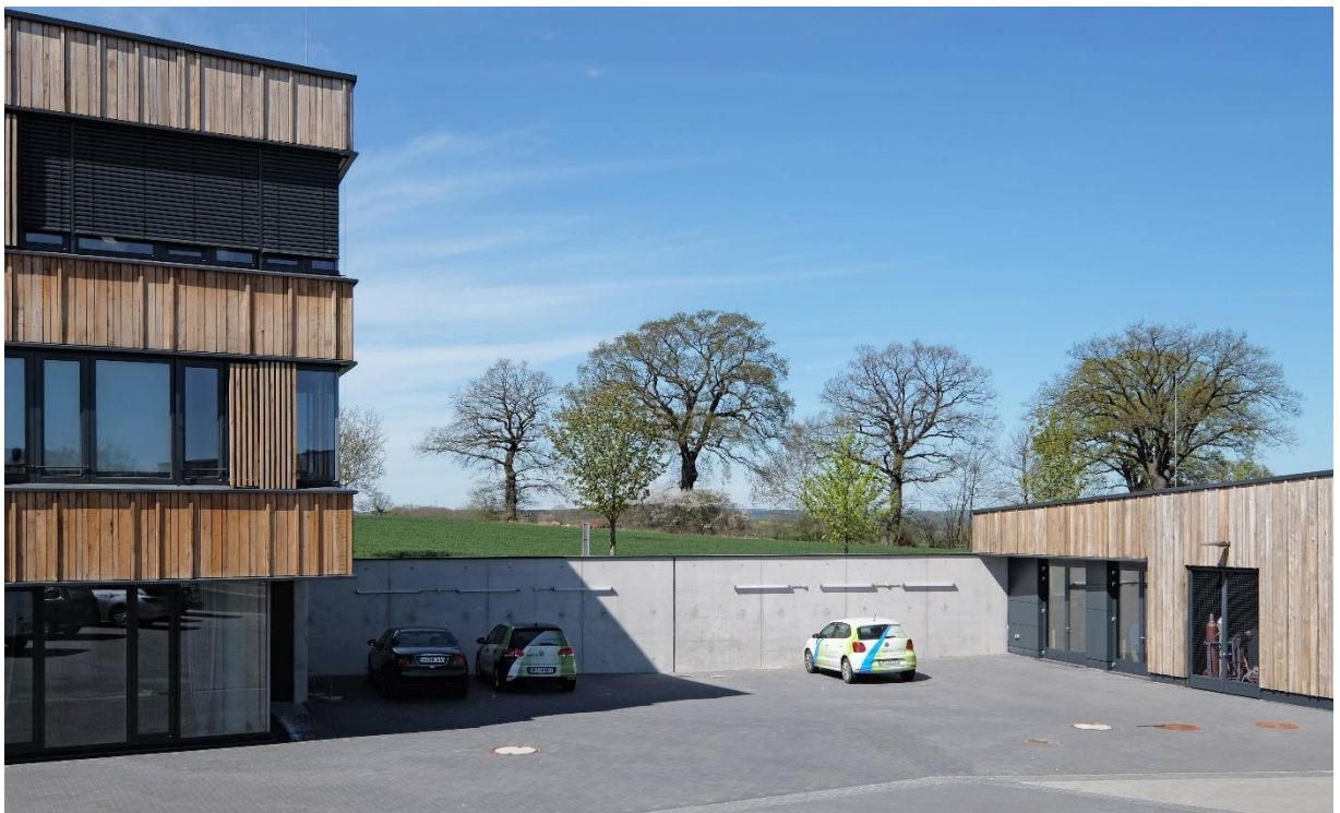
Abbildung 10-19 Stellplätze der Betriebsfahrzeuge zwischen Verwaltungs- und Werkstattgebäude
