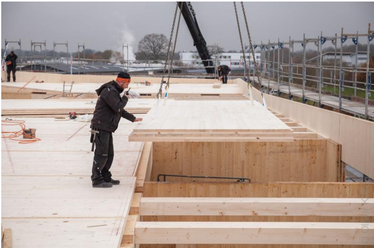
Abbildung 10-11 Montage BSP- Deckenelemente Verwaltungsgebäude
