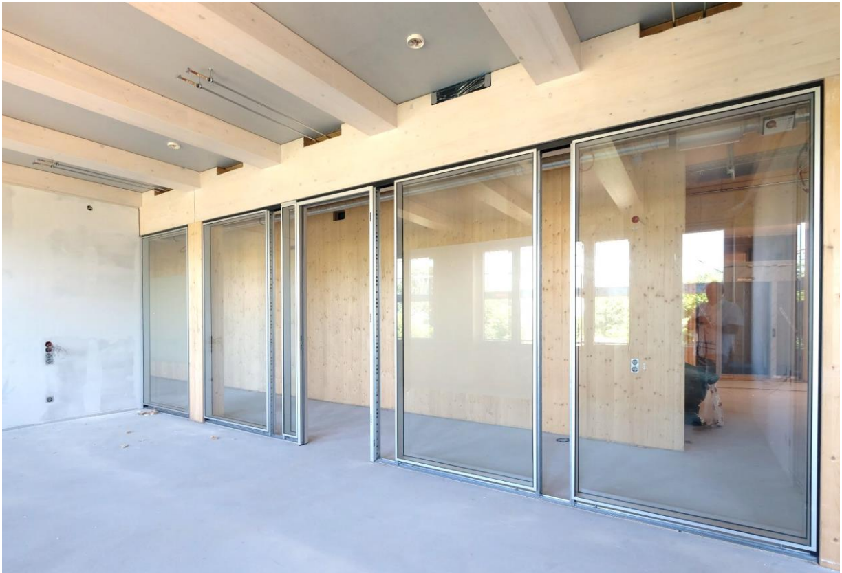
Abbildung 3-6: Einbau der wiederverwendeten Trennwandelemente
