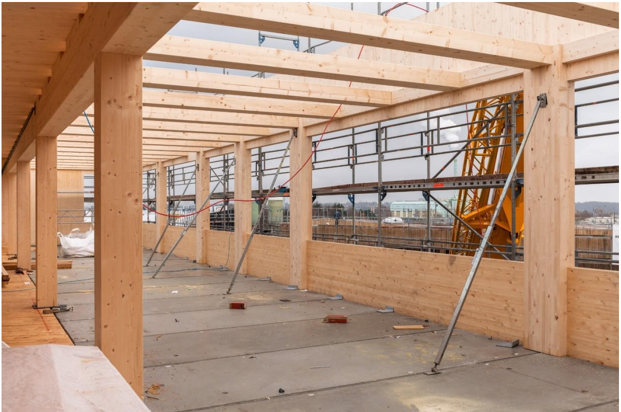
Abbildung 2-41 HBV- Deckenkonstruktion – Betonfertigteile auf dem Fußboden, oben noch ohne Betonelemente
