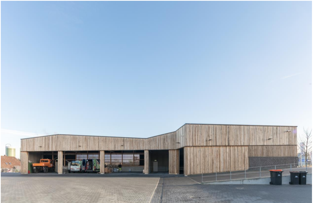
Abbildung 2-28 Ansicht der Fahrzeughalle vom Betriebshof aus gesehen.
