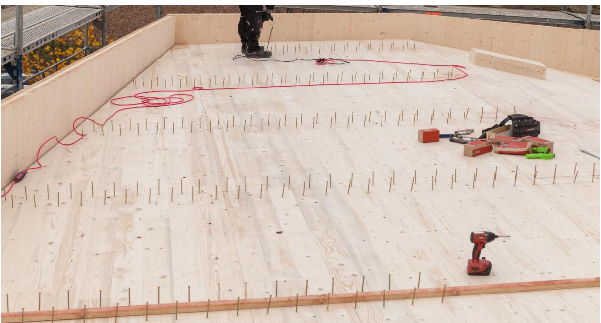
Abbildung 2-46 Aufsicht auf ein BSP-Dachelement und dessen Verschraubung auf den Unterzügen
