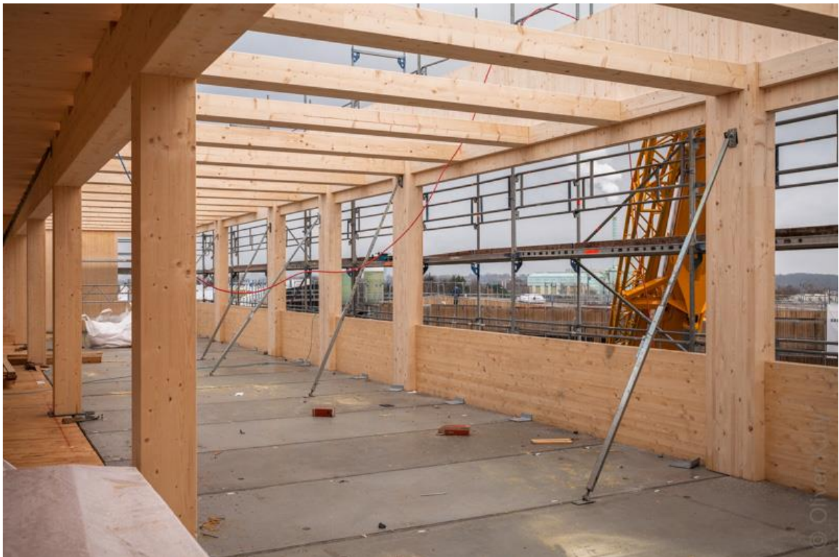
Abbildung 10-15 Rohbau Verwaltungsgebäude - Bürozone
