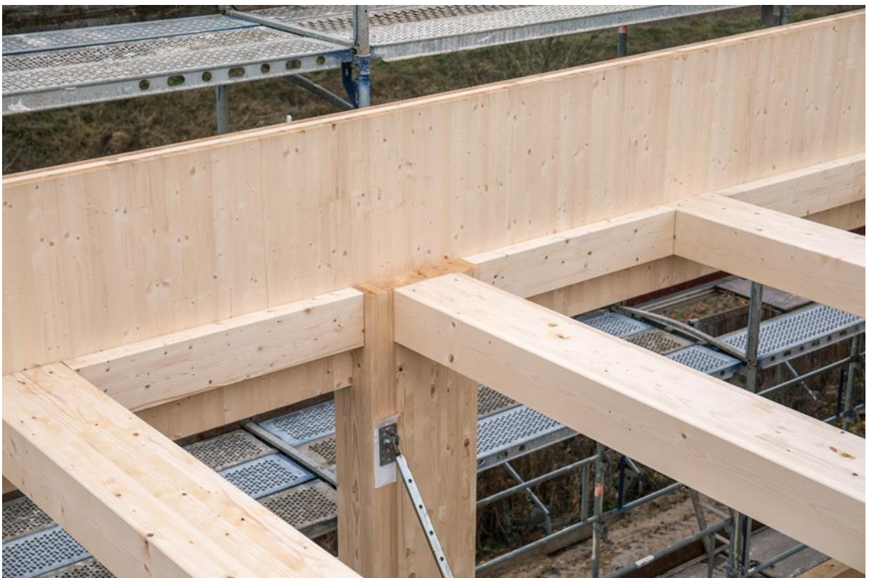
Abbildung 2-43 Auflagerbereich für die Betonfertigteile der HBV-Konstruktion
