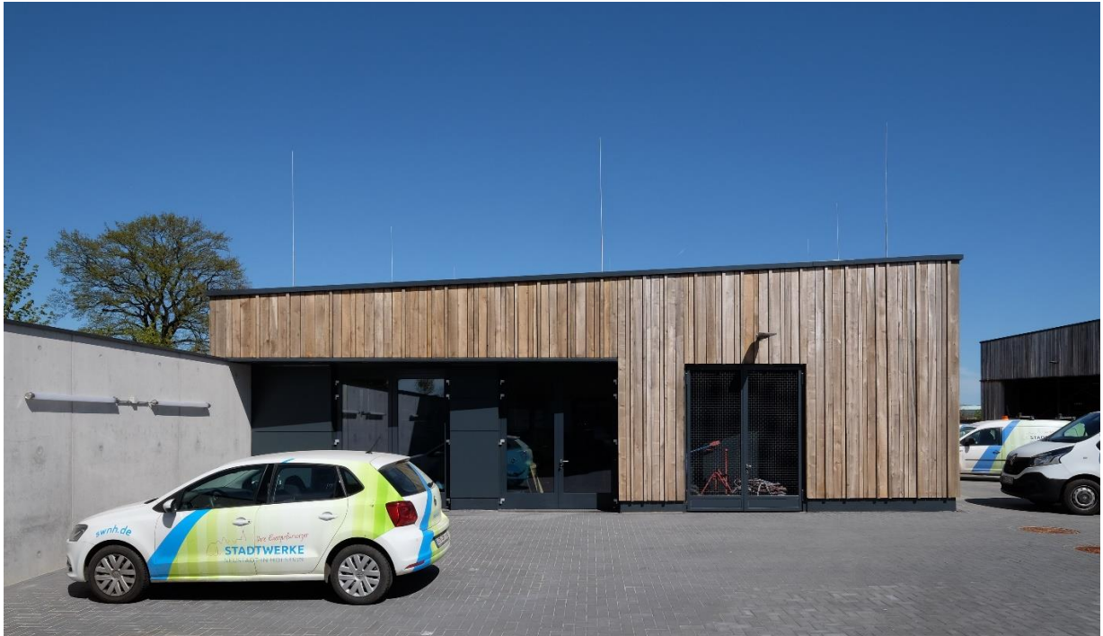
Abbildung 10-18 Blick auf die Westfassade des Werkstattgebäudes
