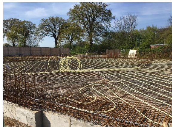
Abbildung 10-3 Bewehrung mit Heizungsleitungen für die thermisch aktivierte Sohle
