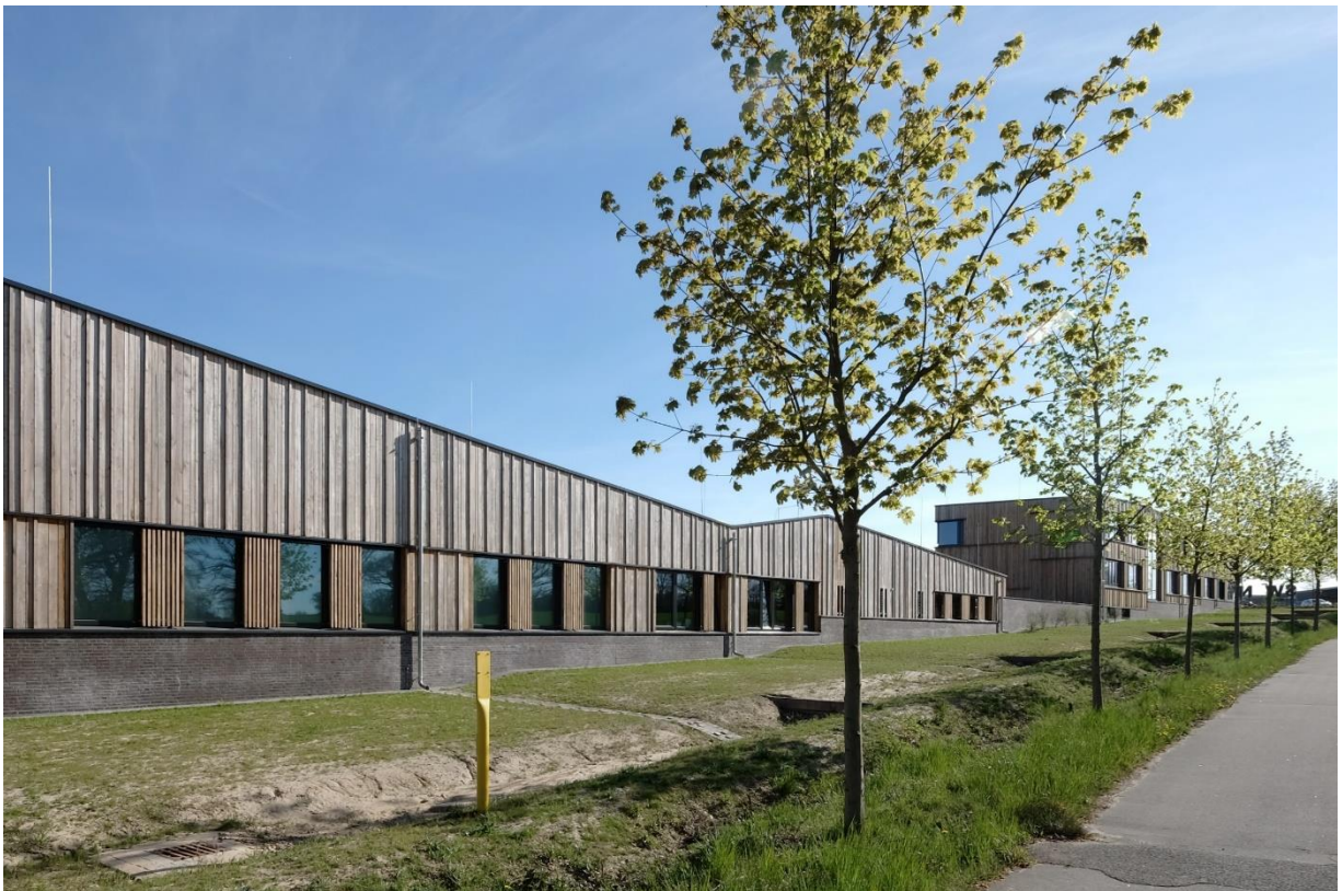
Abbildung 2-58 Regenwassersammler mit Staustufen zur Wasserrückhaltung
