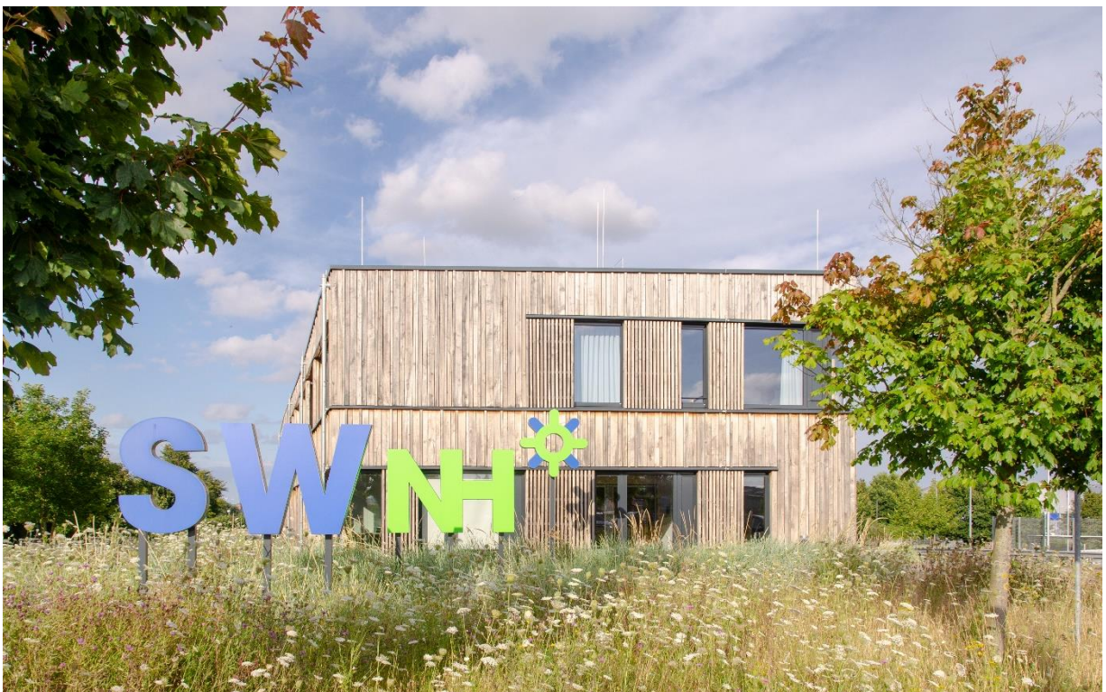
Abbildung 2-13 Westansicht vom Kreisverkehr aus gesehen
