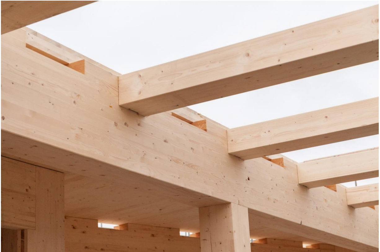
Abbildung 2-42 Hauptträger mit Regelaussparungen für die technischen Installationen
