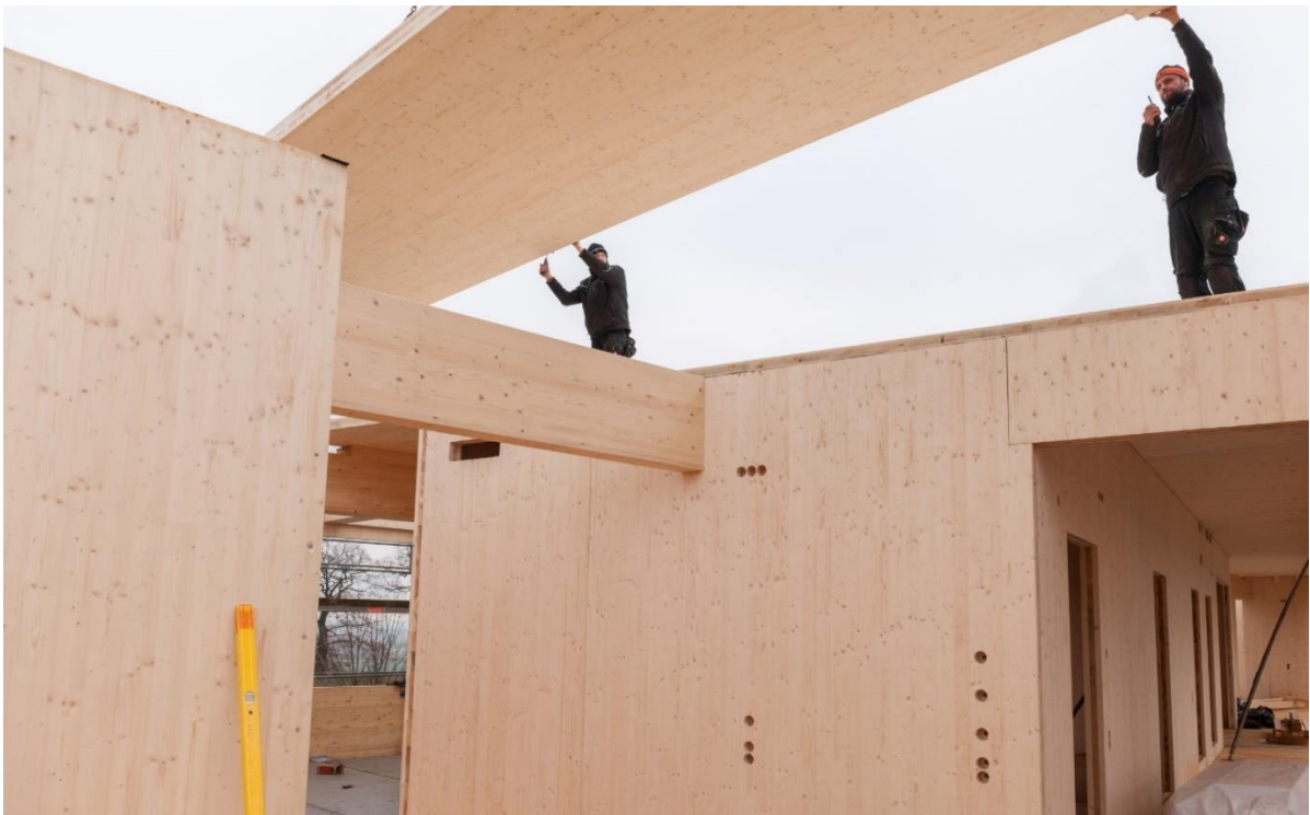
Abbildung 2-39 Gebäudekern – Montage eines BSP-Deckenelements
