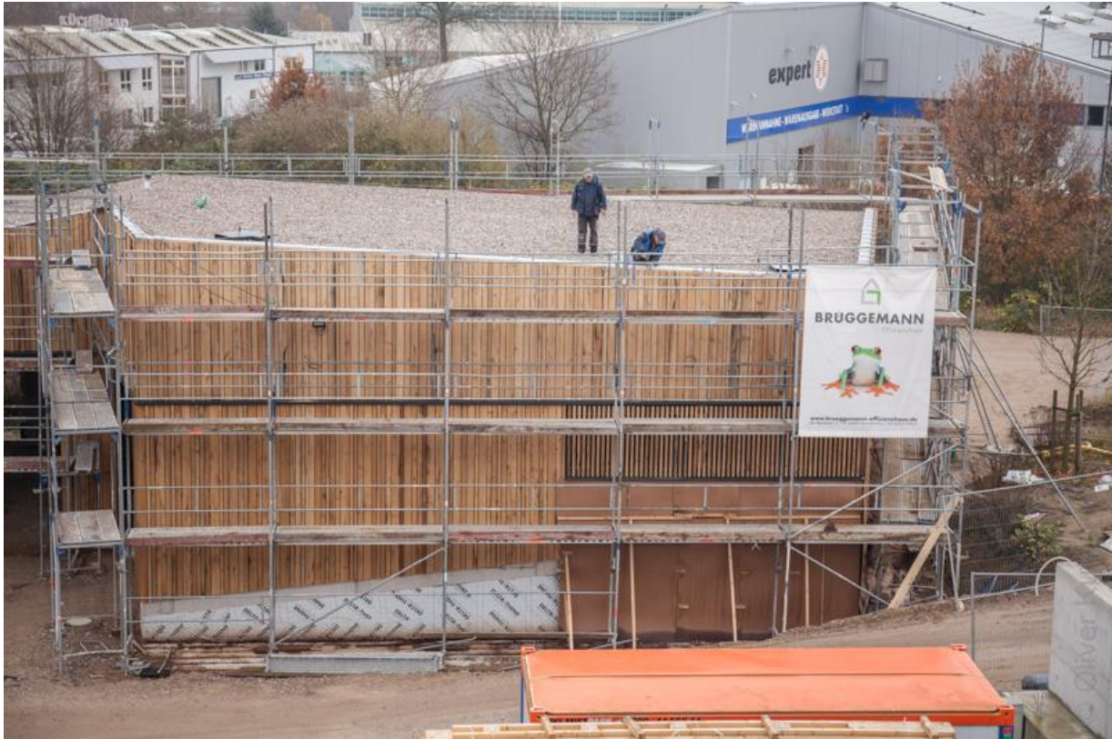
Abbildung 10-10 Fahrzeughalle- Gebäudehülle ist fast fertiggestellt
