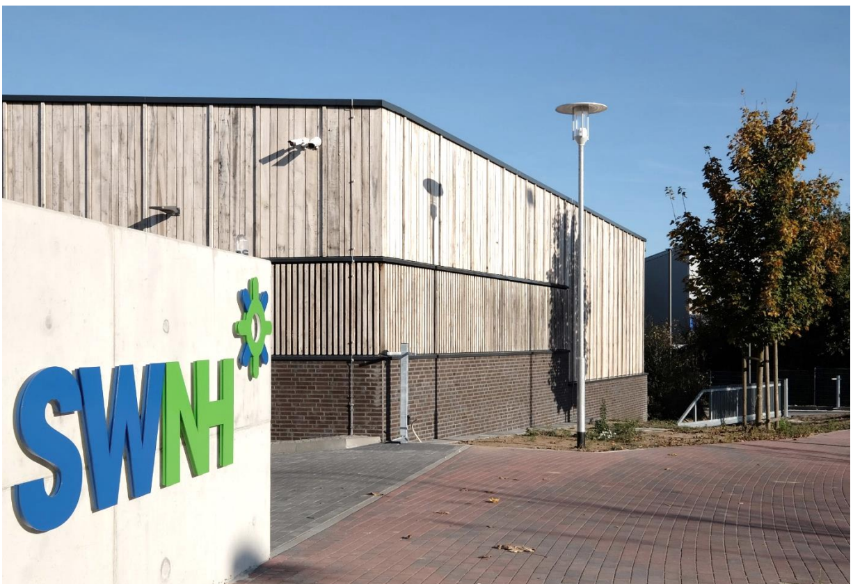
Abbildung 2-27 Die Fahrzeughalle an der Einfahrt zum Betriebshof
