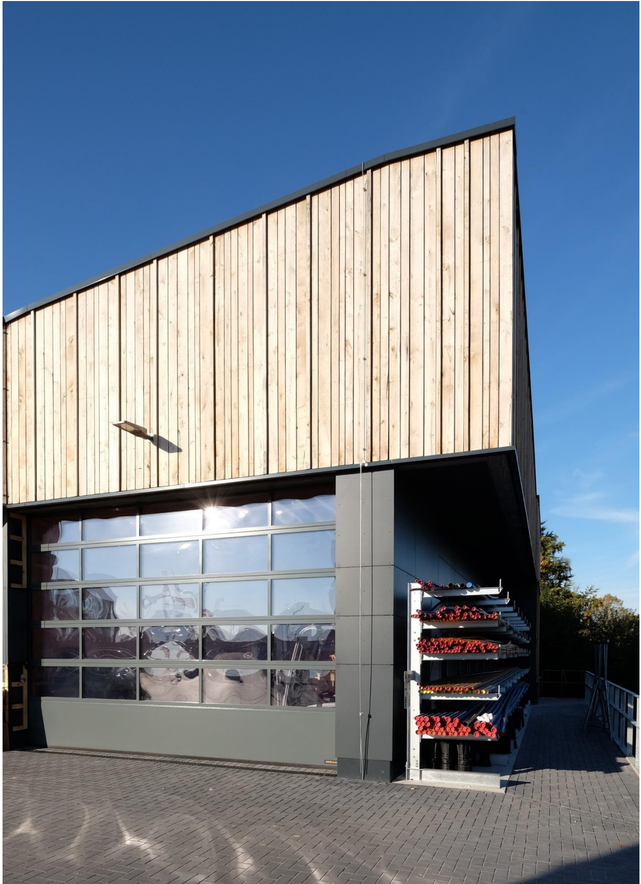
Abbildung 10-20 Garage Messtechnikfahrzeug und Rohrlager – Haus B
