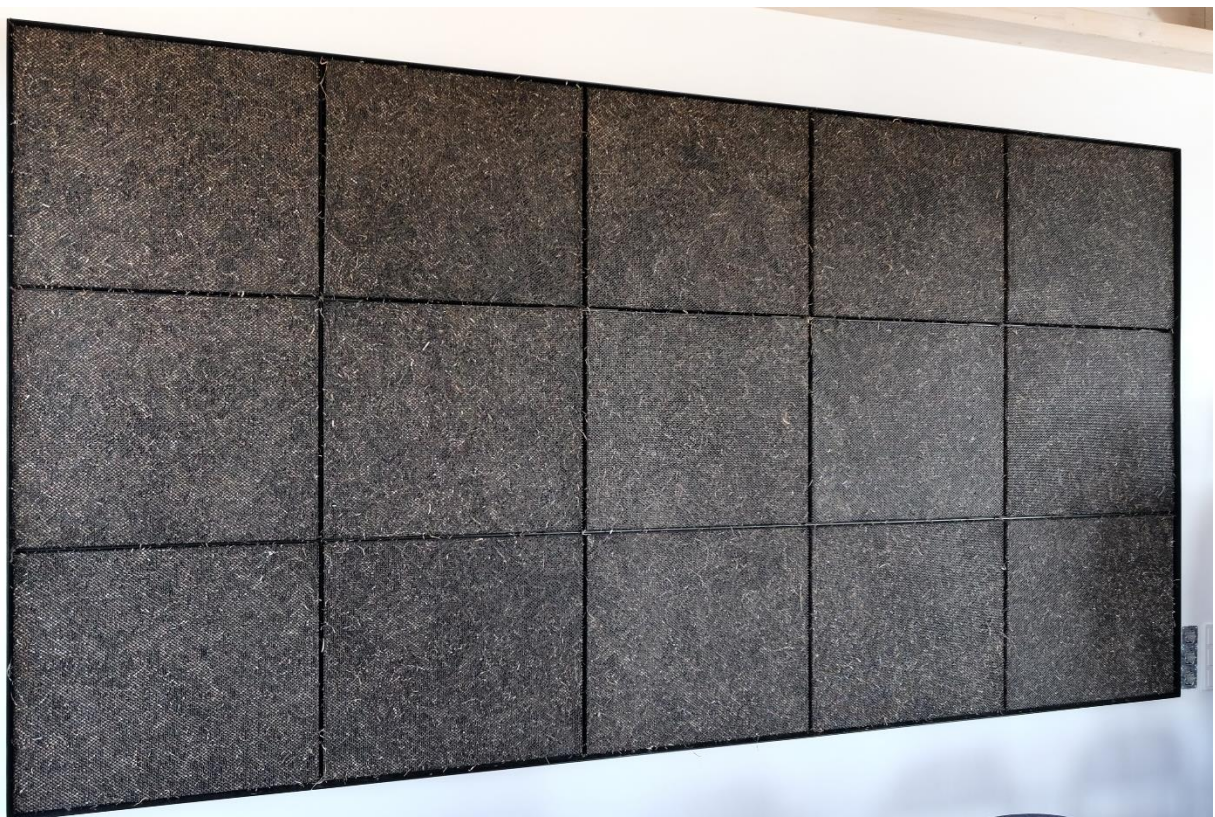
Abbildung 3-8 Akustikabsorber mit Seegras gefüllt
