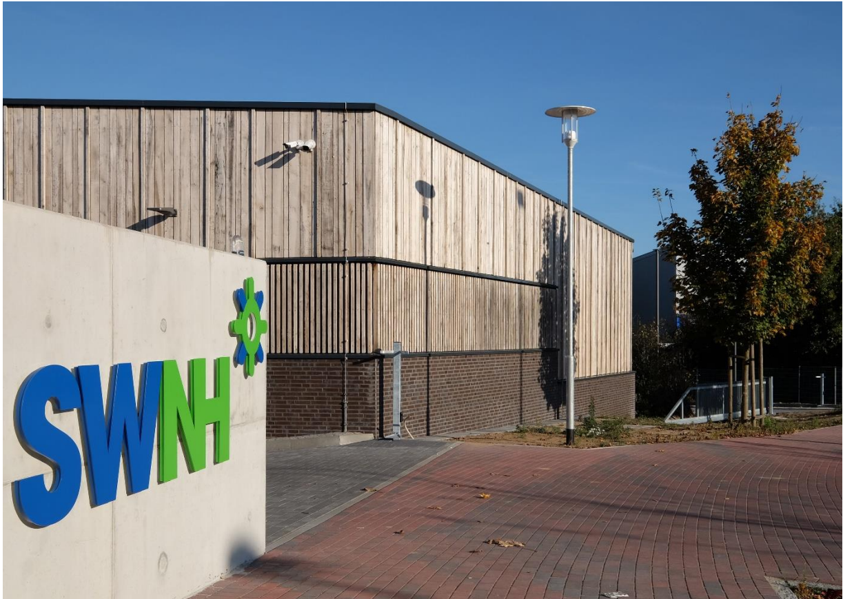
Abbildung 10-21 Einfahrt zum Betriebshof mit Blick auf die Fahrzeughalle
