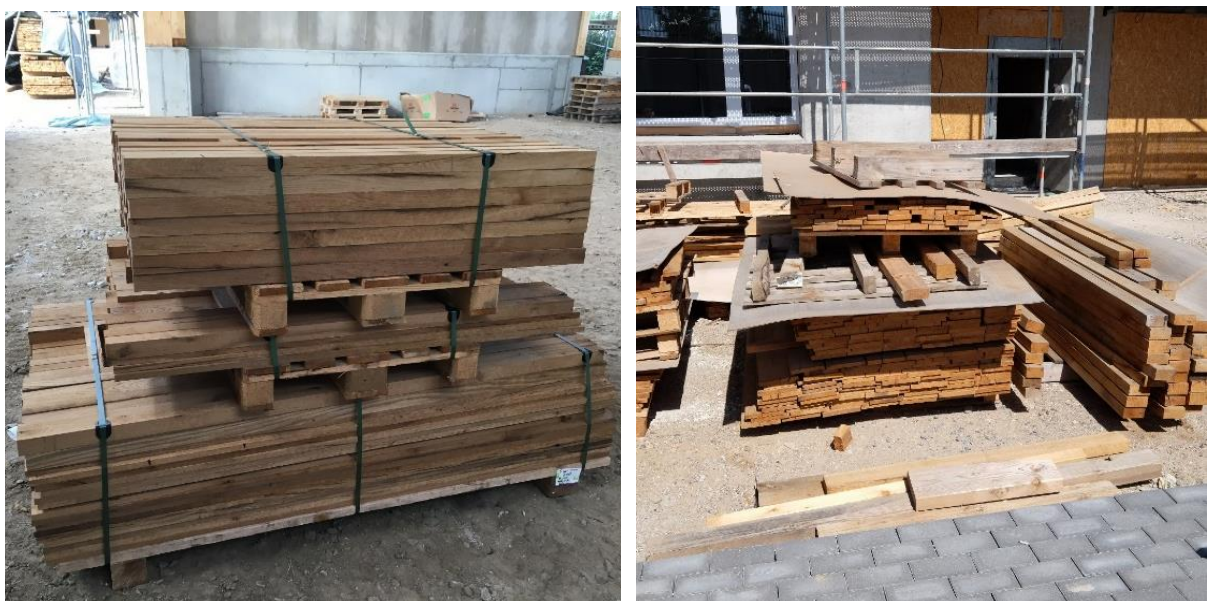
Abbildung 3-3 Für den Einbau geliefertes zugeschnittenes Eichenholz der Fassaden
