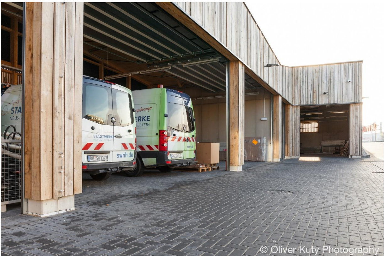
Abbildung 2-29 Fahrzeughalle für Klein-LKW
