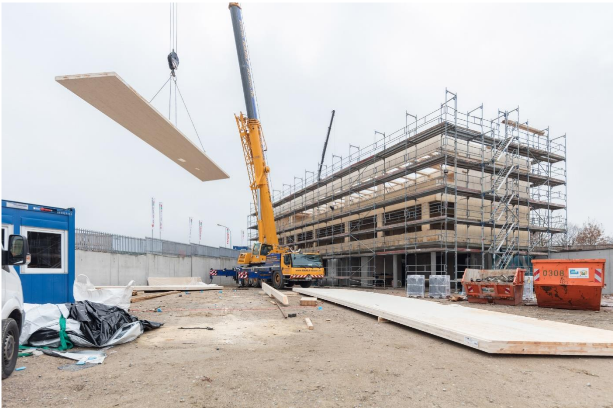
Abbildung 2-33 Rohbau des Verwaltungsgebäudes – Montage des BSP Deckenelemente
