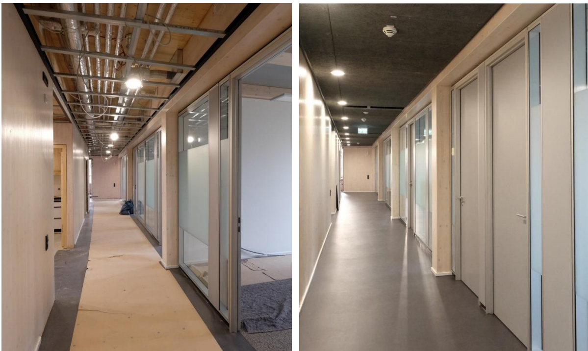
Abbildung 2-52 Installationsführung unter der Flurdecke
