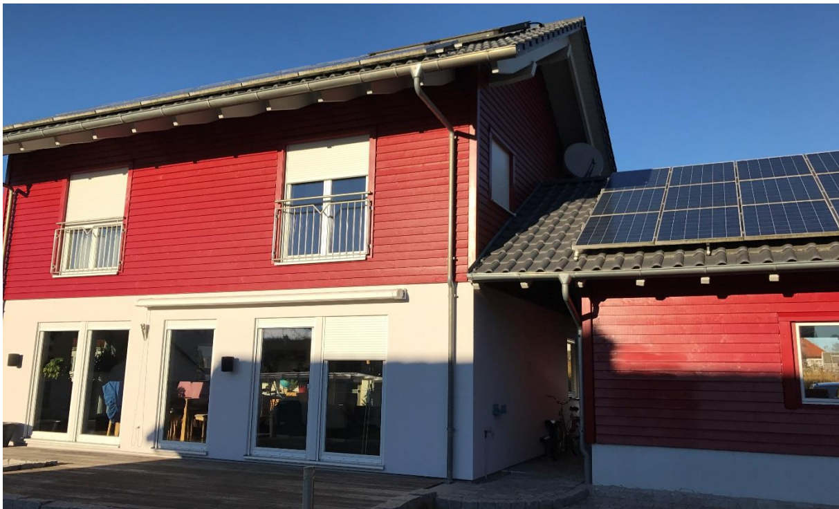
Abbildung 6: Außenansicht Gebäude 2. Links: Wohngebäude mit PV-Anlage und Solarthermie. Rechts: Garage mit PV-Anlage
