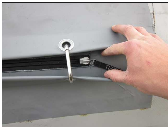
Abb. 51: Revisionsverschlüsse in Form von Reißverschlüssen (links), gesichert mit Zugaufnahmen
