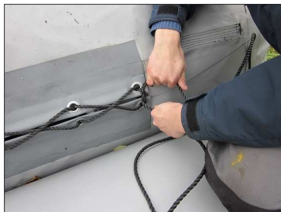
Abb. 51: Revisionsverschlüsse in Form von Reißverschlüssen (links), gesichert mit Zugaufnahmen
