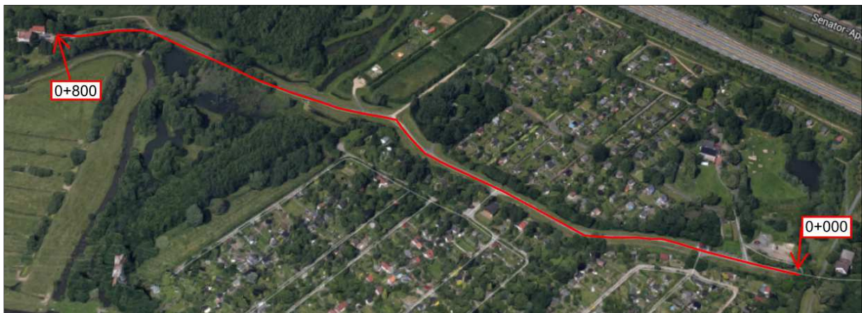
Abb. 20: Der Reedeich bei Bremen (Woltmershausen) von Station 0+000 bis 0+800
