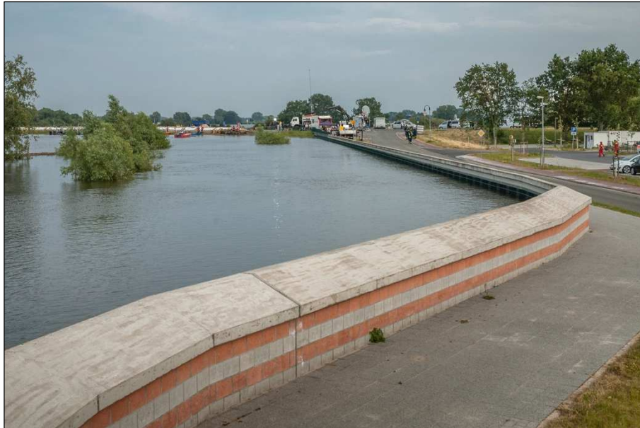
Abb. 38: Einstau des 2008 erstellten Hochwasserschutzsystems Hitzacker am 12.06.2013 bei sinkenden Wasserständen – der Scheitelwasserstand wurde am 11.06.2013 erreicht (Foto: Bärbel Koppe)
