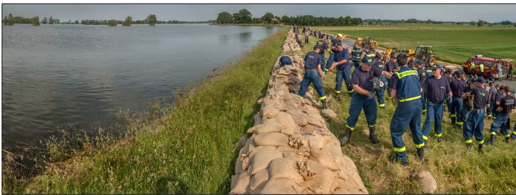
Abb. 1: Aufkadungen aus Sandsäcken am Elbedeich bei Hitzacker im Juni 2013 (Foto: Bärbel Koppe)
