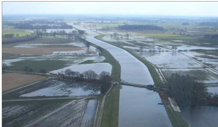
Abb. 33: Erschwerte Deichverteidigung aufgrund fehlender Verteidigungswegen während des Jeetzelhochwassers 2002 6
