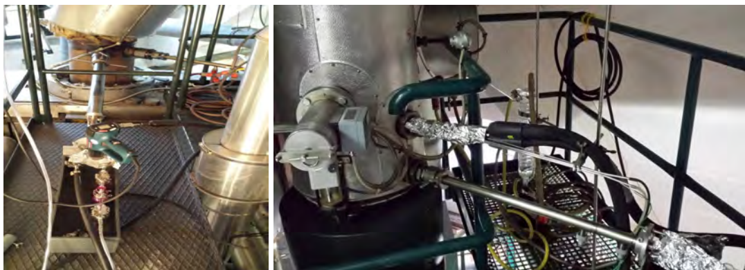
Bild 33: Probenahmestellen an Linie 5 des Krematoriums München (links: Rohgas; rechts: Reingas; Bildquelle: IUTA)
