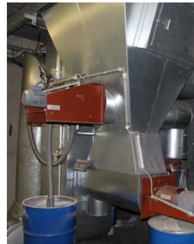
Bild 8: Ofenschema (Fa. IFZW GmbH) und Technische Einrichtung im Krematorium Berlin-Baumschulenweg (Sargeinfahrt, Entaschung, Additivdosierung)
