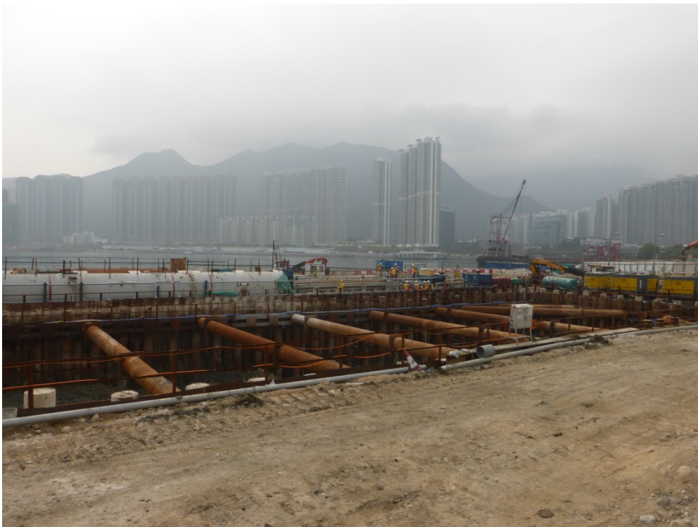
Abbildung 19: Front Steer auf Versuchsbaustelle
