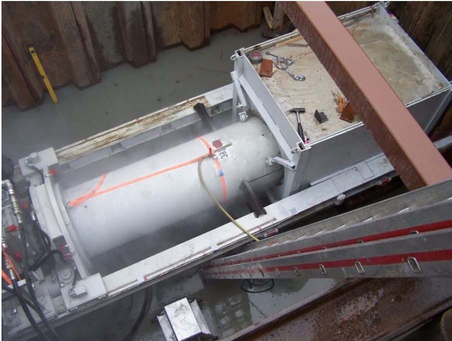
Abbildung 15: Versuchskasten vorbereitet für Imlochhammerversuch
