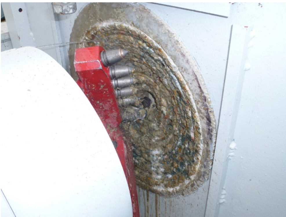
Abbildung 3: Feststehender Bohrkopf bei der Einfahrt
