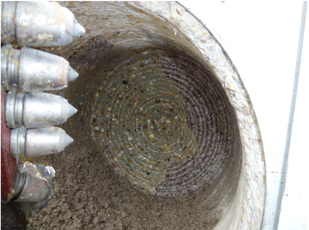
Abbildung 5: Feststehender Bohrkopf Bohrbild
