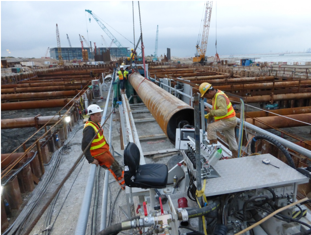
Abbildung 20: Front Steer auf Versuchsbaustelle
