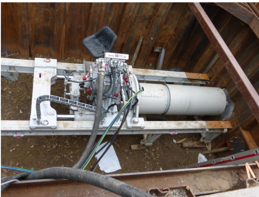
Abbildung 18: Front Steer vorbereitet für erste Probebohrung
