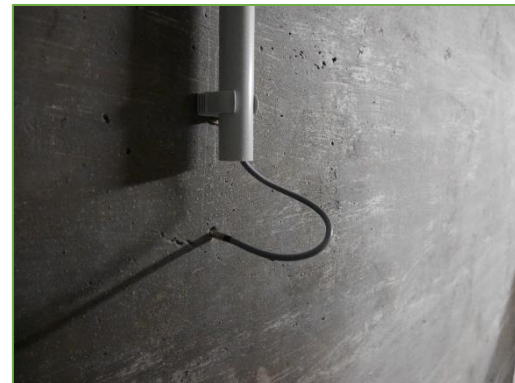
Abbildung 5: Temperaturmessfühler im Betonkern
