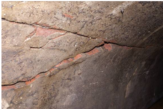
Bild 30 Typisches Rissbild (links) und Querschnitt mit Rissbereichen (rechts)
