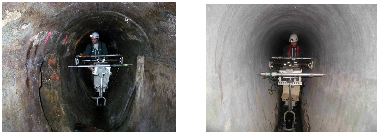
Bild 13 MAC-Versuche vor und nach der Sanierung (Spritzbeton).
