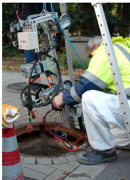
Bild 43 Herablassen der MAC-Prüfeinrichtung (links) und des Scherenarms (rechts) in die Haltung
