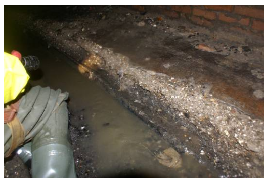
Bild 29 Typische Schadensbilder: Korrosionsschäden und Absackungen mit Schrägstellung (links) und offensichtlichen Ausspülungen im darunterliegenden Bettungsmaterial (rechts)
