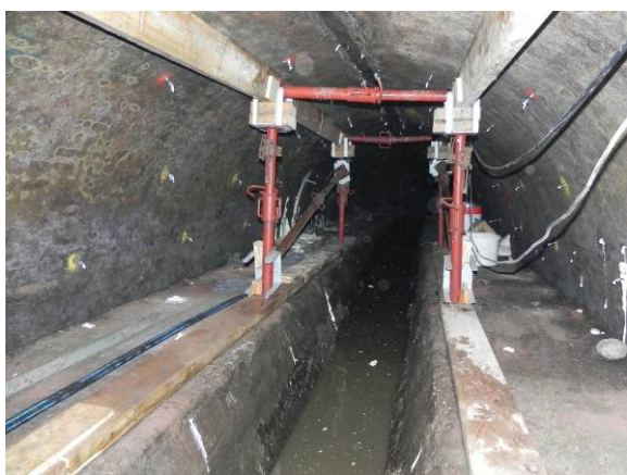
Bild 34 Sicherung über Laststempel (links) und Lasermessungen (rechts)
