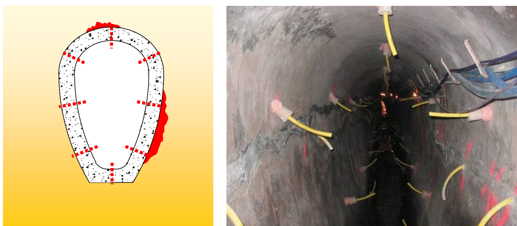
Bild 11 Mörtelinjektionen in einem Sammler mit Eiqerschnitt.
