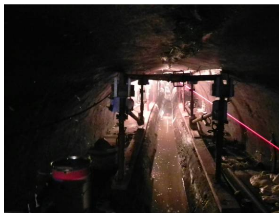
Bild 34 Sicherung über Laststempel (links) und Lasermessungen (rechts)
