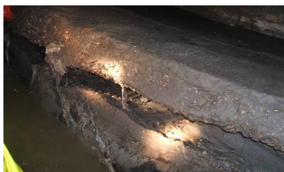
Bild 29 Typische Schadensbilder: Korrosionsschäden und Absackungen mit Schrägstellung (links) und offensichtlichen Ausspülungen im darunterliegenden Bettungsmaterial (rechts)
