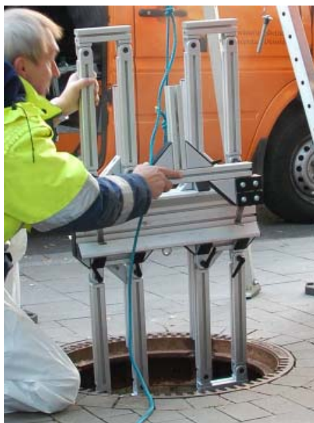
Bild 43 Herablassen der MAC-Prüfeinrichtung (links) und des Scherenarms (rechts) in die Haltung
