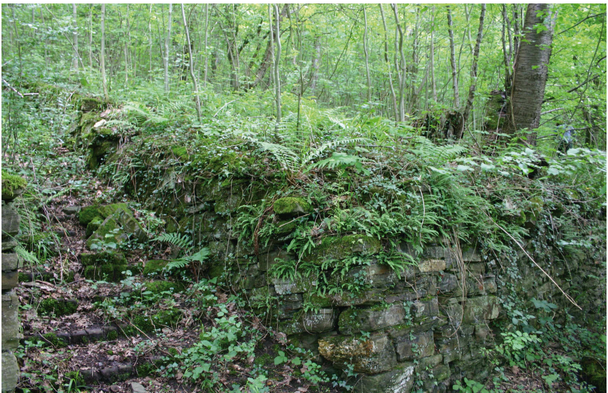
Abbildung 64: Hager Weinberg: Terrassenmauer und teilweise erhaltene Treppe
