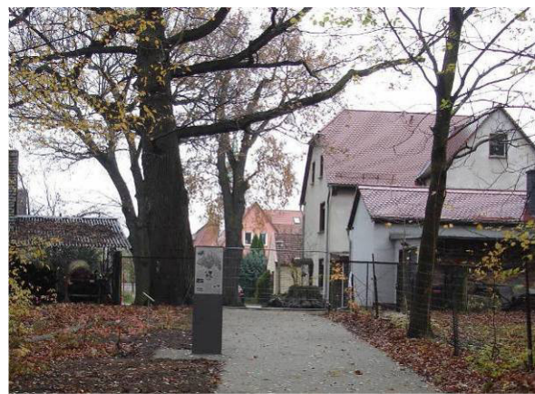
Haupteingang nach Abbruch des Tores, Zustand November 2013 nach Anlage des Weges, der Bauzahn steht noch.
