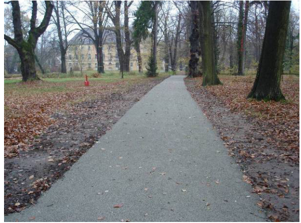
Hauptweg, Blick nach Norden, Zustand November 2013 nach Anlage des Weges.
