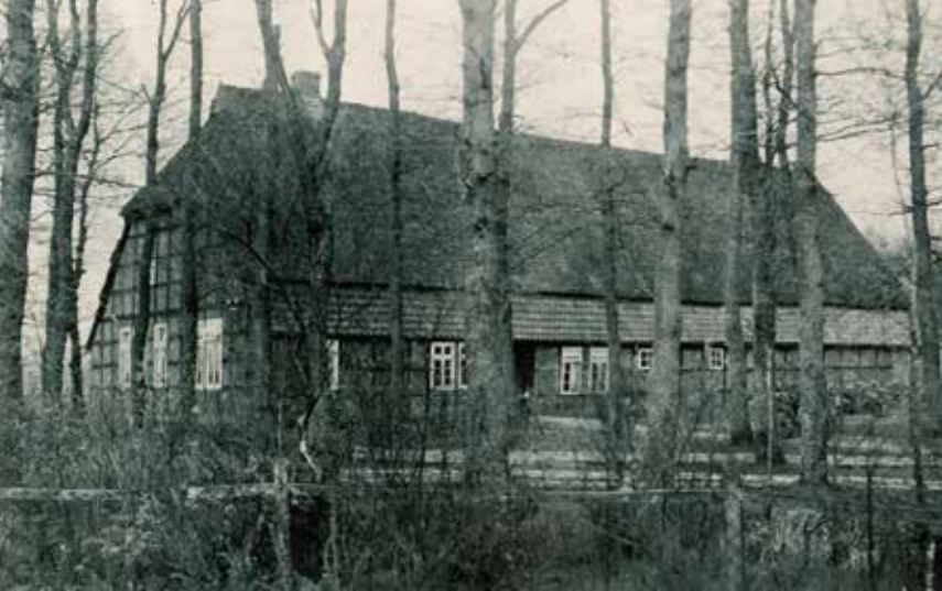
Wetterschutz, Holzreservoir, Futterquelle: Hofgehölze als typische Ausstattung nordwestdeutscher Hofanlagen – seit Generationen, für Generationen.
