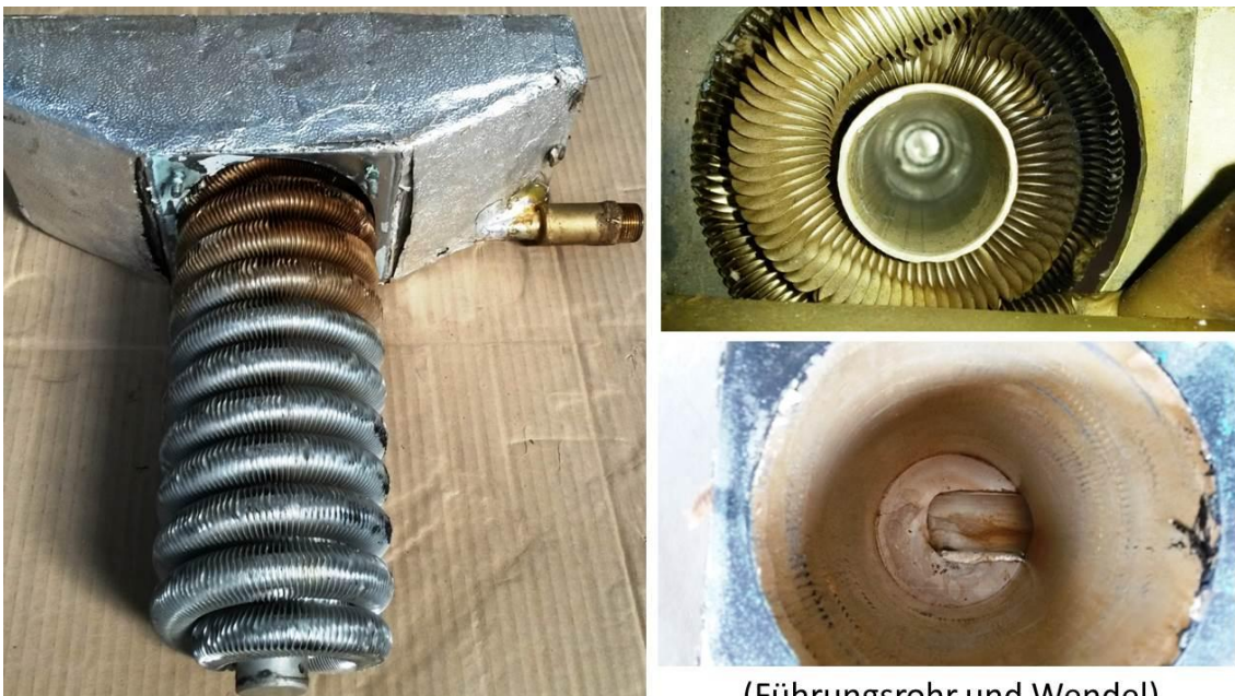
ABBILDUNG 34: RIPPENROHR-BWÜT NACH DER DEMONTAGE
