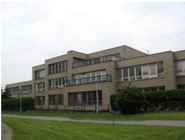
Abbildung 63: Ansicht der Hauptfassade
