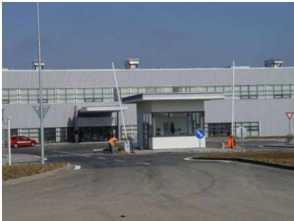
Abbildung 100: Objektansicht der Hauptfront
