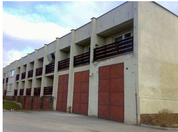
Abbildung 77: Hinteransicht des Gebäudes
