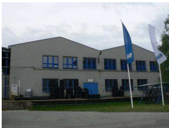
Abbildung 106: Ansicht der Frontfassade –Halle 2
