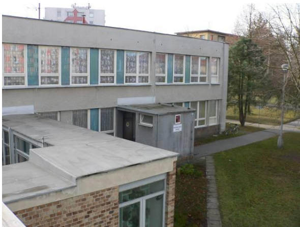
Abbildung 67: Ansicht der Nordfassade
