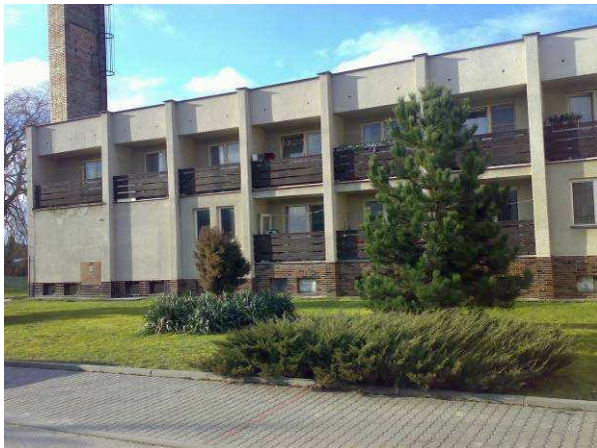
Abbildung 76: Vorderansicht des Gebäudes
