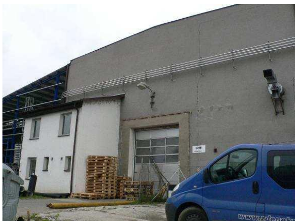
Abbildung 105: Ansicht der Fronfassade - Halle 1
