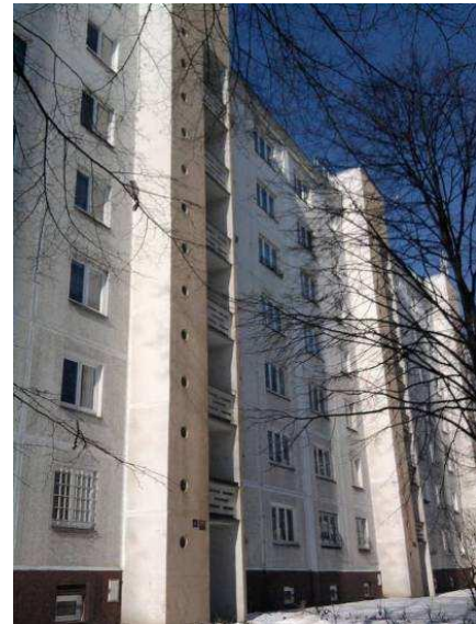
Abbildung 42: Hervorstehende Loggien und Aufzugschächte an der Ostfassade
