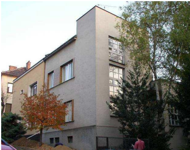
Abbildung 22: Ansicht von der Frontfassade
