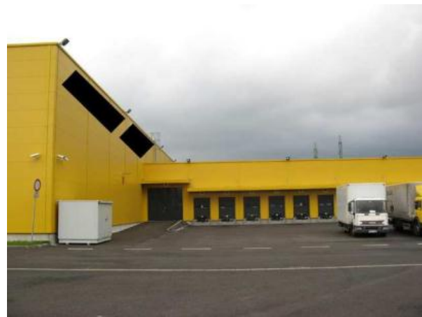
Abbildung 111: Objektansicht des Lagers
