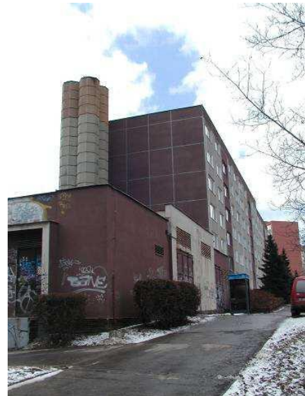
Abbildung 37: Giebelansicht der Fassade und das Zentralkesselhaus
