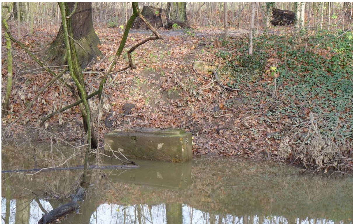
Brücke an der Gärtnerei, Reste der Widerlager am nördlichen Ufer des Altarms der Spree
