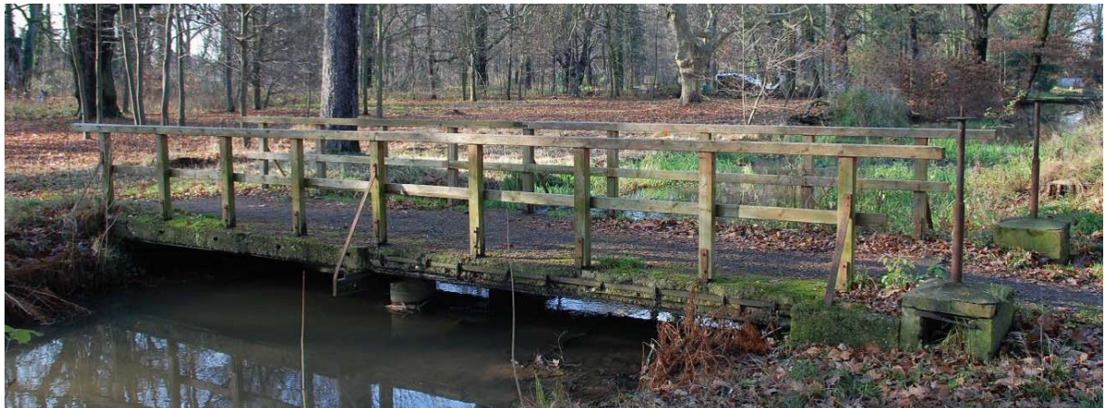
Brücke über den Kanal, Ansicht von Nordosten
