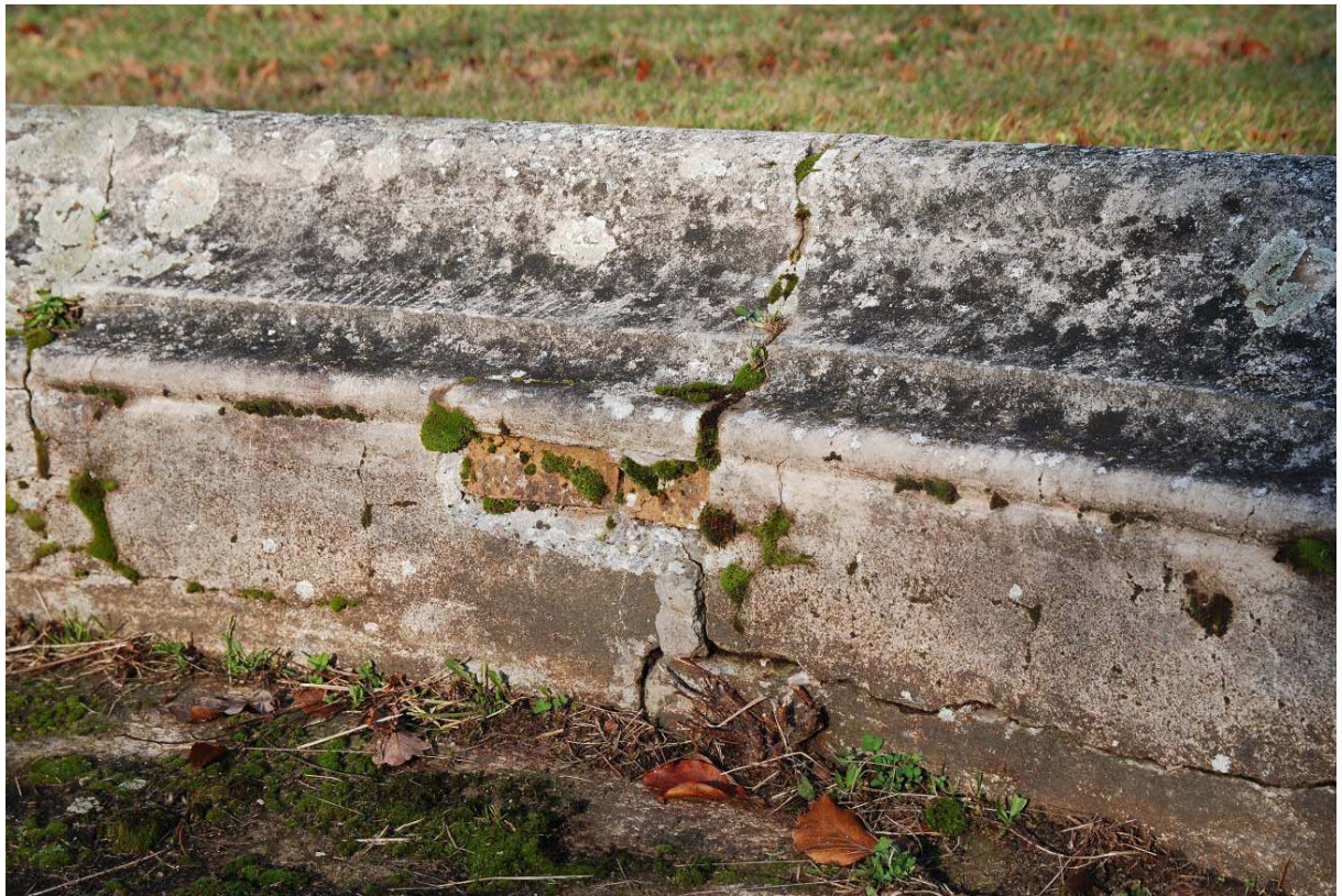
Becken an der Figurengruppe südlich des Schlosses, starke Schäden an der Beckenwand
