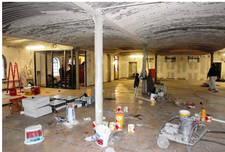
Abb. 6: Herausforderungen oben und unten – Decken- und Bodenarbeiten gleichzeitig
