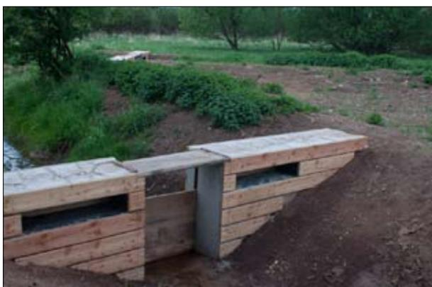
**Abb. 5:** Fertig gestellter variabler Schieber.
