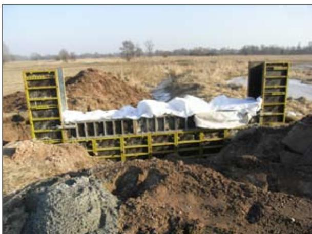
**Abb. 3:** Verschalung für einen variablen Stau.
