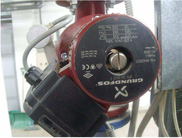
Abbildung 12: Zirkulationspumpe (Bestand)Abbildung 13: Speicherladepumpe (Bestand)
