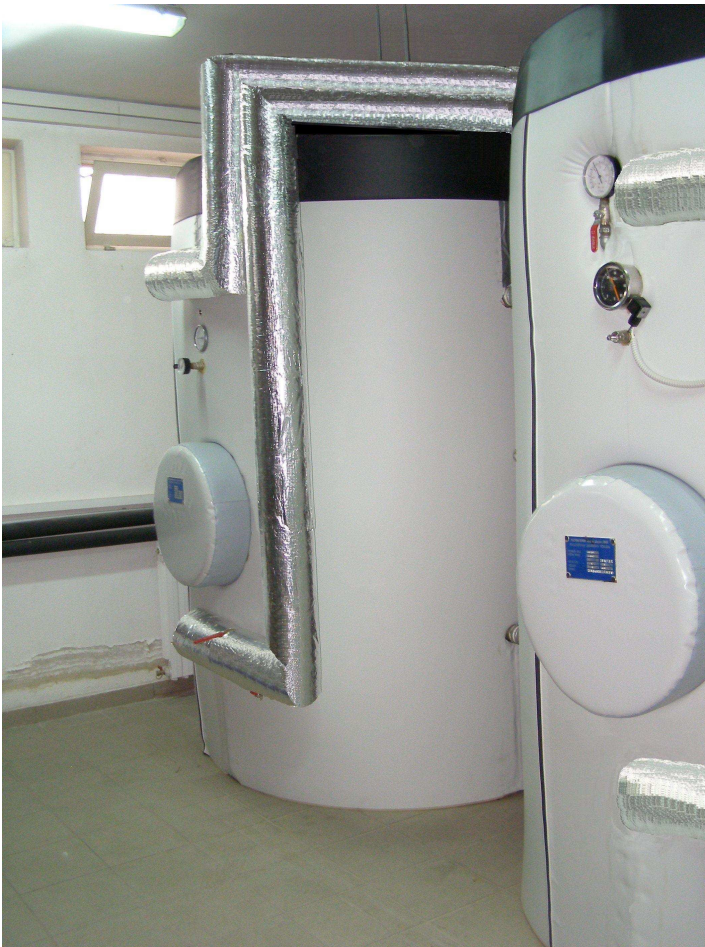
Abbildung 7: nach der Wärmedämmung der Warmwasserspeicher
