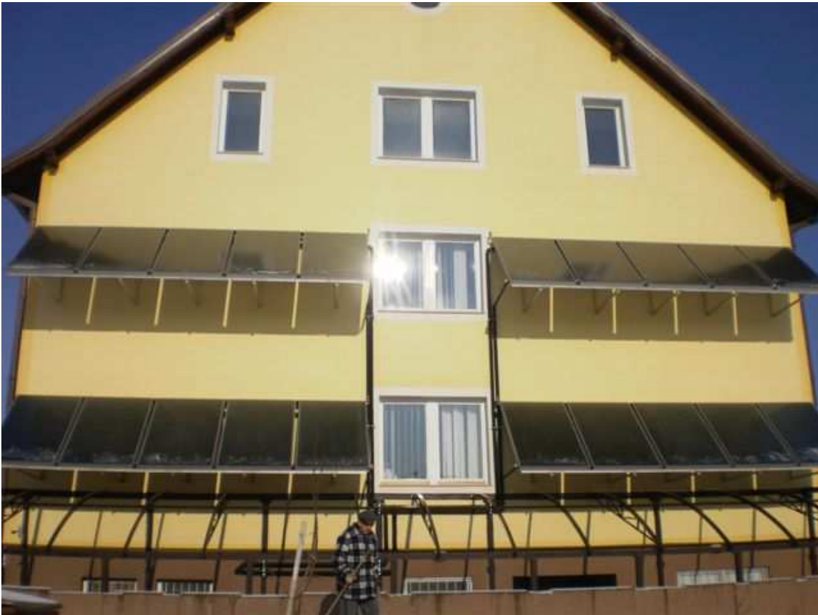
Abbildung 8: Solaranlage Altenheim, direkt nach der Montage
