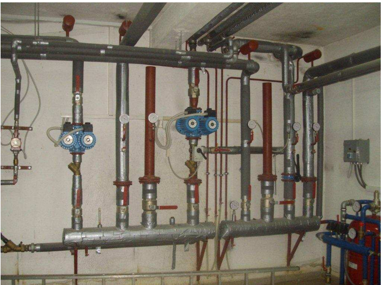
Abbildung 5: Heizungsverteilung im Bestand
