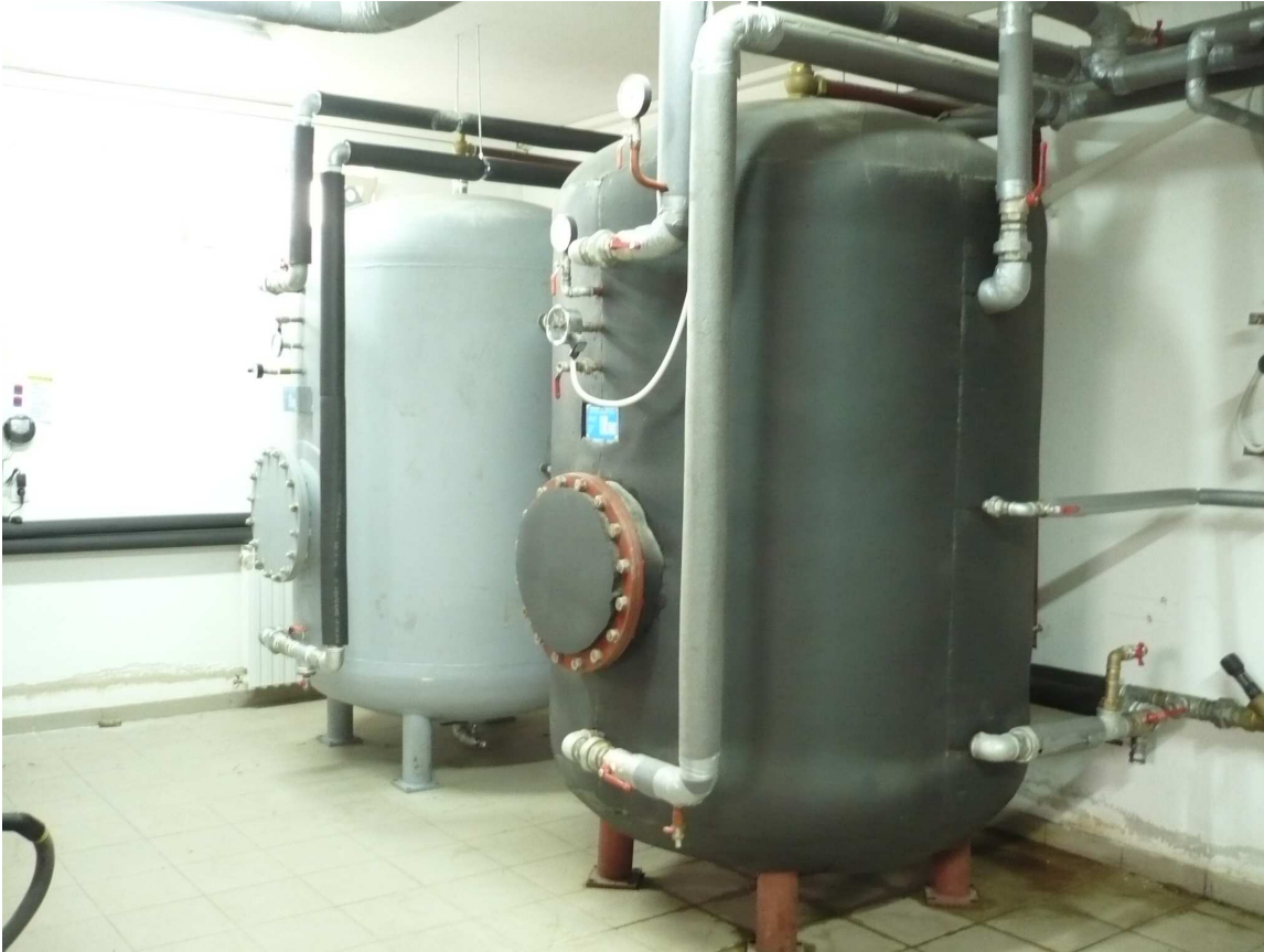
Abbildung 6: direkt nach der Montage des zweiten Warmwasserspeichers
