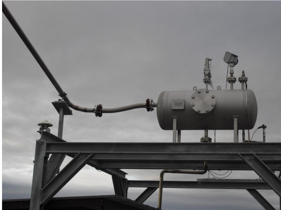
Abbildung 25: Dampftrommel auf Gestell in 3 m Höhe.
