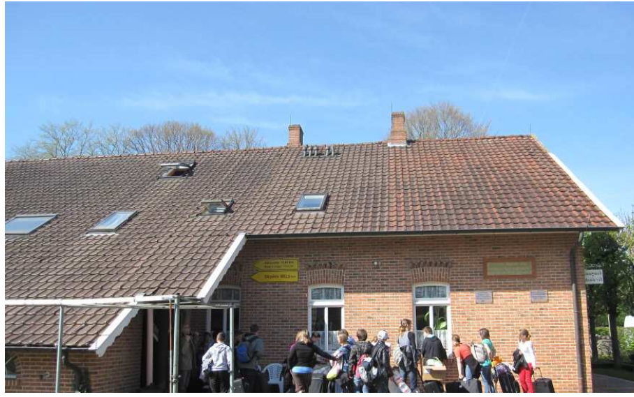
Gebäudefoto Ansicht Nord 2
