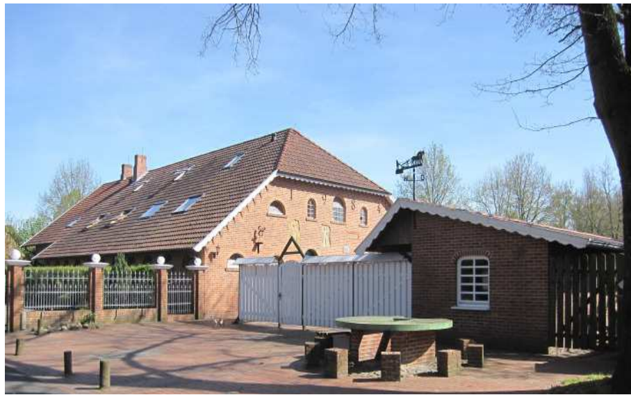
Gebäudefoto Ansicht Süd-Ost
