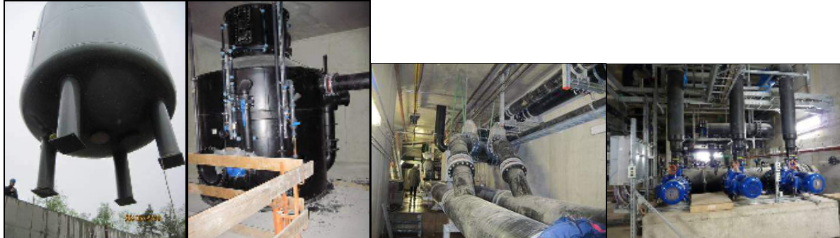
Bild 22: Filtereinbringung in das Technikgebäude
