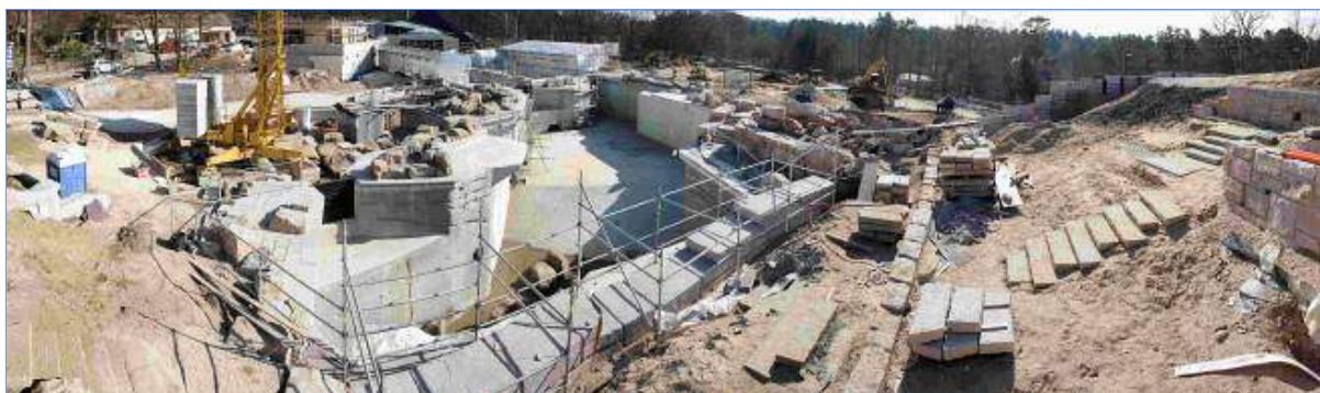
Bild 27: Baustelle Lagune 2009 (Grimm)
