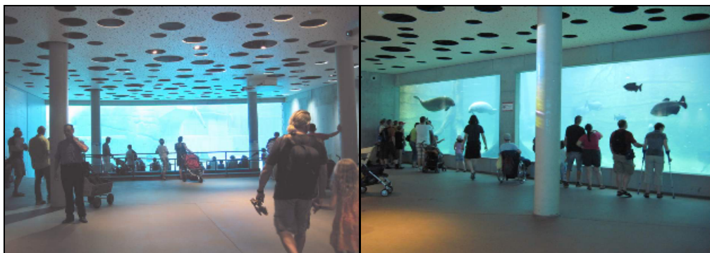
Bild 4: Blauer Salon – Unterwasserverglasungen zum Lagunenbecken
