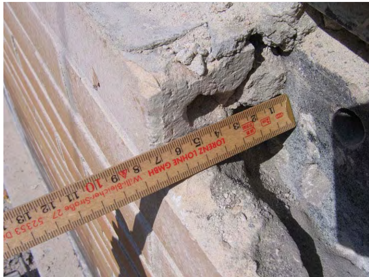
Abbildung 1: Bauteilöffnung: Freilegung der äußeren Schale
