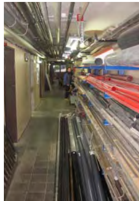
Lagerfläche im Flur
