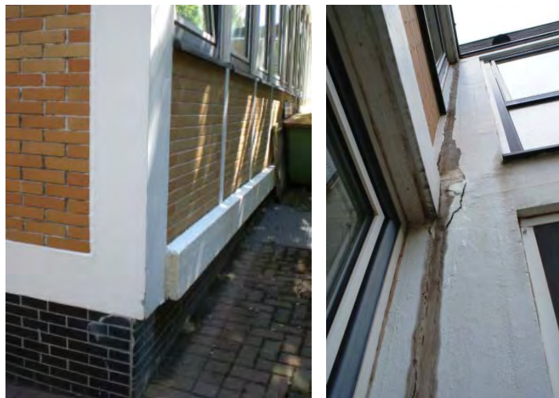
Haus C Gebäudeecke
