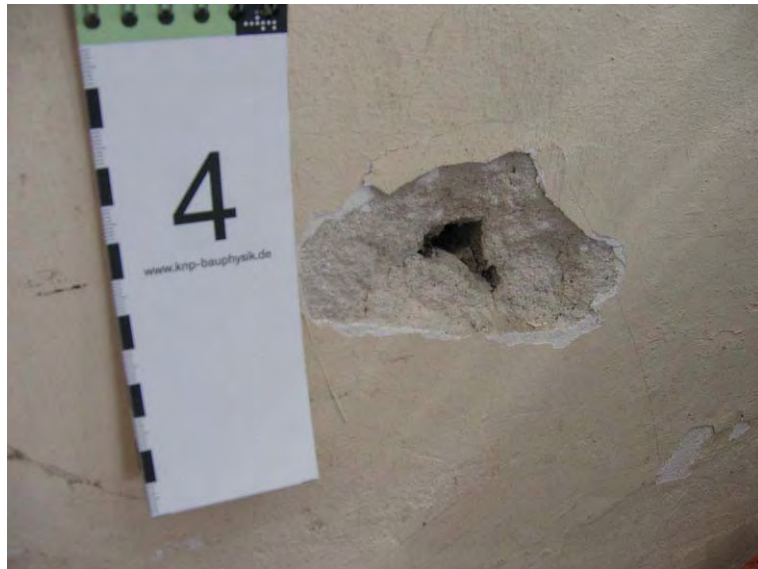
Abbildung 2: Bauteilöffnung: Kernbohrung durch den Gesamtaufbau zur Ermittlung der Aufbaustärken
