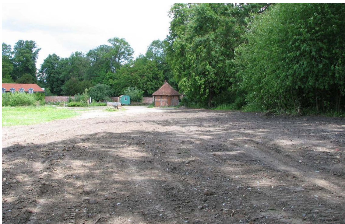
Juni 2009, Beräumung des östlichen Küchengartens durch die AGH-Gruppe und die Firma Hein ist abgeschlossen [Foto: Büro LA Franz]
