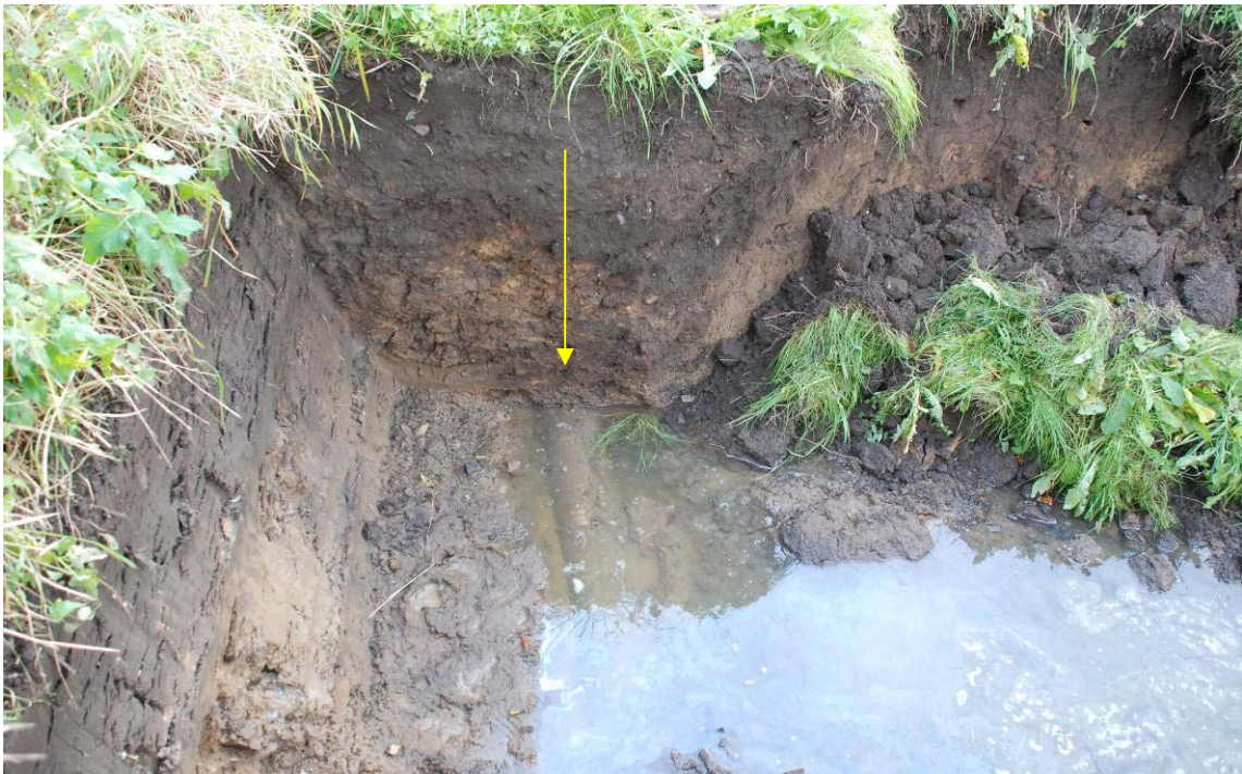
Okt. 2008, Grabungsbefund Betonrohr, in den 1960er Jahren wurde der ehemals offene Entwässerungsgraben verrohrt [Foto: Büro LA Franz]
