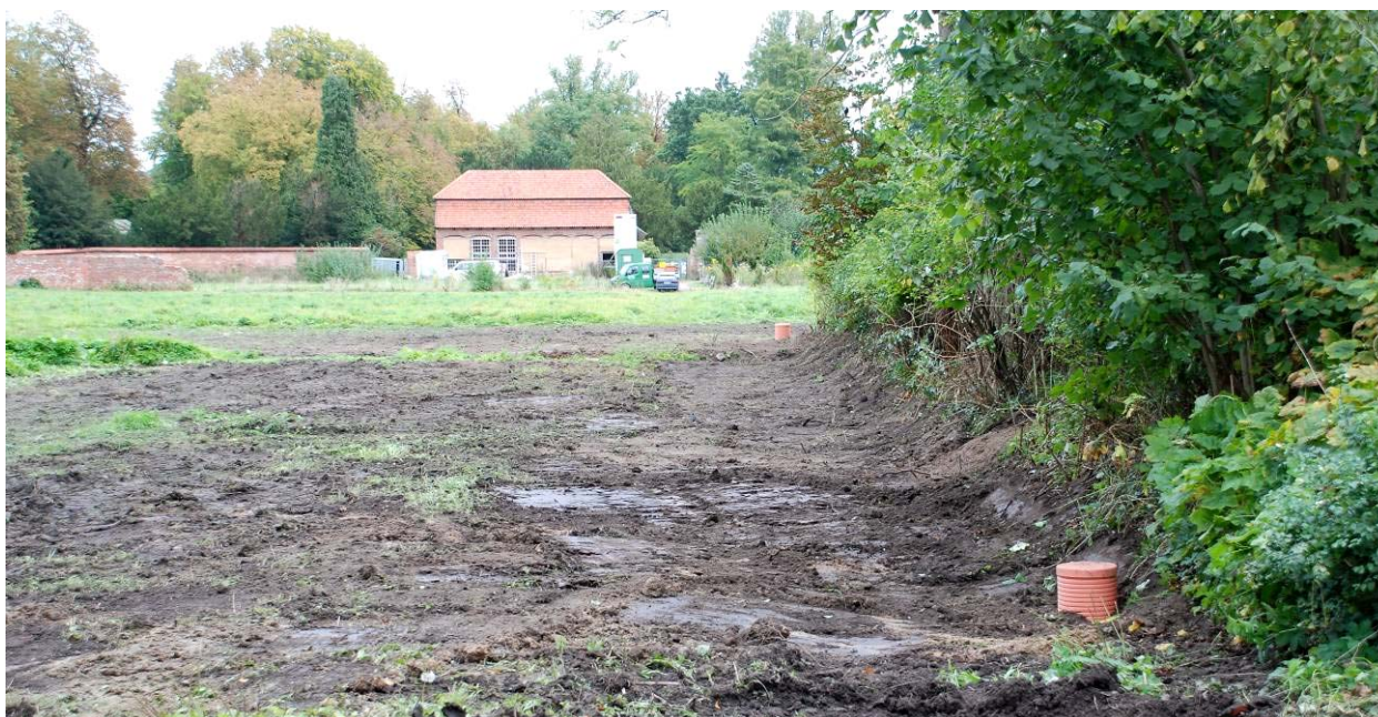
Nov. 2009, Herstellung der Fangdränage am Kleinen Piependiek [Foto: Büro LA Franz]
