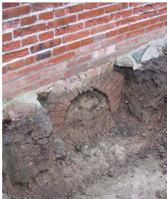
Jan. 2009, Grabungsbefund: Durchlass westliche Küchengartenmauer, vermutlich zum historischen Wassersystem gehörig [Foto: Büro LA Franz]
