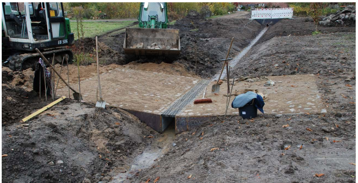
Okt. 2009, Wiederherstellung des historischen Wassergrabens; oben: Pflasterung der Grabensohle mit Katzenkopf-/Rundlingspflaster; unten: Herstellung der „Furt“ [Foto: Büro LA Franz]
