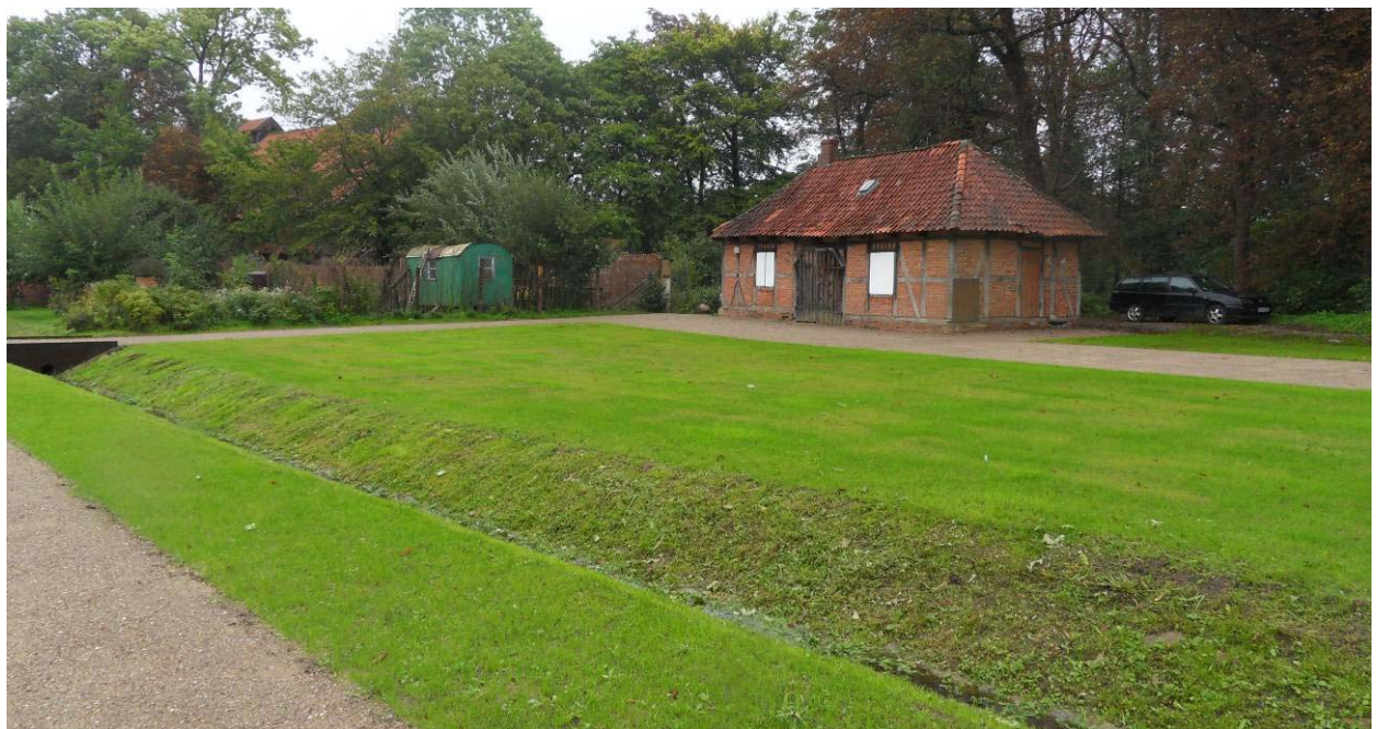
Aug. / Sep. 2010, Wiederherstellung der Wege- und Vegetationsflächen am Entwässerungsgraben / Umfeld Holzhaus [Foto: Büro LA Franz]
