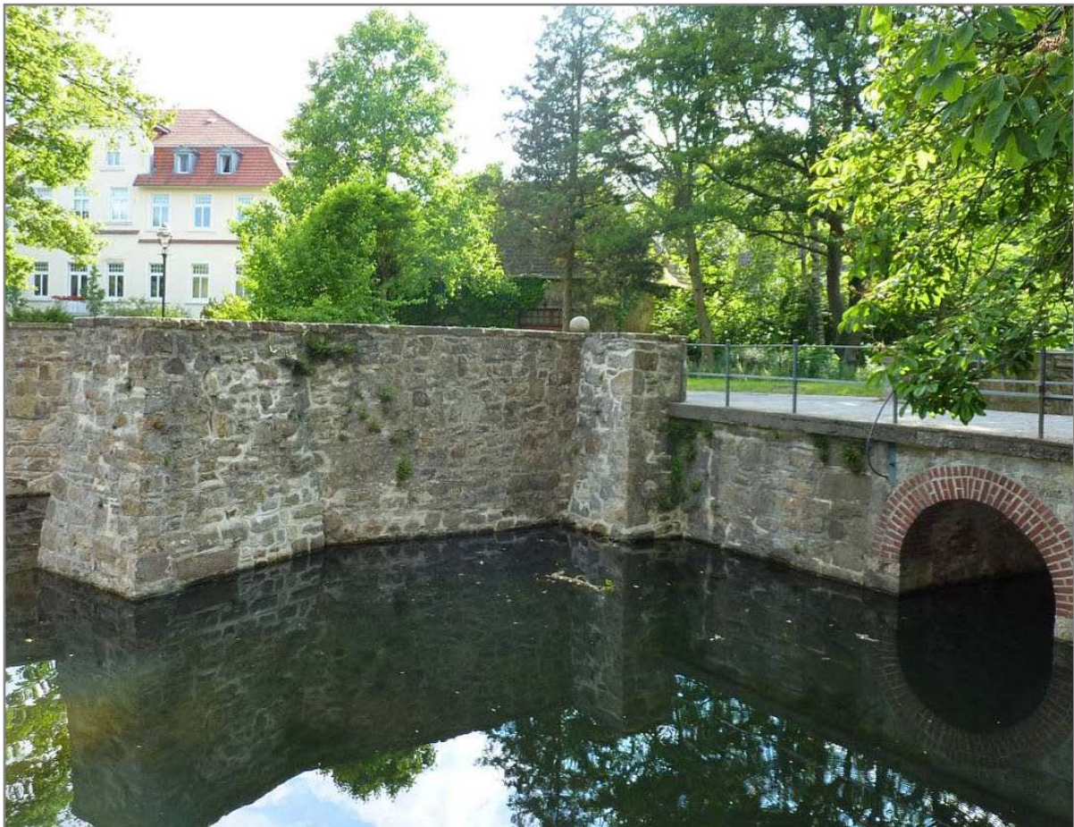
Abb. 15: Abgeschlossene Sanierung des Natursteinmauerwerks bei Schonung der schützenswerten Mauerritzenvegetation
