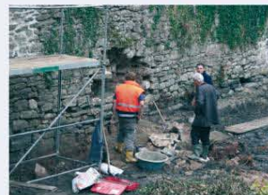
Sanierung des Natursteinmauerwerks unter Schonung seltener Pflanzen
