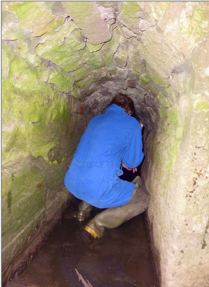
Abb. 11: Überprüfung des Gewölbedurchlasses auf seine Eignung als Fledermausquartier
