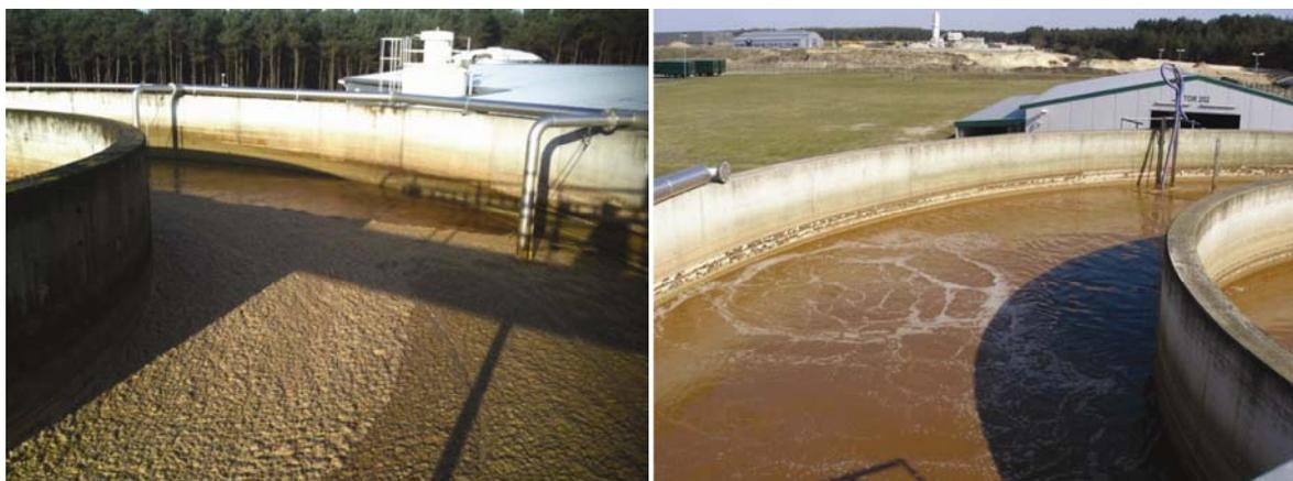
**Abbildung 13: Schaumbildung bei konventioneller Belüftung (links) und Reinsauerstoffbegasung (rechts)**
