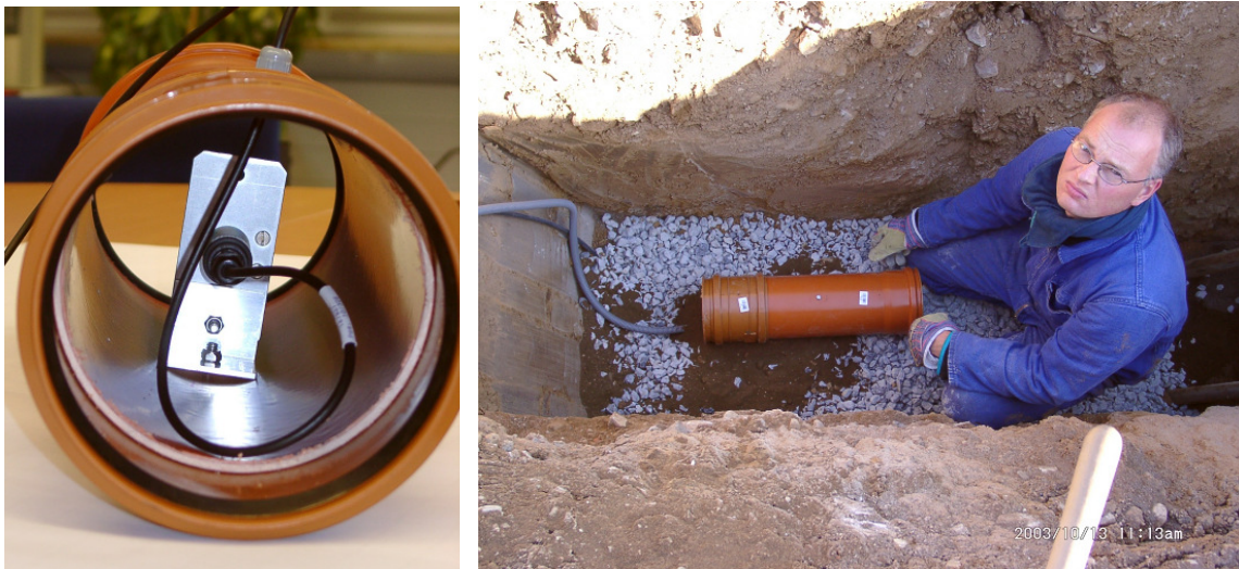
Abbildung 20: Sensor zur Messung der relativen Feuchte im Erdreich. LINKS: Im Kunststoffschutzrohr montierter Sensor. RECHTS: Montage des Sensors im Bereich unter der späteren Bodenplatte, etwa auf Höhe des untersten Fußpunktes der Dämmschürze.
