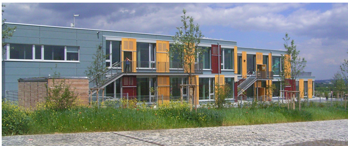
Abbildung 9: Südfassade der KiTa
