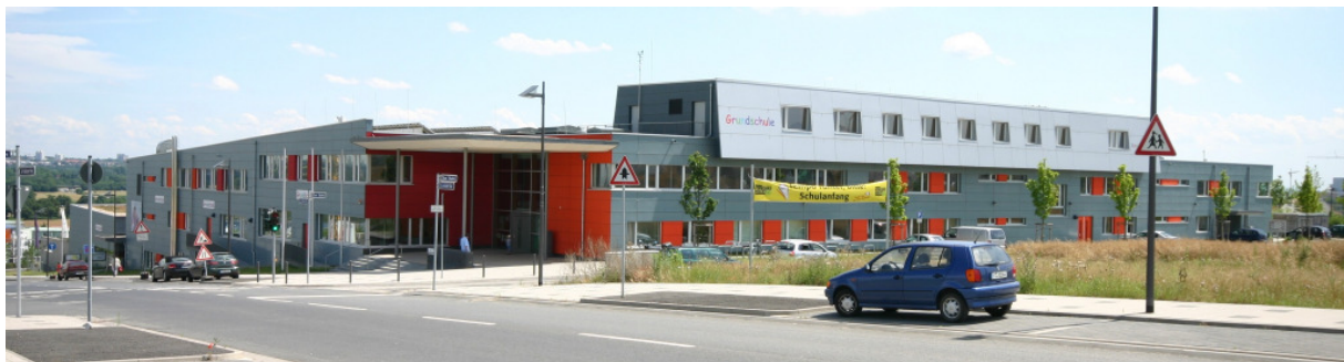
Abbildung 7: Ansicht Nord-West Fassade.
