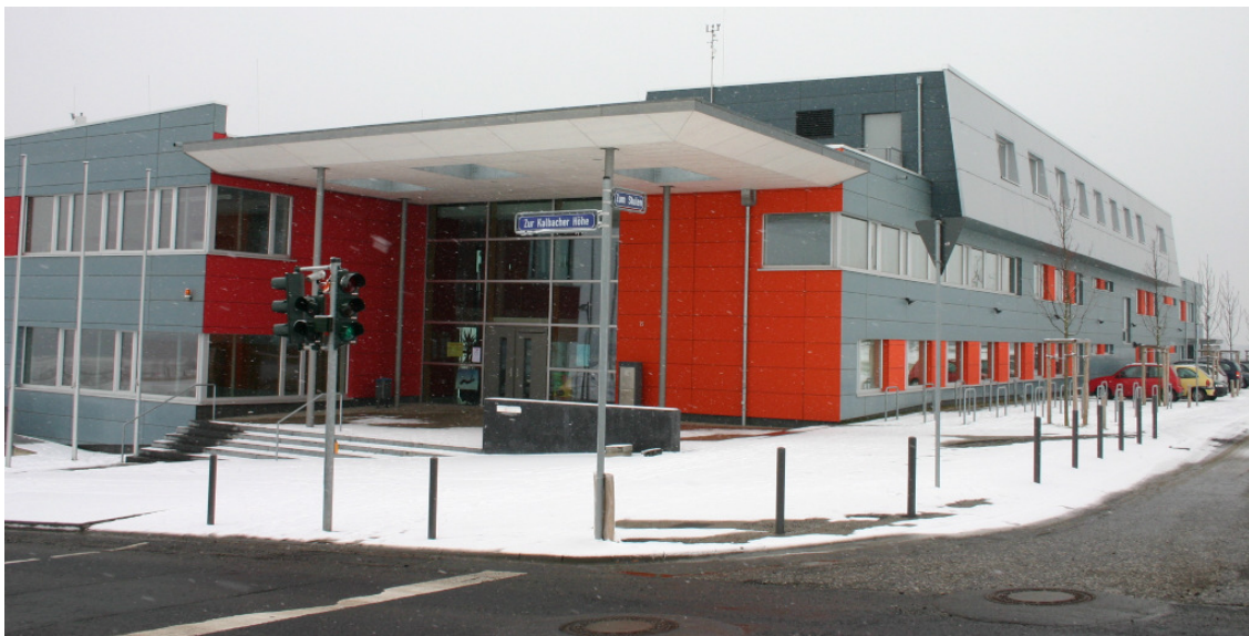
Abbildung 6: Winterliche Ansicht vom Haupteingang (Nord-West).
