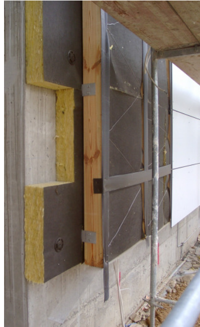
Abbildung 12: Aufbau der vorgehängten Fassade mit zweilagigem Dämmstoff.
