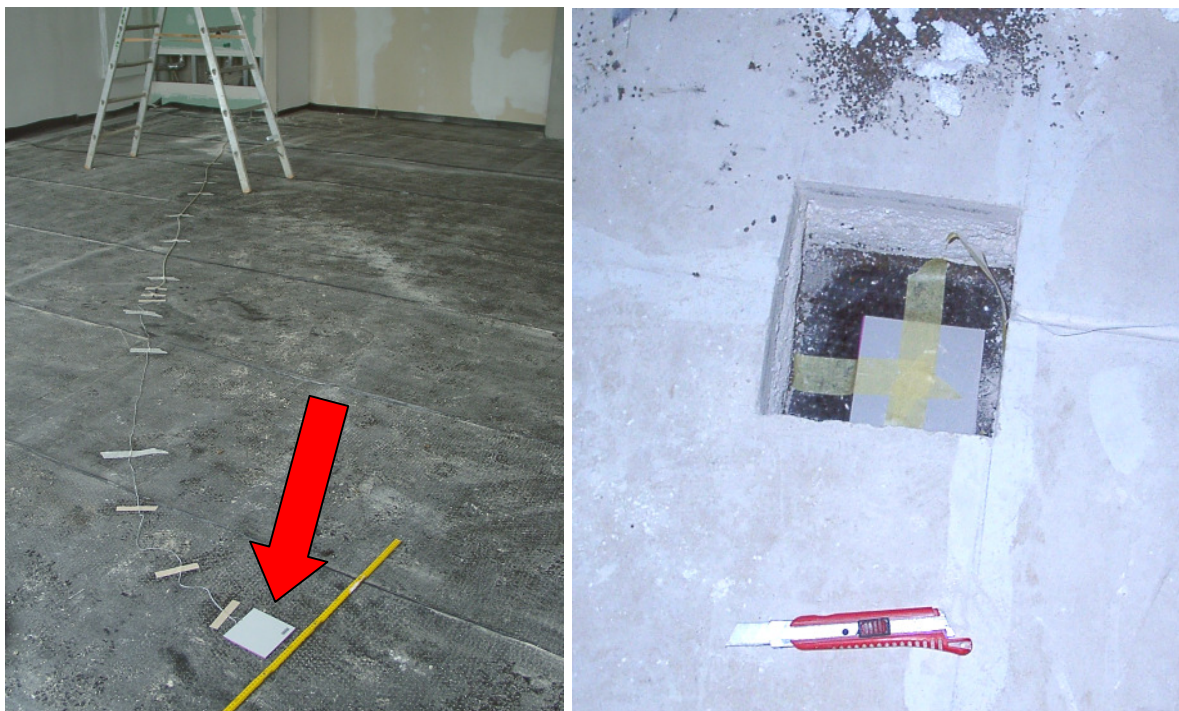
Abbildung 23: Montage der Wärmestrommessplatten in Raum 0.3 (vor dem Einbringen der Dämmung) und im Bodenaufbau im Flur vor Raum 0.3.
