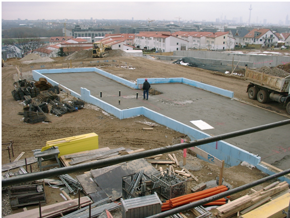
Abbildung 14: Verlängerung der Dämmschürze im Bereich der KiTa. Die Sauberkeitsschicht ist bereits fertiggestellt.
