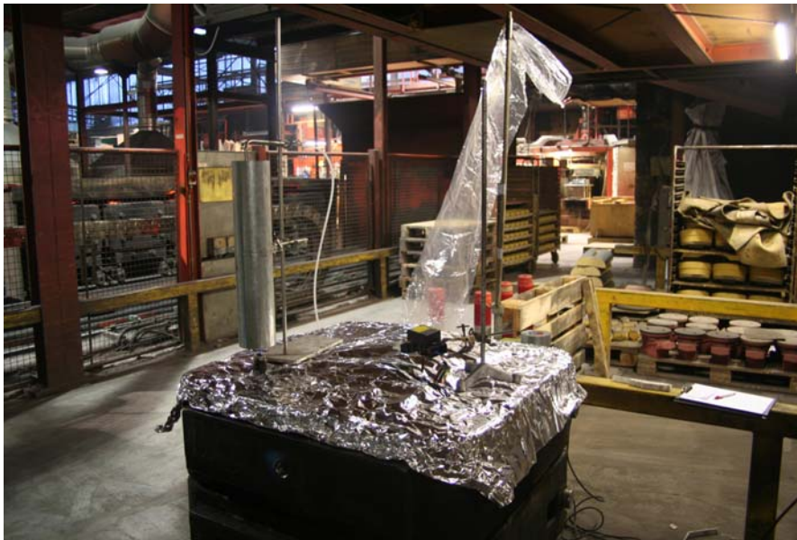
Abbildung 29: Hochspannungszündvorrichtung in einer Eisengießerei an einer automatisch geformten Grünsandform
