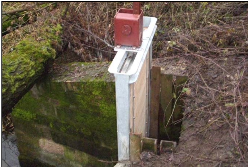
Die erneuerte Stau- tafel am Großen Streng
