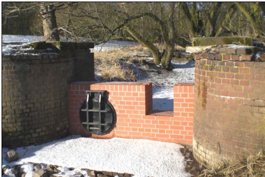
Neugeschaffene „Staumauer mit Rückschlagklappe“
