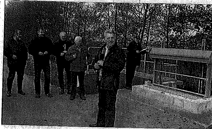
Klaus Behncke, Vorstandsvorsteher vom Wasser- und Bodenverband kurbelt das Schott im umgebauten Wehr hoch, und gibt somit die ökologische Durchgängigkeit frei.
