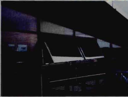
Natürliche geregelte Lüftung über Fensterflügel
