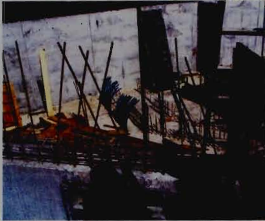
Schlauchenden der Erdsonden
