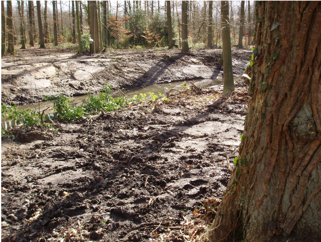
Abb. 22: Einplanieren der Ablagerungen aus dem Mühlenzulauf (Gauxbach) im Umfeld des Gewässers
