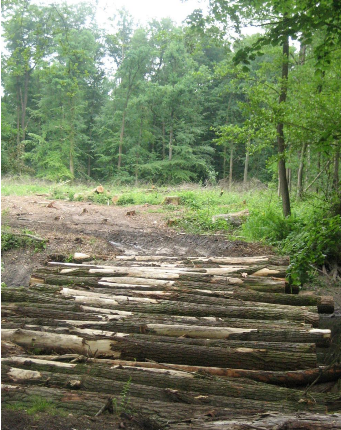
Abb. 29: Geräumte Bleiche mit temporärer Zufahrt (Knüppeldamm)
