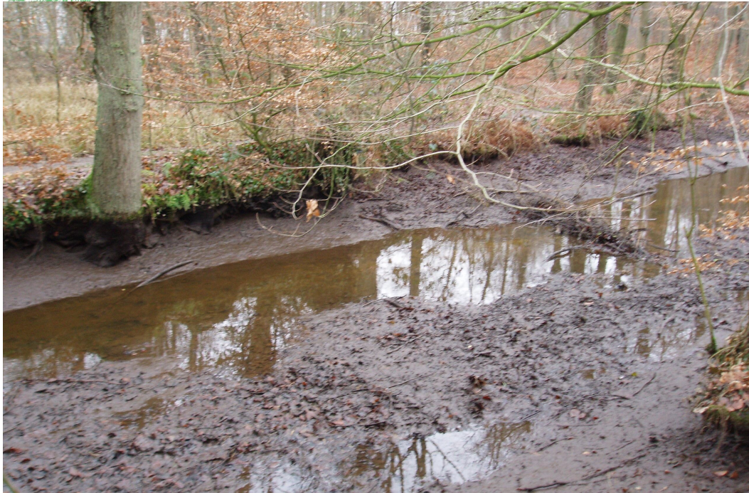
Abb. 20: Ablagerungen im Mühlenzulauf (Gauxbach); erkennbar, dass die wirk- same Wassertiefe bis auf 30 bis 40 cm geschrumpft war
