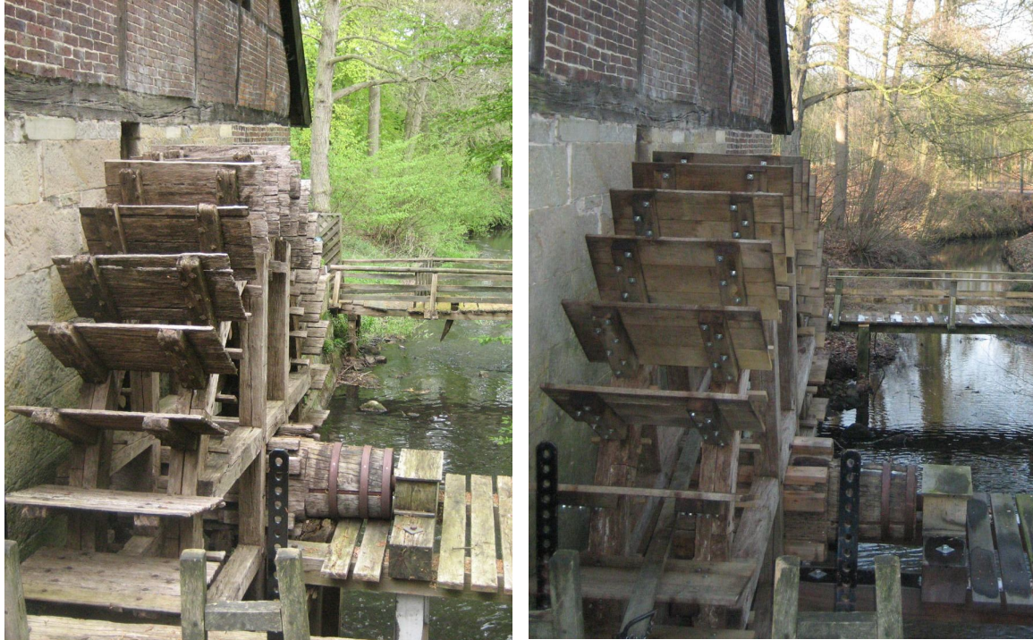
Abb. 38/ 39: Vergleich des alten (links) mit dem neu hergerichteten Mühlrad aus einer anderen Perspektive als in den vorherigen Kapiteln
