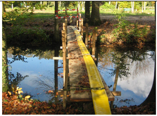
Verlegung der Pumpleitung über den Gauxbach, um so das Spülfeld zu erreichen
