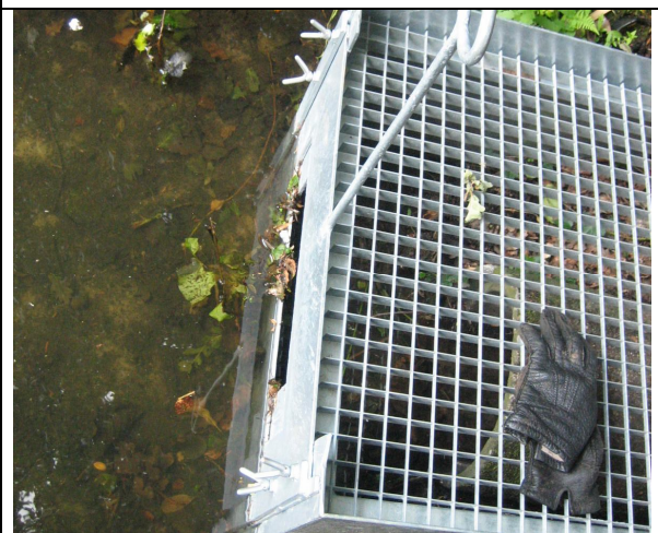
Neuer Notüberlauf der Hausgräfte; nachdem hier früher keine Steuerung vorhanden war, kann überschüssiges Wasser jetzt ohne Weiteres zum Gauxbach ablaufen
