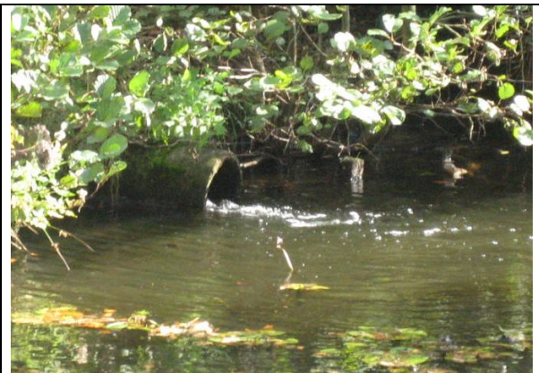
Nachfluss in die Hausgräfte aus dem Gauxbach, hier während der Entschlammung
