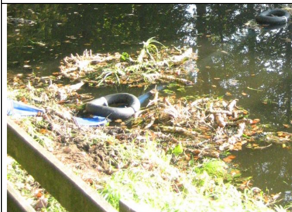
Aufschwimmende Rhizome während der Entschlammung; die Reifen sind kein Müll, sondern sind Schwimmer für die Saugleitung des Schwimmbaggers
