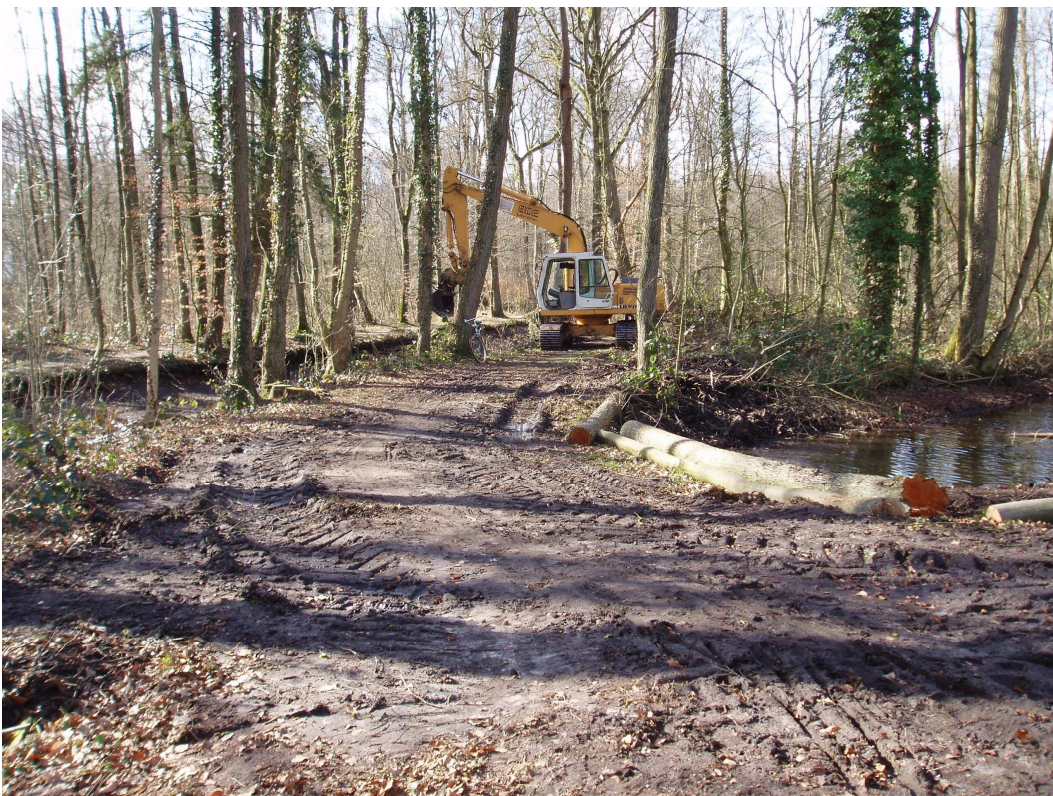
Abb. 21: Entnahme der Ablagerungen aus dem Mühlenzulauf (Gauxbach)
