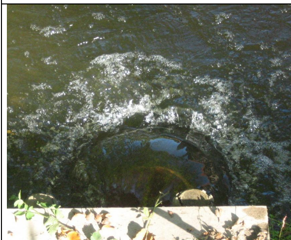
Heutiger Zufluss zur Hausgräfte bei geöffnetem Schieber; es ist gut erkennbar, dass der Pegel der Schlangengräfte deutlich über dem der Hausgräfte liegt
