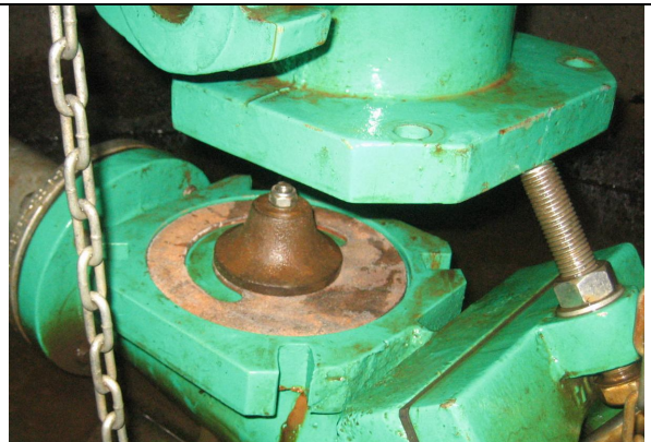
Hubventil zum Windkessel, hier die richtige Ventildichtung, nachdem mit dem Hersteller ein Jahr lang verhandelt werden musste
