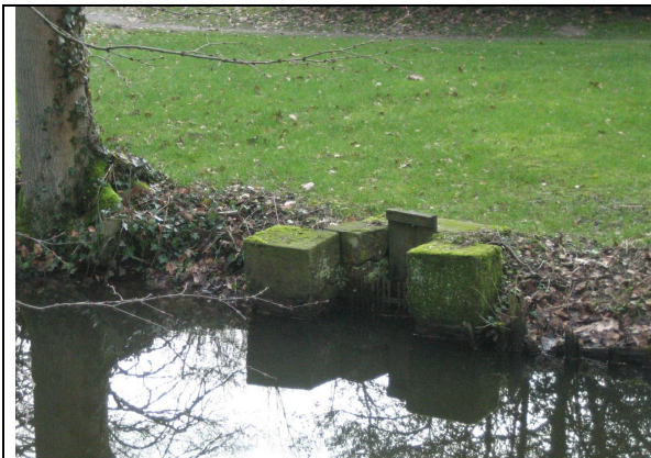
Entnahmestelle aus dem Gauxbach zur Speisung der Hausgräfte vor der Maßnahme
