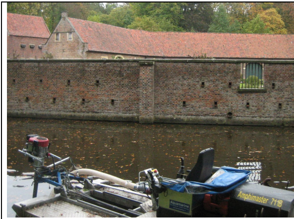
Schwimmbagger auf der westlichen Hausgräfte; links im Bild erkennbar der Saugaufsatz
