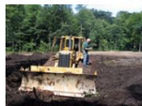
Eine Planierraupe arbeitete sich am Dienstag durch die Bleiche. Sie erhält ein Profil mit einigen Mulden. Fotos: A. Löbbe
