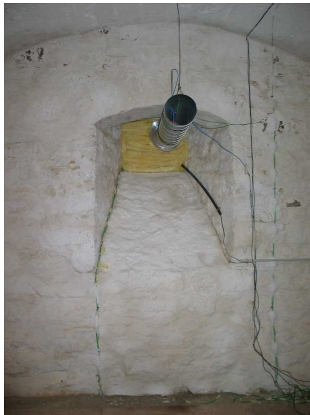
Bild 4.3-2: Lichtschacht zur Einführung des Nahwärmerohrs während der Bauphase
