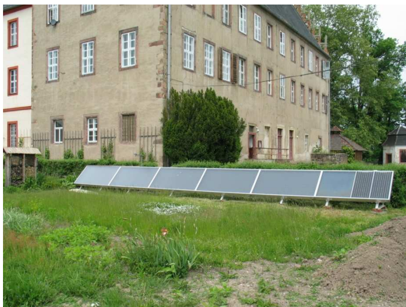
b) Ansicht von Süd-Osten
