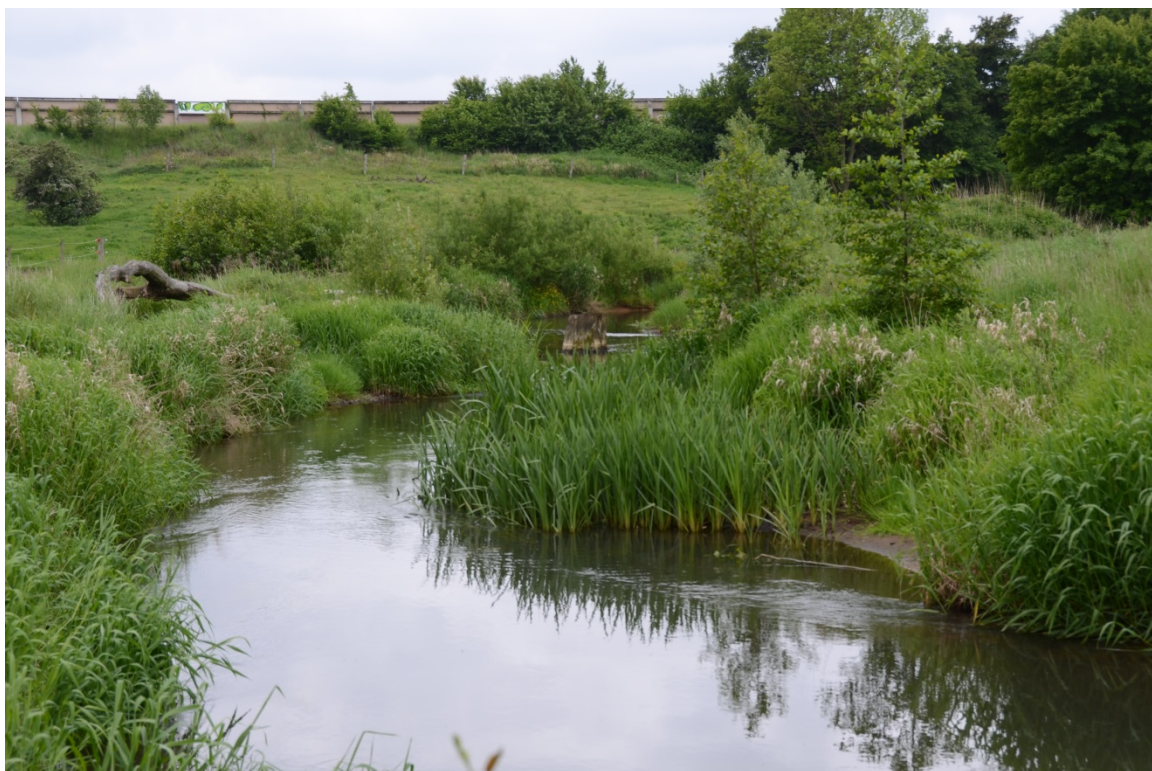
Abb. 14: Neu angelegter Schunterlauf direkt oberhalb der BAB 2 (Foto: M. Lehmann).
