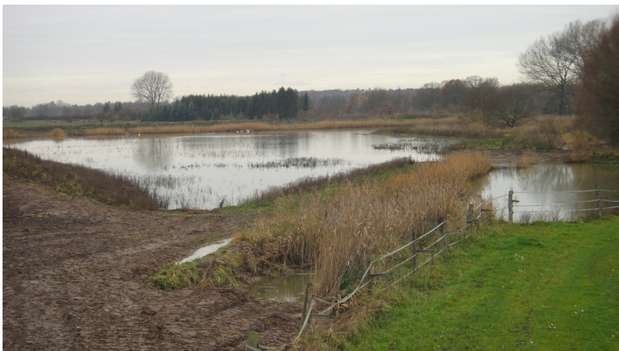
Abb. 13: Oberbodenabtrag im am oberen Ende der Flutrinne 2NFT süd-östlich Hondelage (Foto: M. Lehmann).
