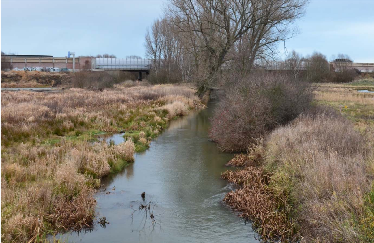
Abb. 11: Profilaufweitung bis MW im Uferbereich der Schunter unterhalb der BAB 2 (Foto: M. Lehmann).
