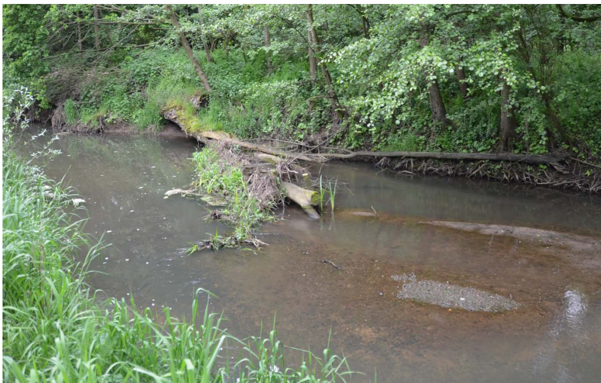
Abb. 9: Eingbrachtes Totholz in der Schunter bei Wendhausen (Foto: M. Lehmann).
