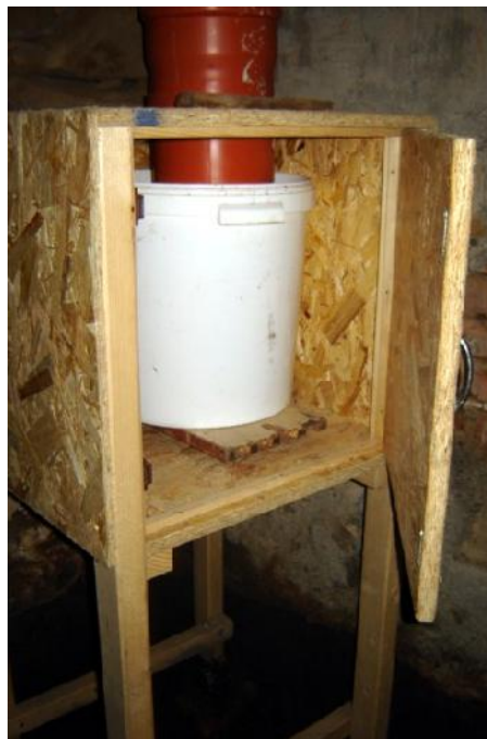
Abbildung 10: TTC Mineral – Standort Tirhas, die Toilette befindet sich in einem neu gebautem Toilettenraum im Gebäude, rechts der Sammelbehälter im Keller
