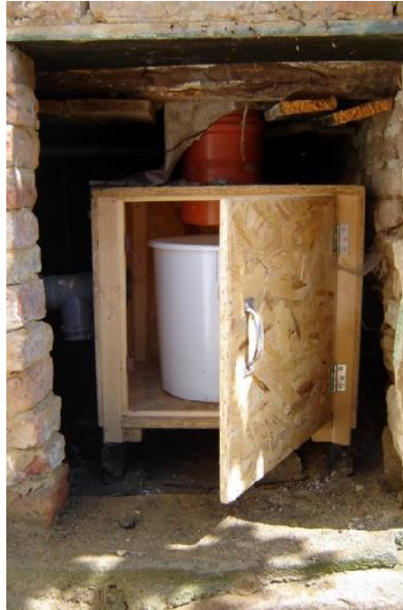
Abbildung 9: TTC Mineral – Standort Subtirel, die Toilette befindet sich in der offenen Veranda des Gebäudes, rechts der Sammelbehälter unter dem Fußboden
