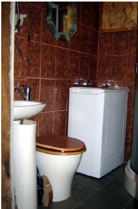
Abbildung 8: TTC Mineral – Standort Maior, die Toilette befindet sich in der zum Bad umgebauten Veranda des Gebäudes, rechts der Sammelbehälter direkt unter dem Fußboden
