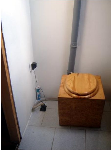
Abbildung 11: TTC Holz – Standort Cotaru, die Toilette befindet sich im Baderaum, 1.OG, der Sammelbehälter befindet sich im Toilettenstuhl
