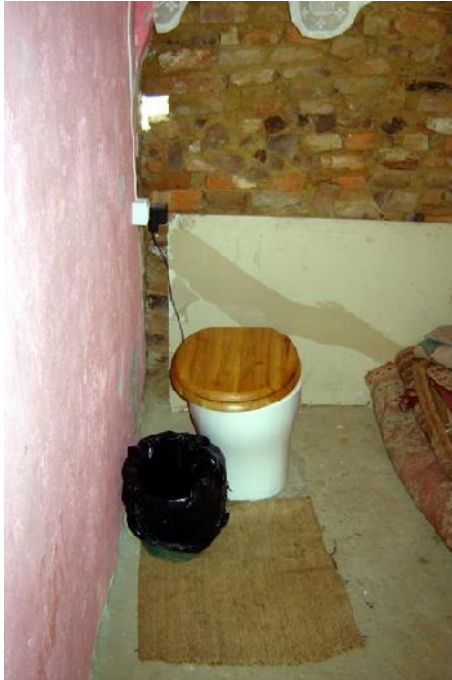
Abbildung 9: TTC Mineral – Standort Subtirel, die Toilette befindet sich in der offenen Veranda des Gebäudes, rechts der Sammelbehälter unter dem Fußboden
