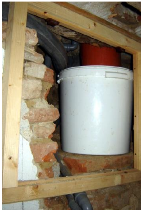
Abbildung 8: TTC Mineral – Standort Maior, die Toilette befindet sich in der zum Bad umgebauten Veranda des Gebäudes, rechts der Sammelbehälter direkt unter dem Fußboden
