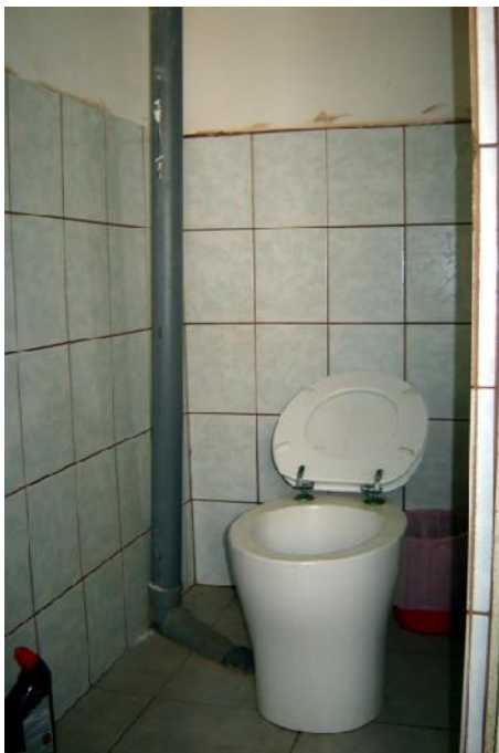
Abbildung 10: TTC Mineral – Standort Tirhas, die Toilette befindet sich in einem neu gebautem Toilettenraum im Gebäude, rechts der Sammelbehälter im Keller
